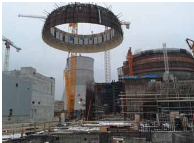
ЛАЭС-2, установка купола реактора
