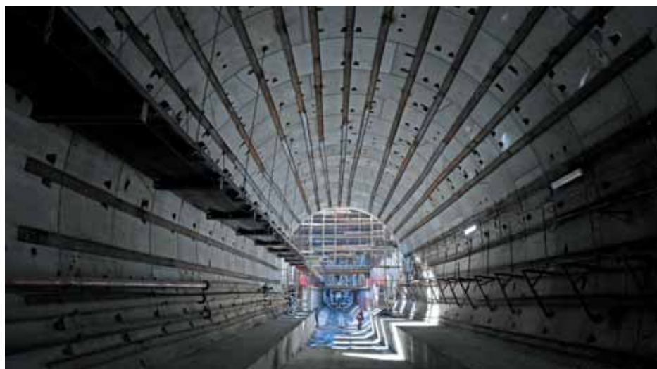
Строительство станции «Мневники» БКЛ
