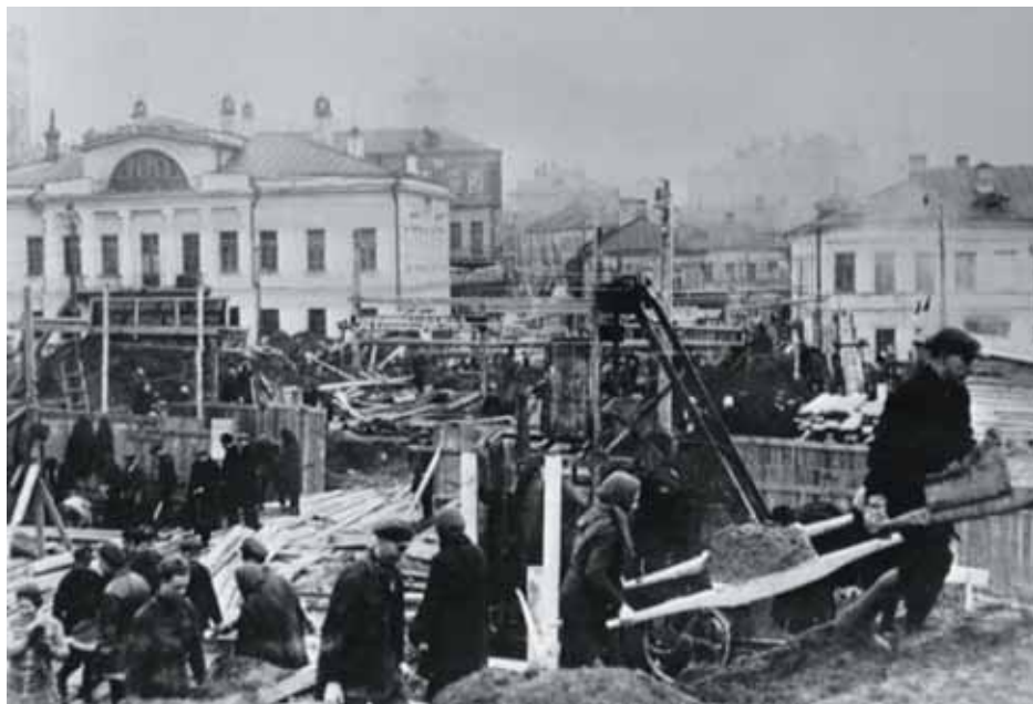
Рис. 2. Строительство 1-й линии Московского метрополитена
