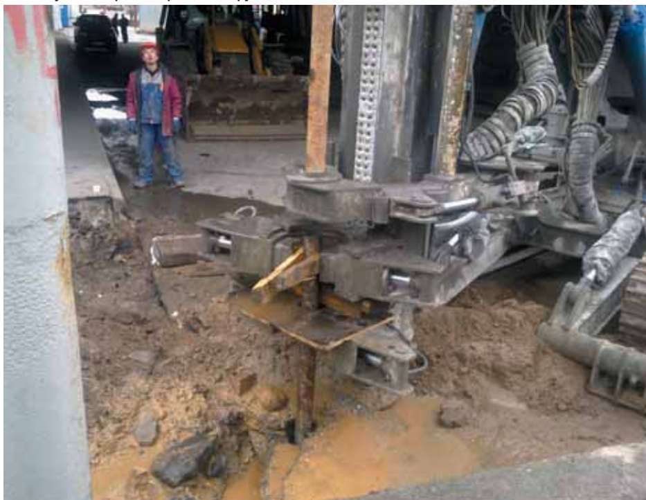
Излив пульпы в процессе работ по струйной цементации
