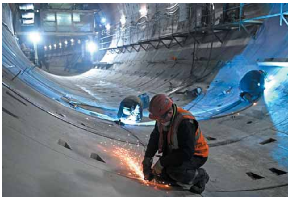
Работы в перегонном тоннеле станции «Печатники» БКЛ
