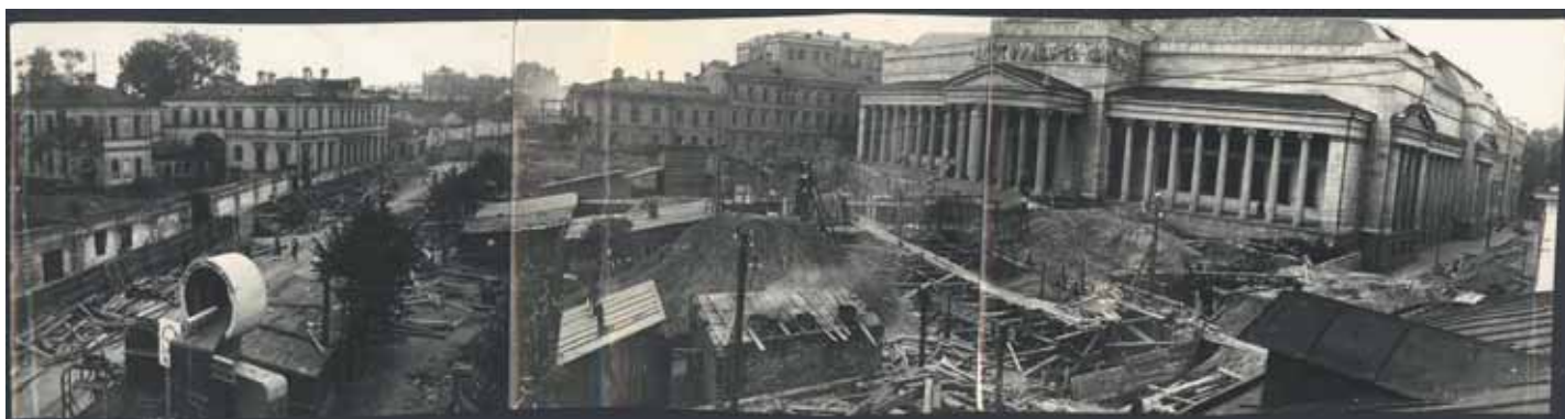
Рис. 3. Строительство 1-й линии Московского метрополитена напротив здания музея
