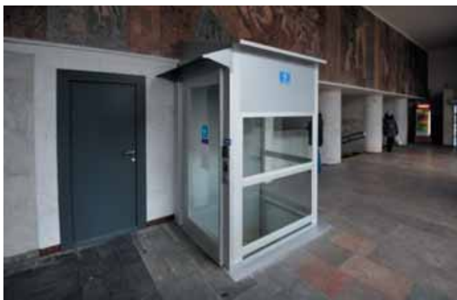
Рис. 2. Вертикальный подъемник на станции метро «Октябрьская» ( https://realt.onliner.by/2016/02/05/metro-podemnik?amp=1 )
