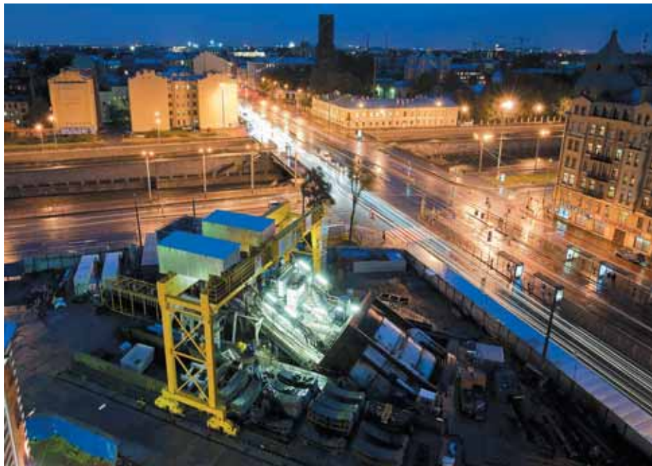
ТПМК «Аврора», 2009 г.
