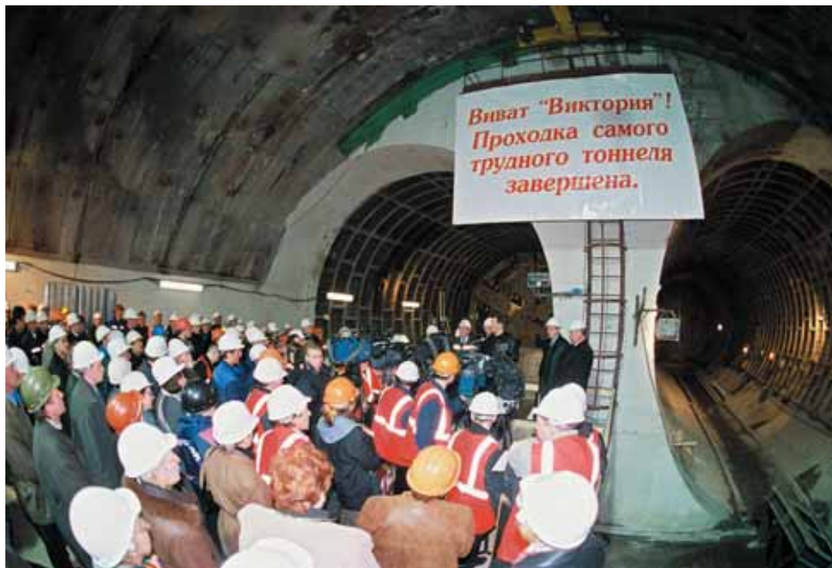
Окончание проходки первого тоннеля, май 2004 г.
