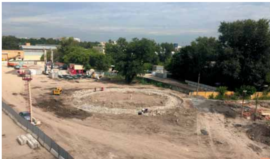
Вид на котлован диаметром 31 м до разработки грунта, закрепленный по периметру буровескучи-мисы сваями
