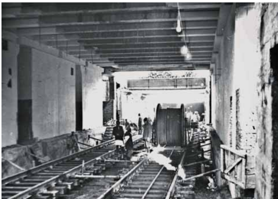
Рис. 4. Тоннель Сокольнической линии метрополитена
