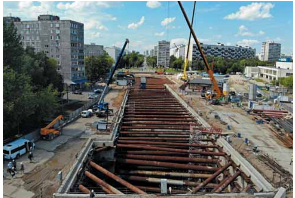
Рис. 3. Вид на котлован строящейся станции метро «Юго-Восточная» и перспективу Некрасовской линии метрополитена
