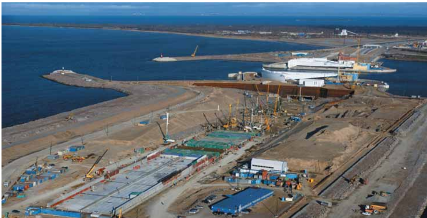
Строительство Комплекса защитных сооружений, 2009 г.
