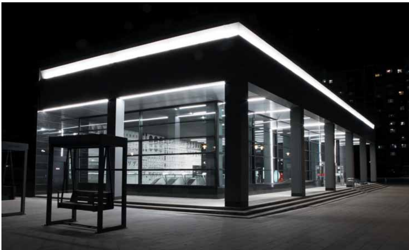
Внешний вид наземного павильона
