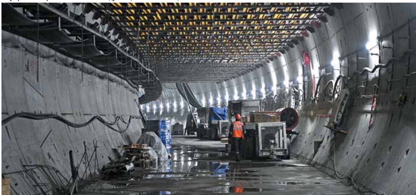
Обустройство перегонного тоннеля между станциями «Текстильщики» и «Печатники» БКЛ
