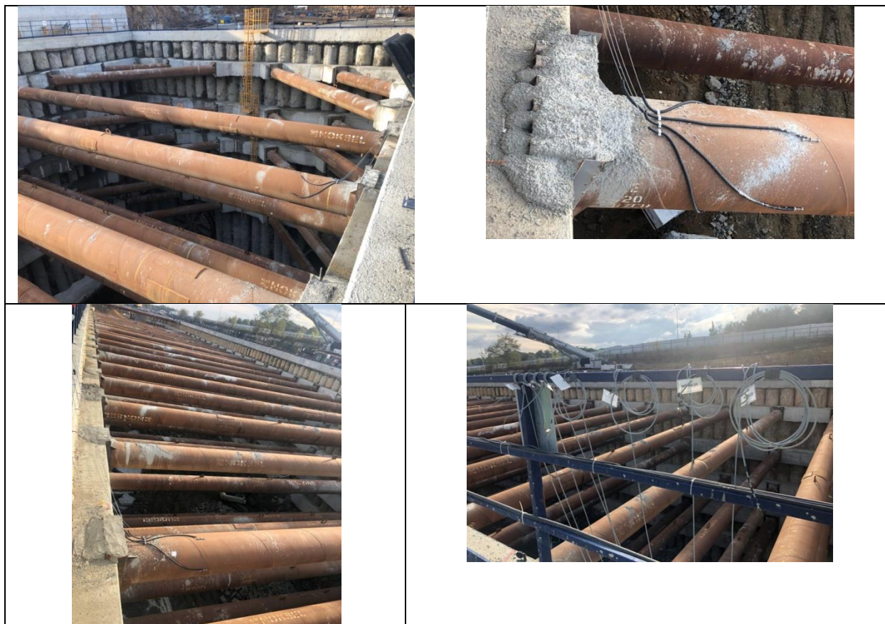
Рис.1 Оснащение расстрельной системы котлованов датчиками в Турции, г. Стамбул
