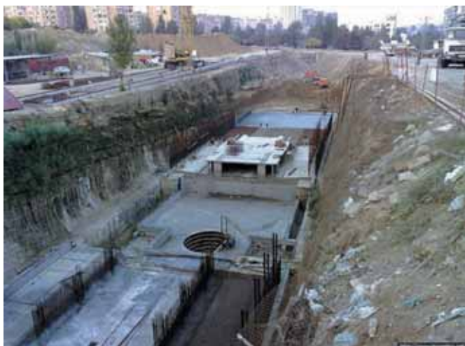
Котлован станции «Азадлыг проспекти»
