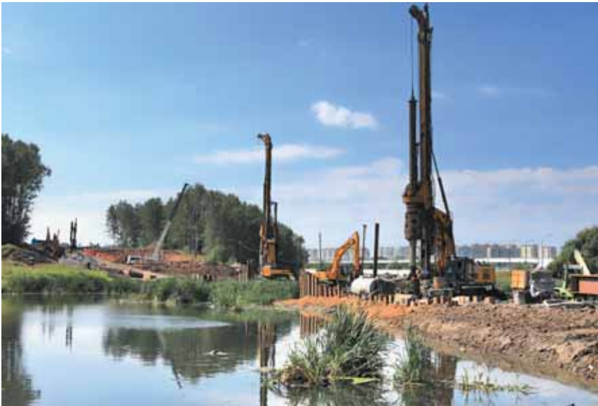
Строительство метромоста через реку Ликова на станции «Пыхтино»
