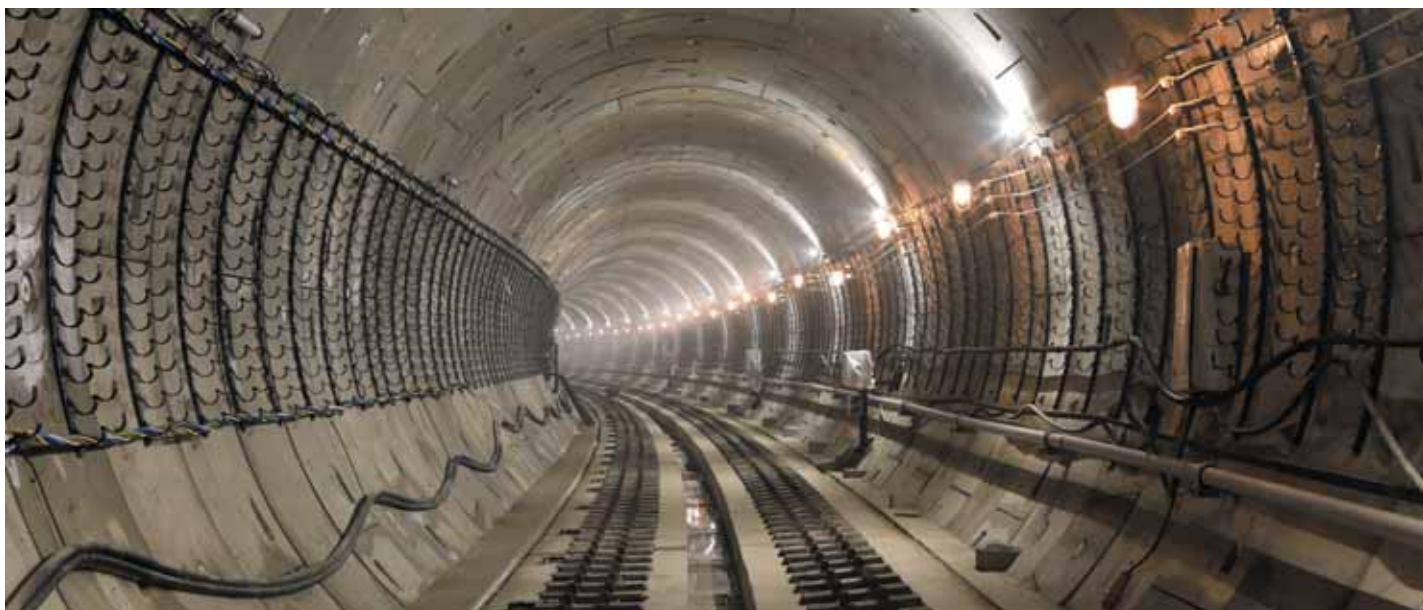
Правый перегонный тоннель станции «Зюзино»
