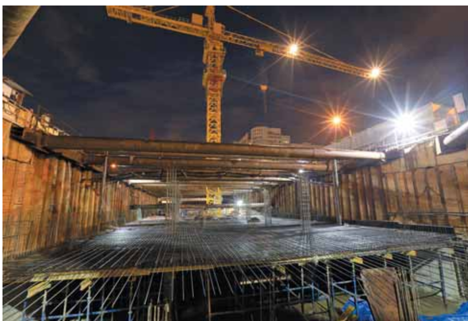
Котлован станции «Зюзино»
