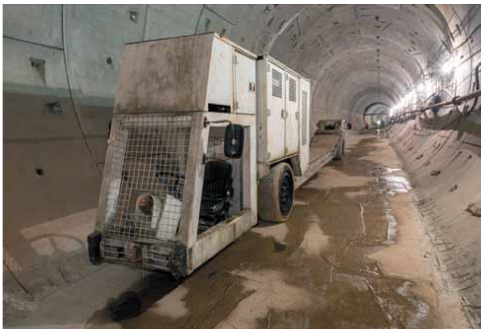
Перегонный тоннель между станциями «Сокольники» и «Электровзаводская»
