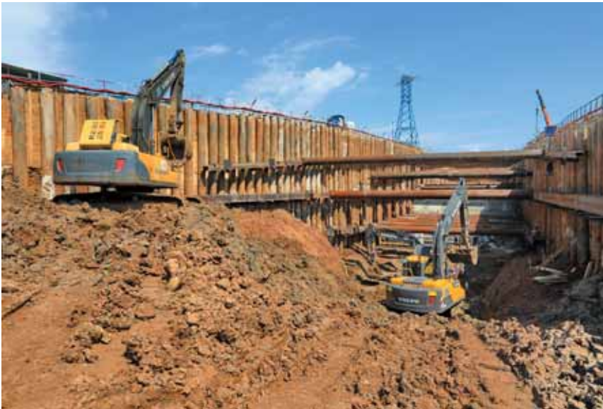
Котлован станции «Пыхтино»
