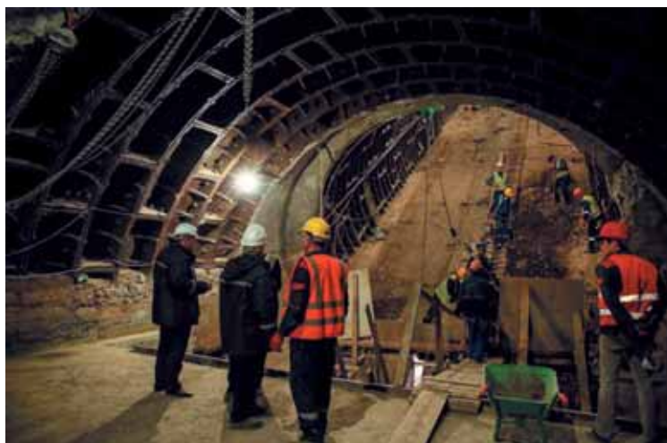
Второй наклонный тоннель на станции «Элмляр Академиясы»
