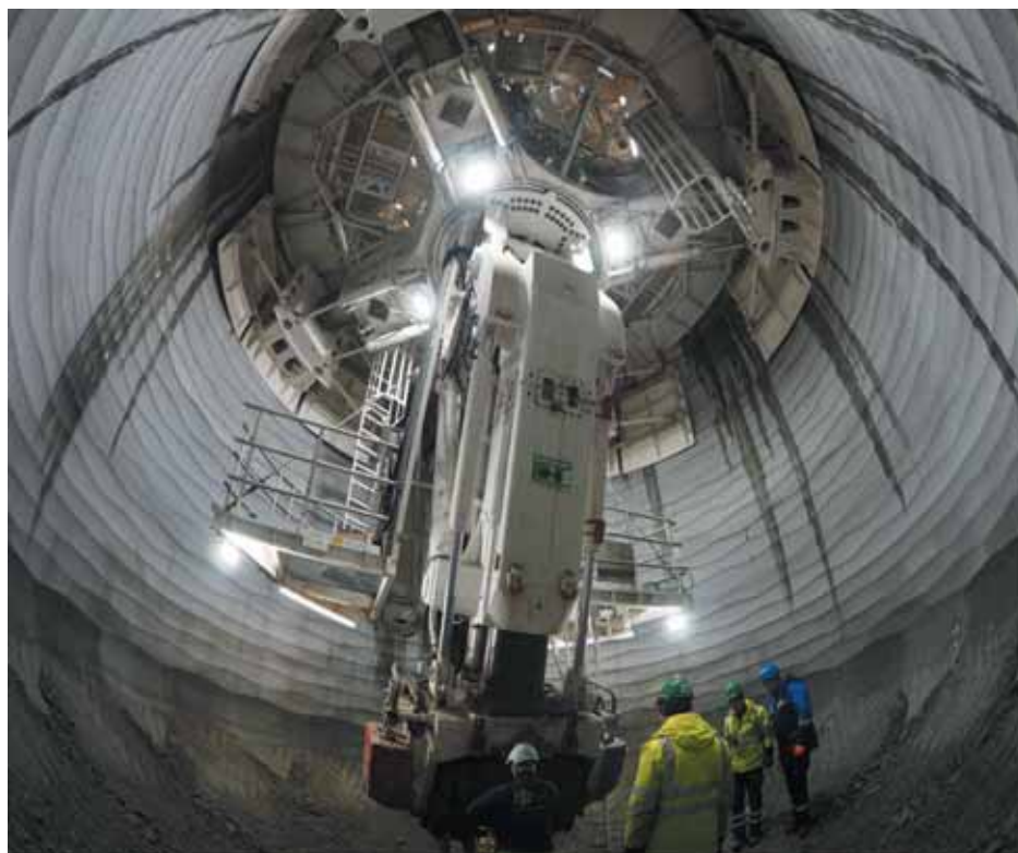
Забой на SBR MI-029 при проходке по замороженным глинам
