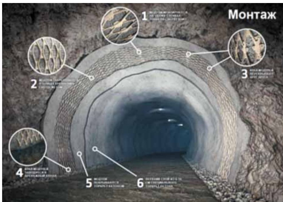
Рис. 3. Монтаж дренажной сетки Dolenco для тоннелей
