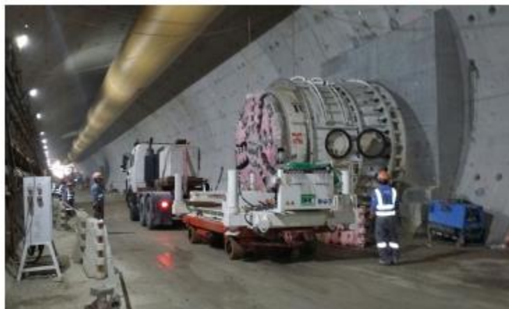
Рис. 11. Демонтаж ТПМК AVN3000 после проходки сбойки
