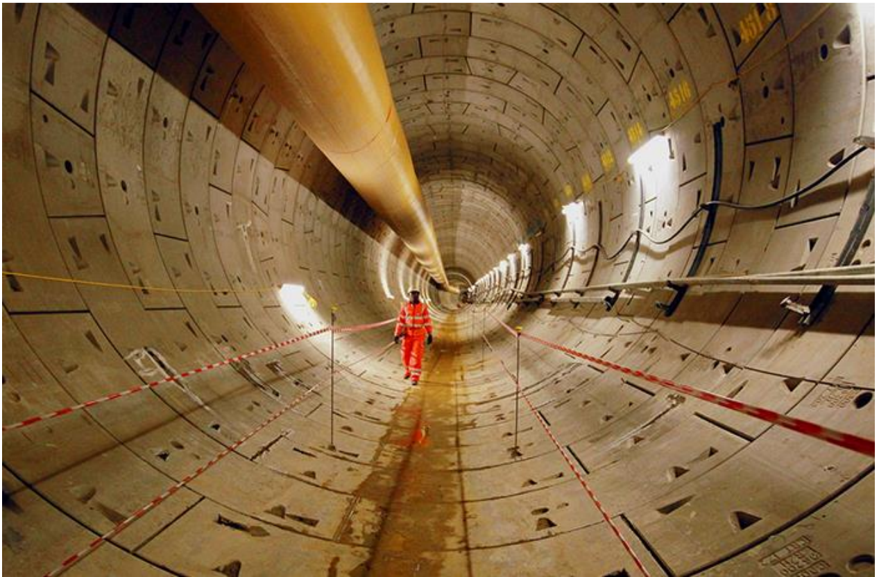
Тоннель Кроссрейл, Великобритания Источник: crossrail.co.uk
