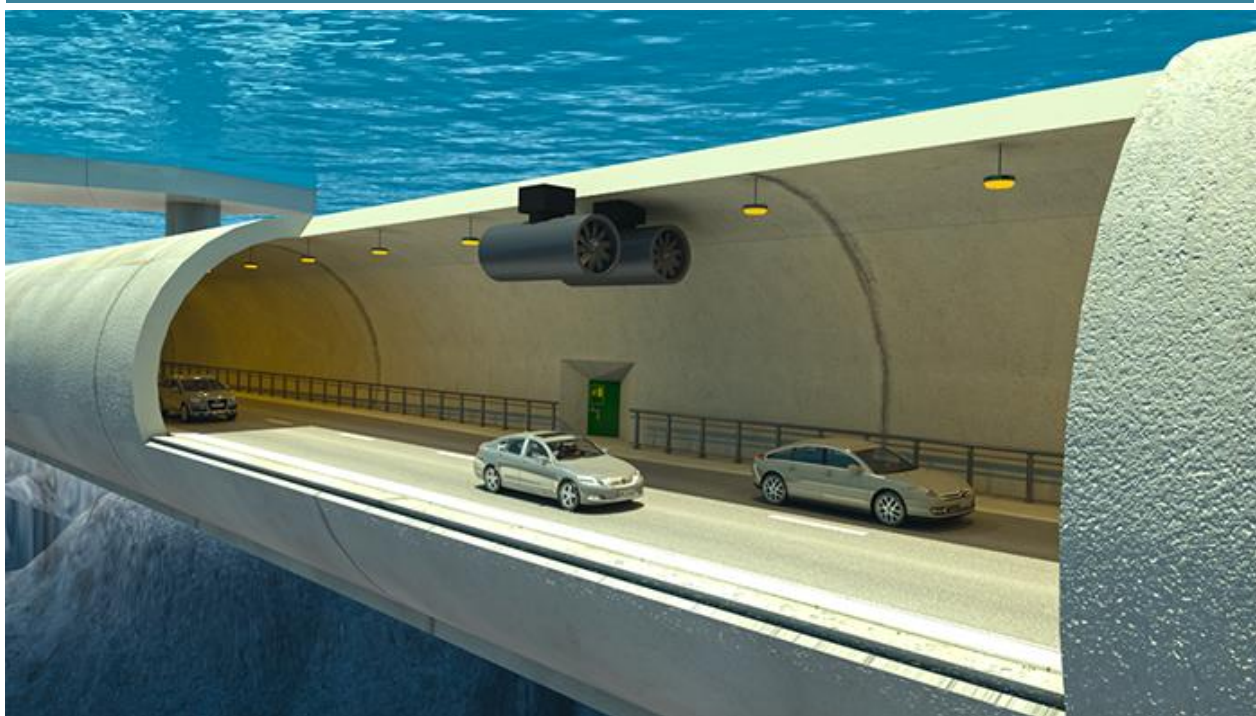
Проект первого подводного плавающего тоннеля в Норвегии Источник: static5.uk.businessinsider.com
