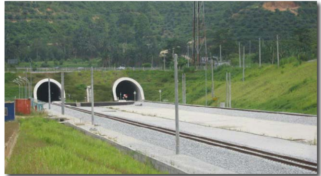
Bukit Berapit Rail Tunnel
