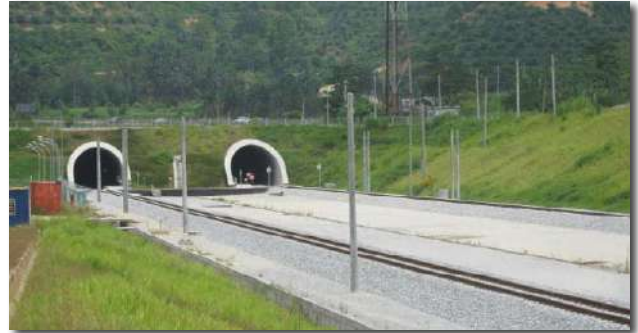
Bukit Berapit Rail Tunnel
