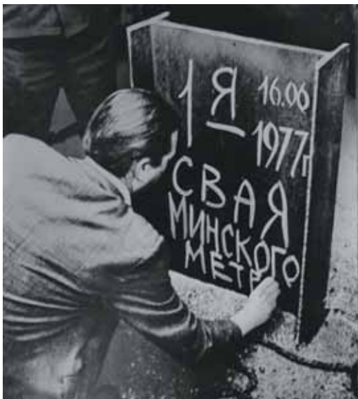
Рис. 1. Первая свая в котлован будущей станции «Парк Челюскинцев»
