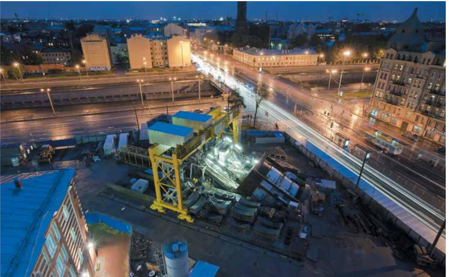
Закрепление массива jet-сваями осуществлено рядами вертикальных скважин, пробуриваемых вдоль оси наклонного хода. Цементация производилась зонально, обеспечивая создание грунтоцементного ограждения необходимой толщины.
