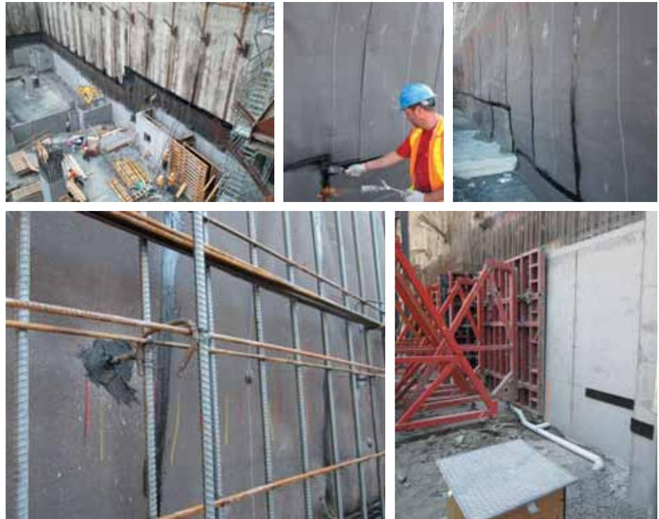
Рис. 9. Устройство гидроизоляционного покрытия из рулонов заводской готовности на основе битумно-полимерного композита с адгезией к свежееуложенному бетону, при возведении постоянной стеновой конструкции без пазух для обратной засыпки грунта
