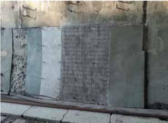
Рис. 7. Послойное устройство гидроизоляции несущей «стены в грунте» с применением напыляемого состава с двухсторонней адгезией. Слева направо: «стена в грунте»; выравнивающий слой с выпусками анкеров; слой напыляемой гидроизоляции; армирующая сетка, слой набрызг-бетона
