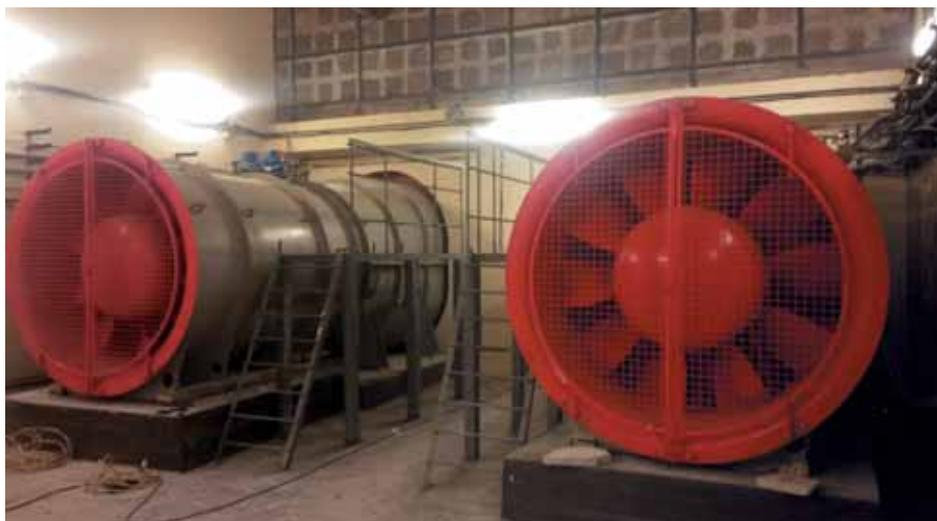
Рис. 1. Резервированная система вентарегатов одной из станций Московского метрополитена
