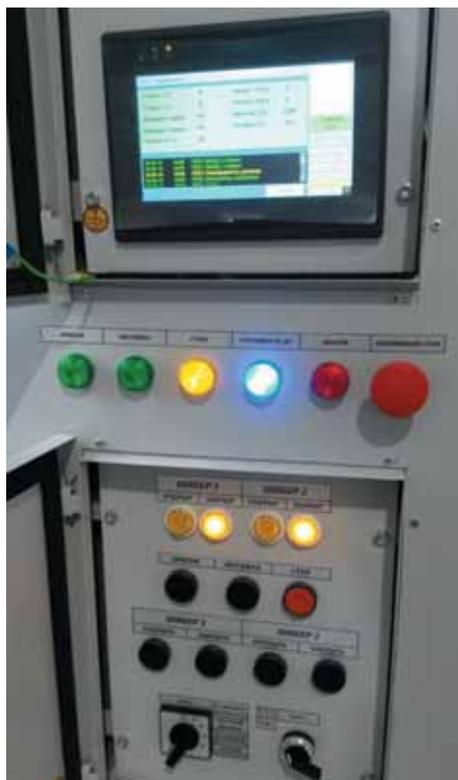
**Рис. 2. Панель оператора, аппаратура управления и индикации шкафа контроллерного**
