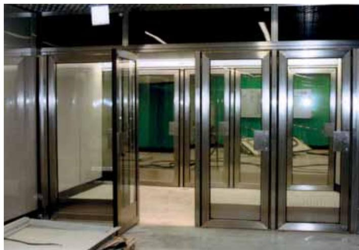
Монтаж дверей из нержавеющей стали в вестибюле станции «Раменки»
