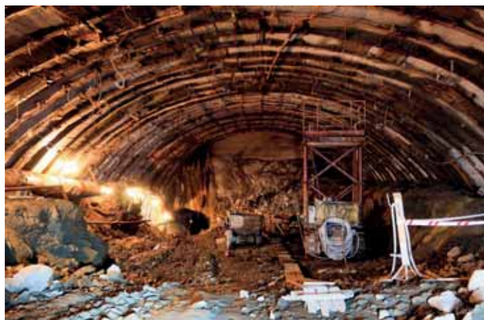
Рис. 5. Проходка калотты
