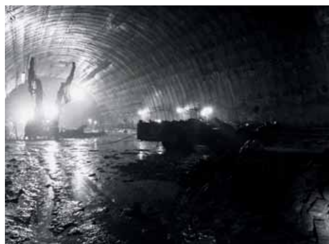
Рис. 8. Буровой станок и порододоставочная машина
