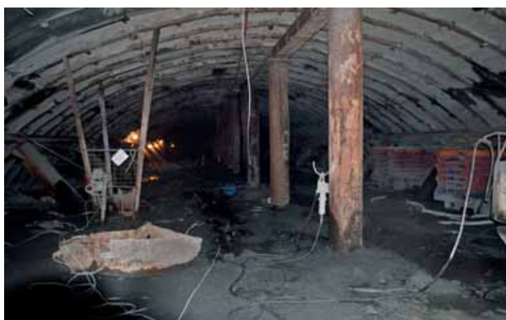
Рис. 7. Усиление временной выработки двутаврами и стойками после единовременной просадки свода
