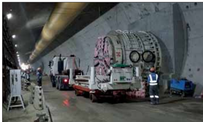
Рис. 11. Демонтаж ТПМК AVN3000 после проходки сбойки
