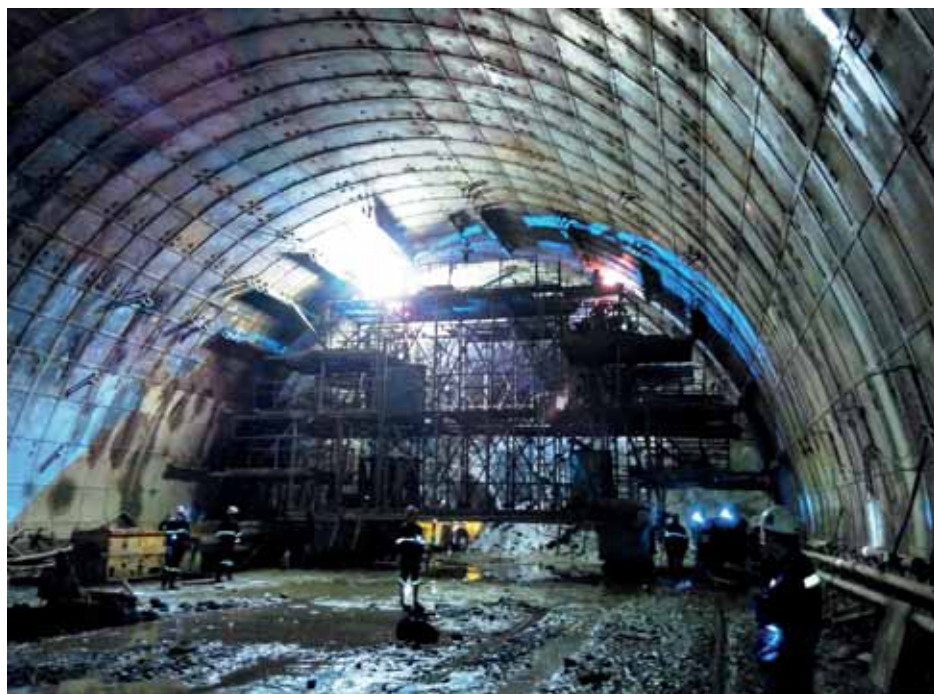
Рис. 1. Работа с технологических подмостей
