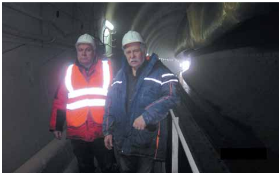
Рис. 4. Строительство нового Байкальского тоннеля
