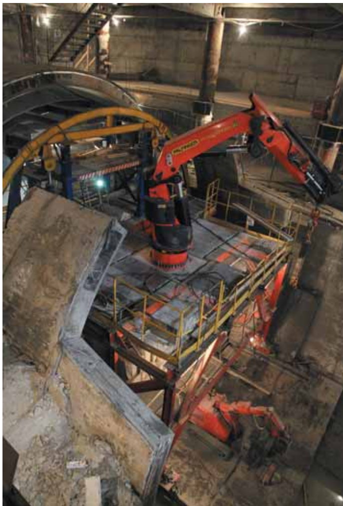
Демонтаж обделки в теле станции «Дунайский проспект»
