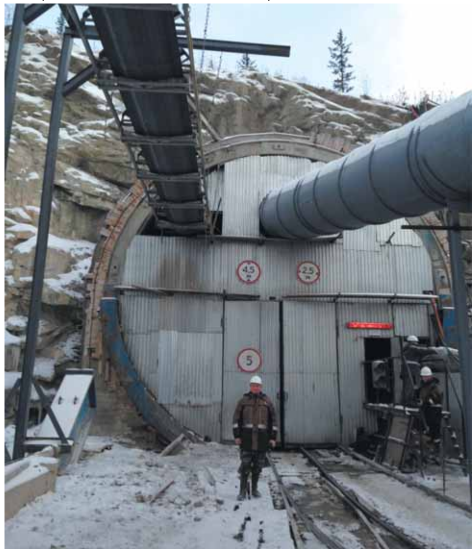
Рис. 2. Врезка нового Байкальского тоннеля. Западный портал
