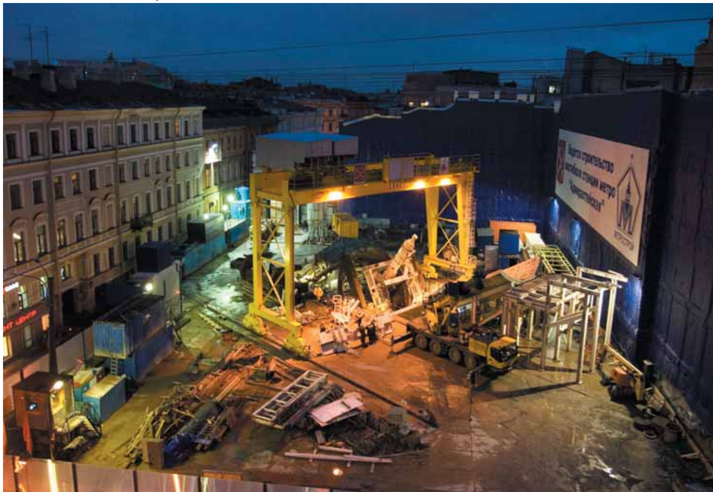
Монтаж ТПМК на станции «Адмиралтейская»
