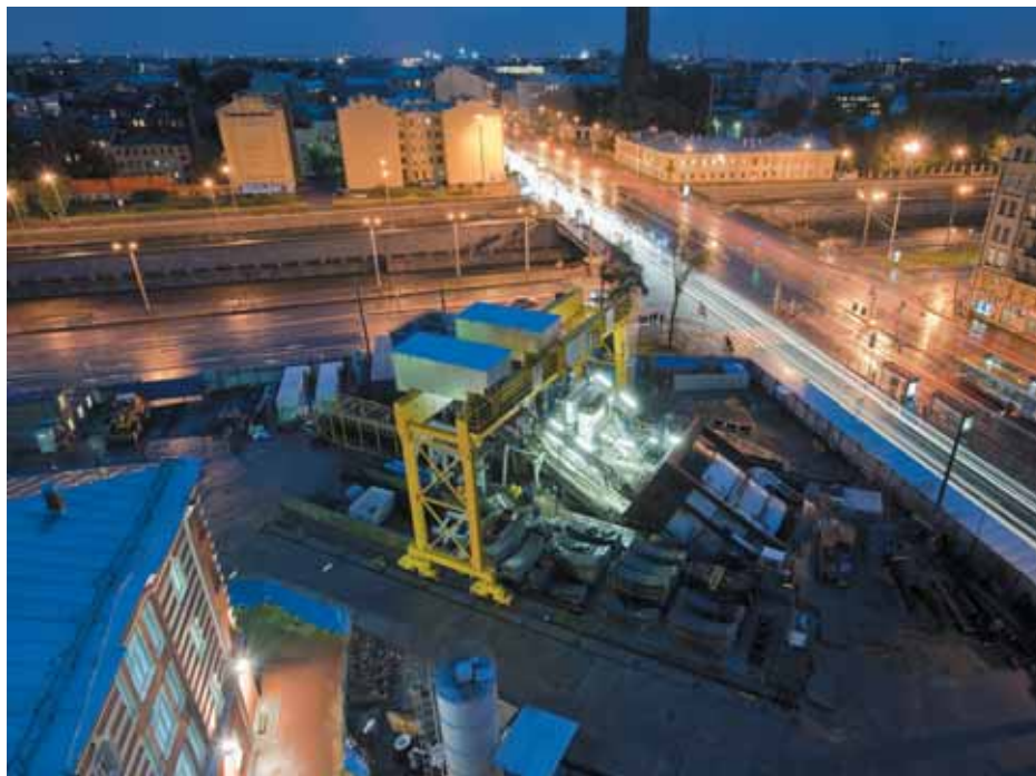
Рис. 2. Начало проходки эскалаторного тоннеля станции «Обводный канал»
