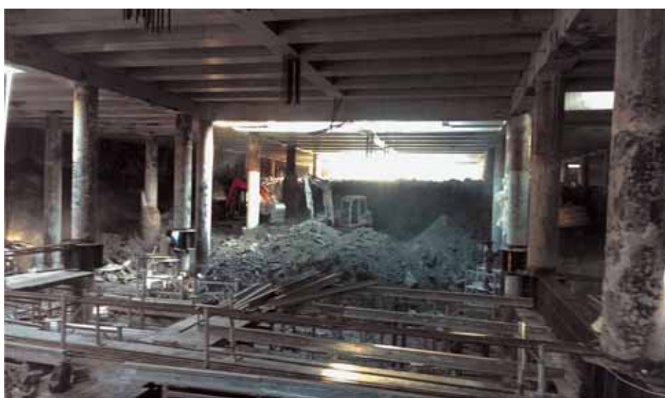
Рис. 10. Возведение перекрытия второго яруса ст. «Новокрестовская»
