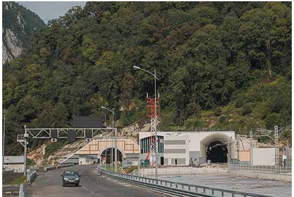
Рис. 5. Тоннельный комплекс № 1 совмещенной дороги Адлер – «Альпика-Сервис»
