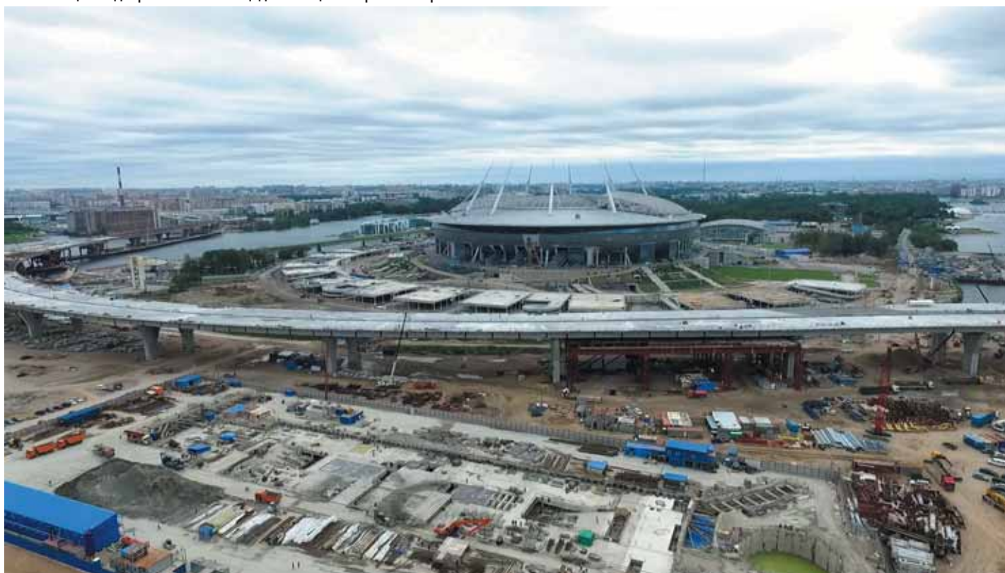
Рис. 1. Общий вид строительной площадки станции метро «Новокрестовская»
