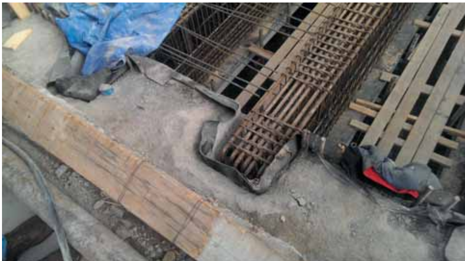
Рис. 7. Опираие балок покрытия на «стену в грунте»
