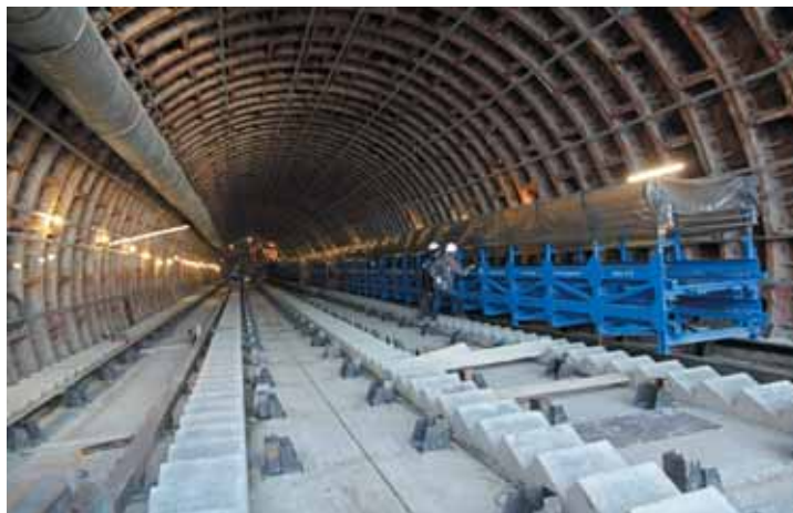
Монтаж эскалаторов, ст. «Проспект Славы»
