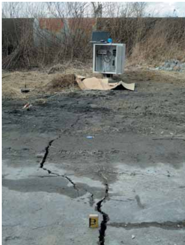
Рис. 4. Трещина на поверхности земли при выполнении нагнетания тампонажного раствора за обделку
