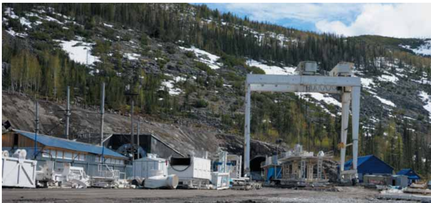
Рис. 3. Монтаж тоннелепроходческого механизированного комплекса
