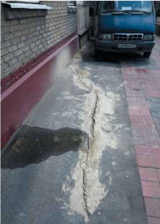
Рис. 16. Трещина в отмостке здания, расположенного вдоль котлована вестибюля станции «Бутырская»
