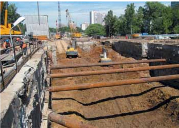
Рис. 3. Забой при проходке подходных выработок станции «Суворовская»
