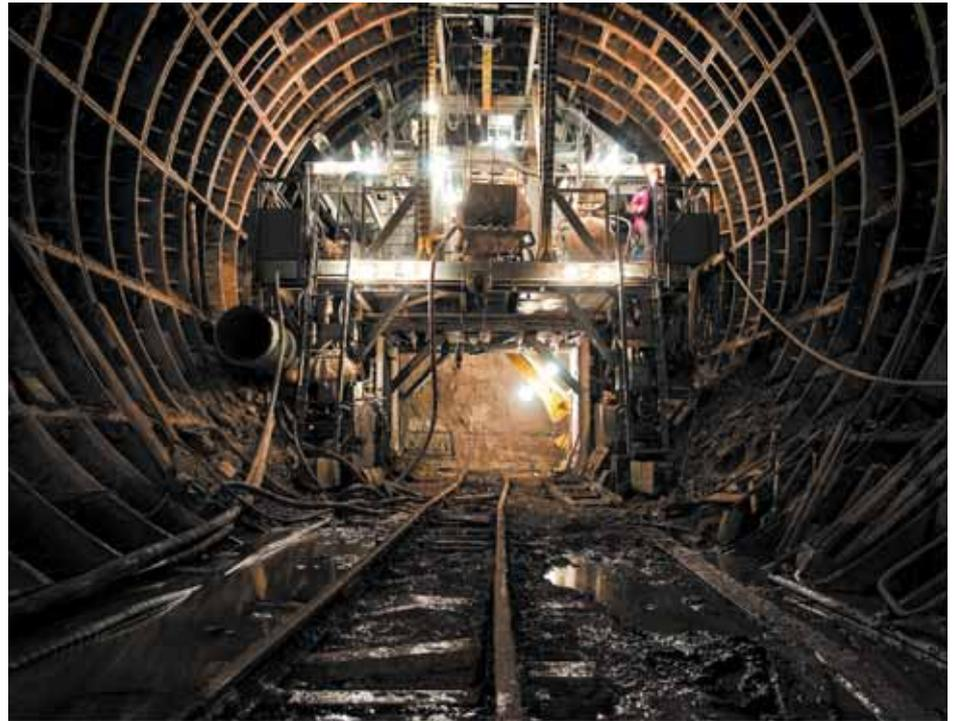
**Рис. 9. Монтаж чугунной обделки перегонного тоннеля с помощью тьюбингоукладчика**
