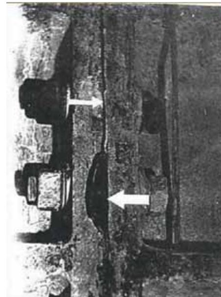
Рис. 1. Характер выдавливания вертикальных свинцовых прокладок
