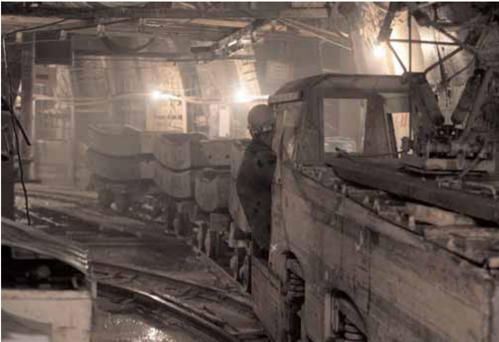
Доставка тьюбингов для строительства тоннеля
