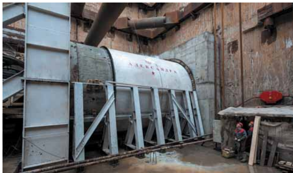
ТПМК «Александра» перед началом проходки правого перегонного тоннеля от тупиков за камерой съездов до станции «Селигерская»
