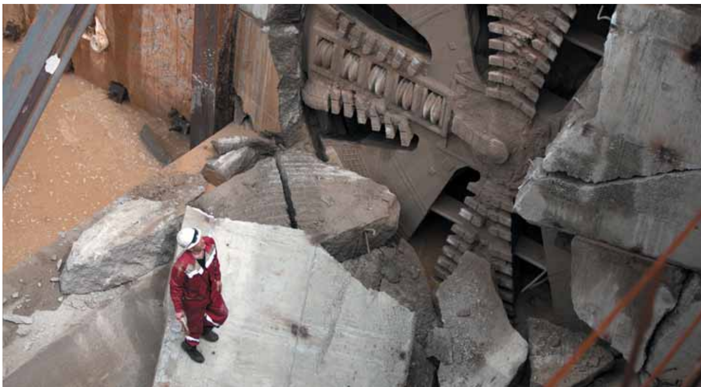
Завершение проходки перегонного тоннеля от станции «Юго-Западная» до «Тропарёво»
