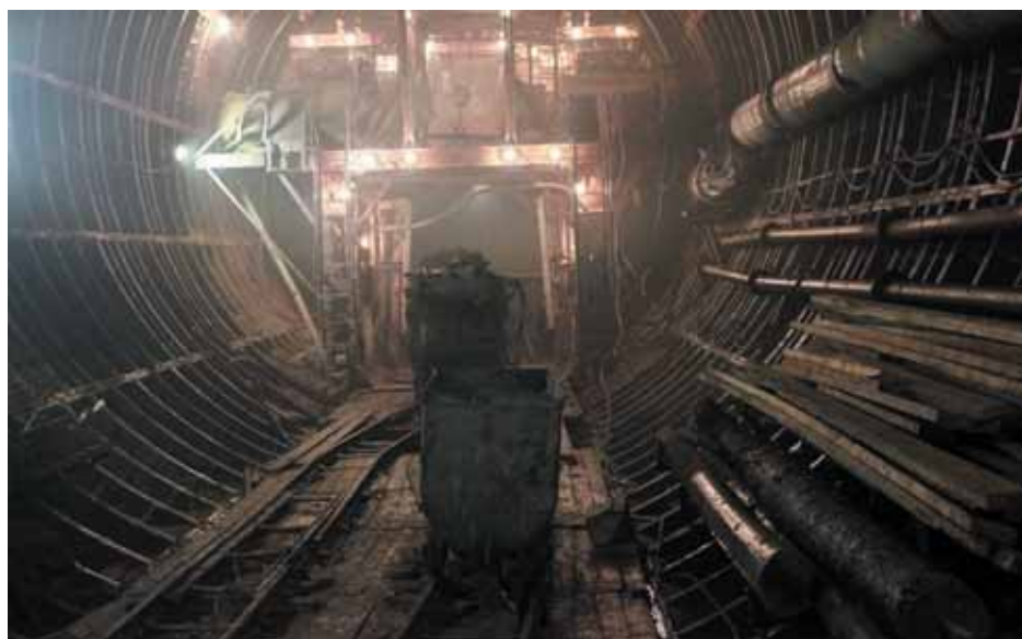
Проходка станционного тоннеля с помощью блокоукладчика на станции «Верхние Лихоборы»
