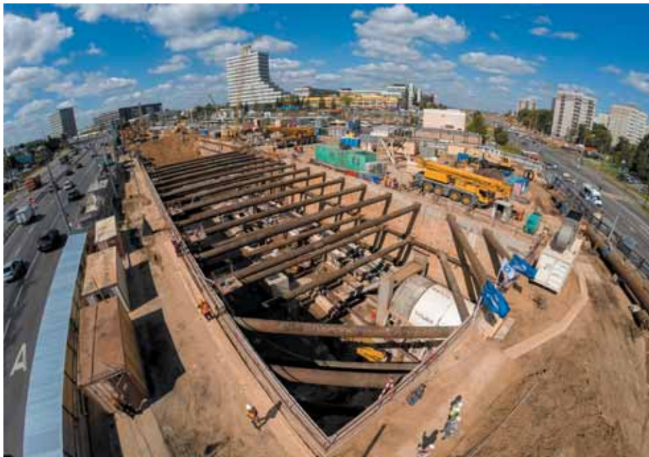
Старт ТПМК «Татьяна» из монтажной камеры на станции «Очаково» для проходки перегонного тоннеля в сторону «Мичуринского проспекта»
