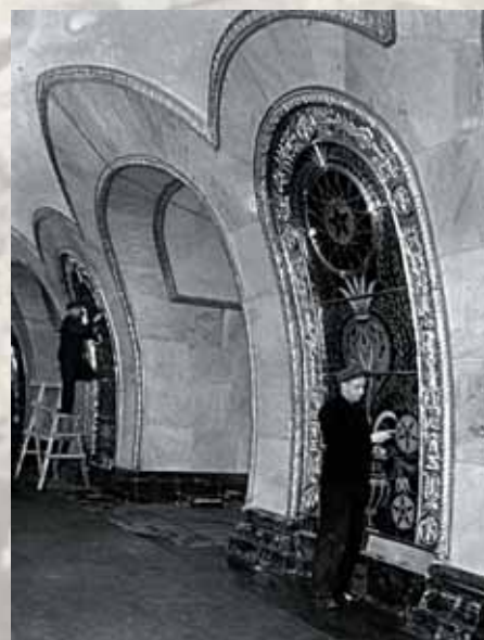
Станция «Новослободская». Отделка витражей, июль 1951 г.
