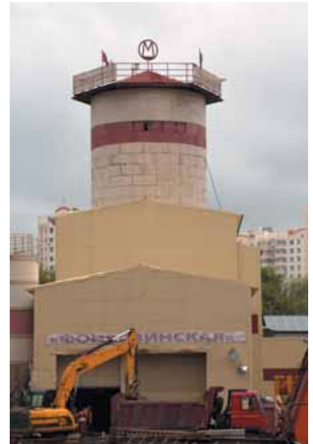
Шахта № 953 станционного комплекса «Фонвизинская»
