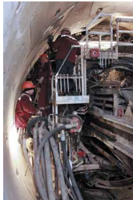
Работа внутри щита
