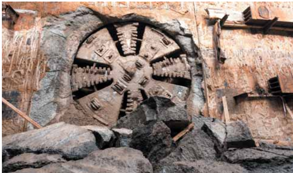
Выход ТПМК «Валентина» на строящейся станции «Селигерская»
