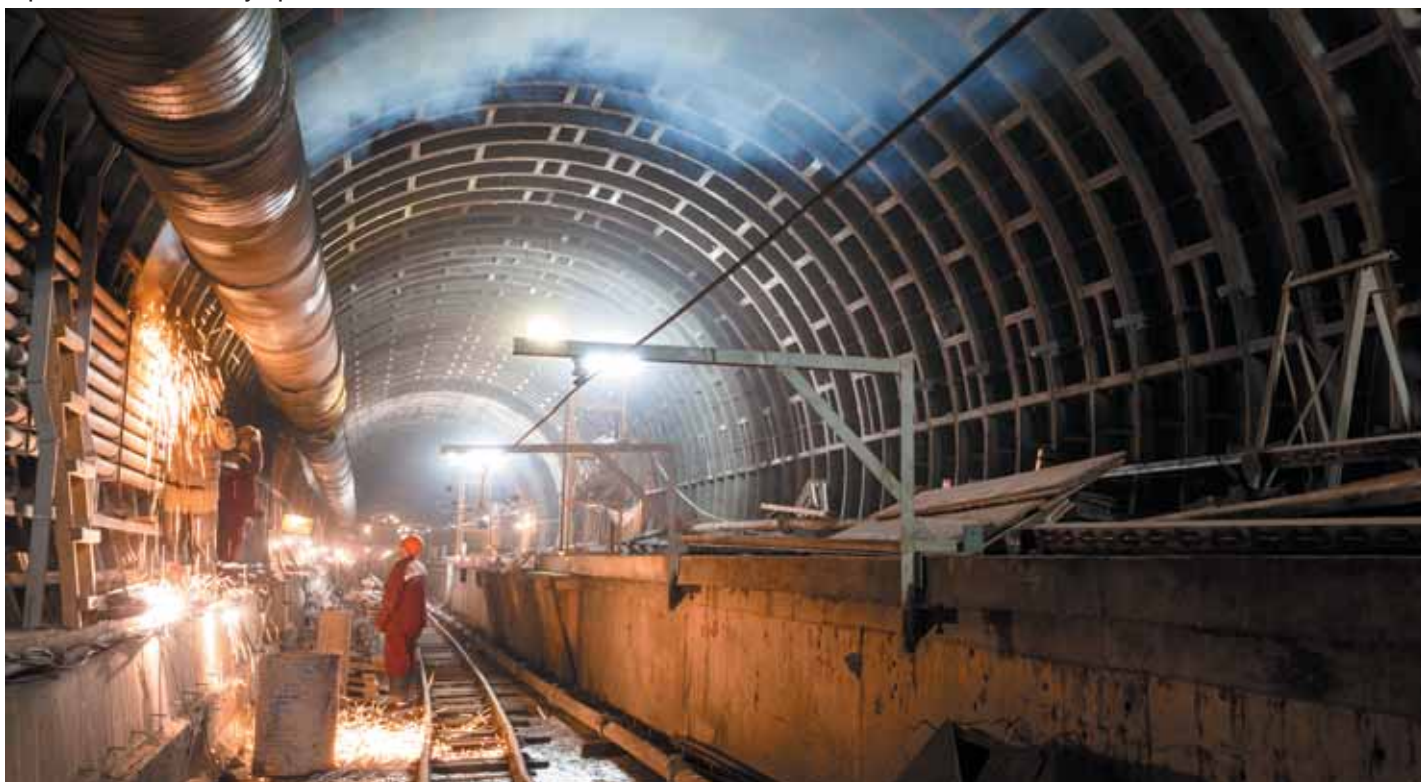
Строительство станции «Бутырская»
