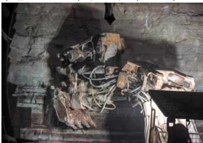
Проходческий комбайн на строящейся станции «Верхние Лихоборы»
