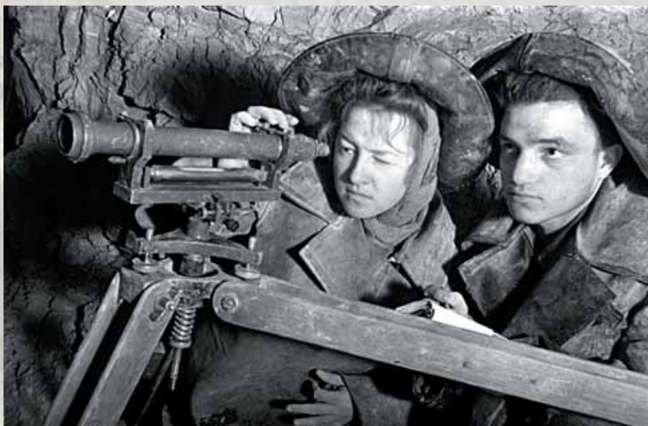
Маркшейдеры-комсомольцы О. Чакина и В. Цокота проверяют направление щитовой проходки тоннеля станции «Комсомольская», 1948 г.
