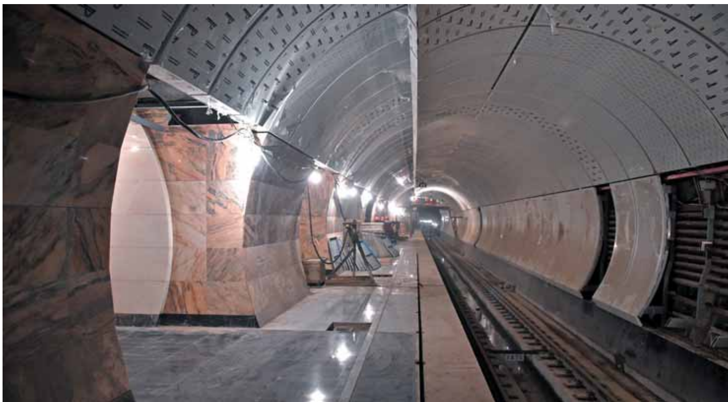
Отделочные работы на станции «Бутырская»
