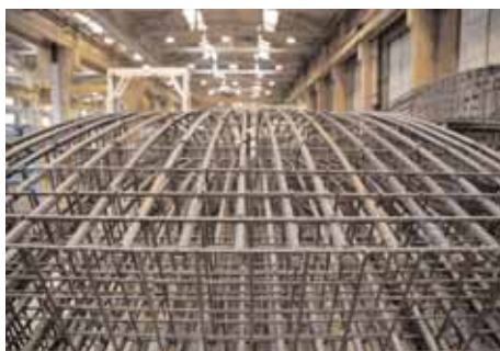
Нижняя и верхняя рабочие сетки дополнительно соединены хомутами
