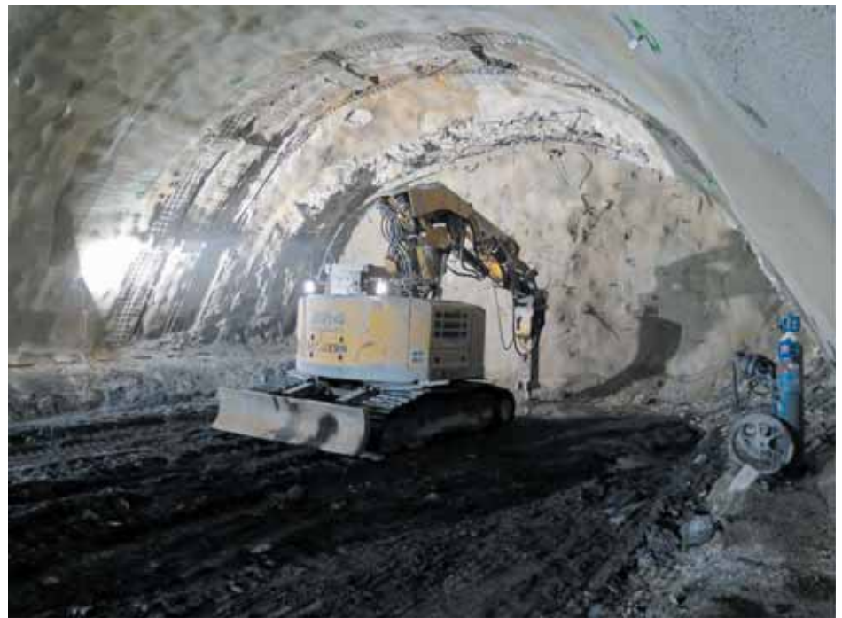
Проходка зоны разлома в тоннеле Висп (Visp) с креплением лба забоя фиберглассовыми анкерами
