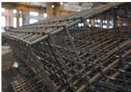
Усиление сетками основания каркаса в месте стыковки элементов обделки
