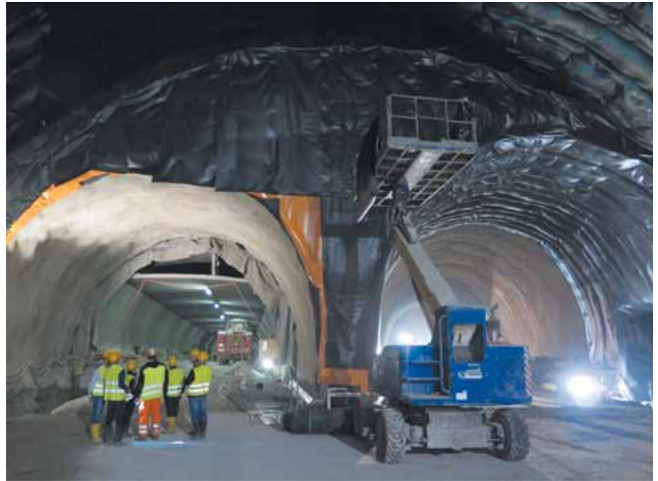
Устройство гидроизоляции строящегося тоннеля Висп (Visp)
