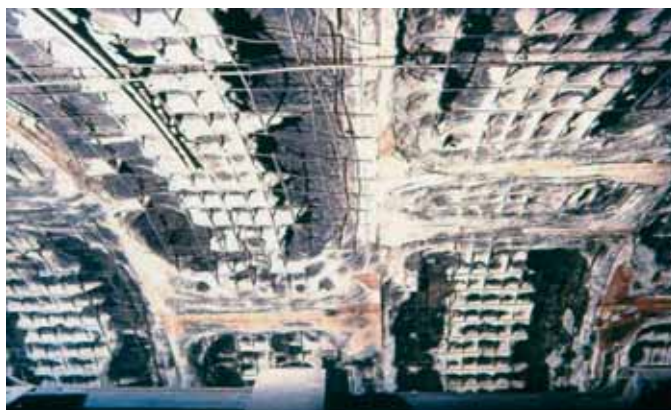
Рис. 5. CHANNEL TUNNEL, Франция – Англия, 2008
