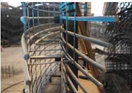
Объемный каркас собирается дуговой сваркой из криволинейных каркасов и гнутых рабочих сеток
