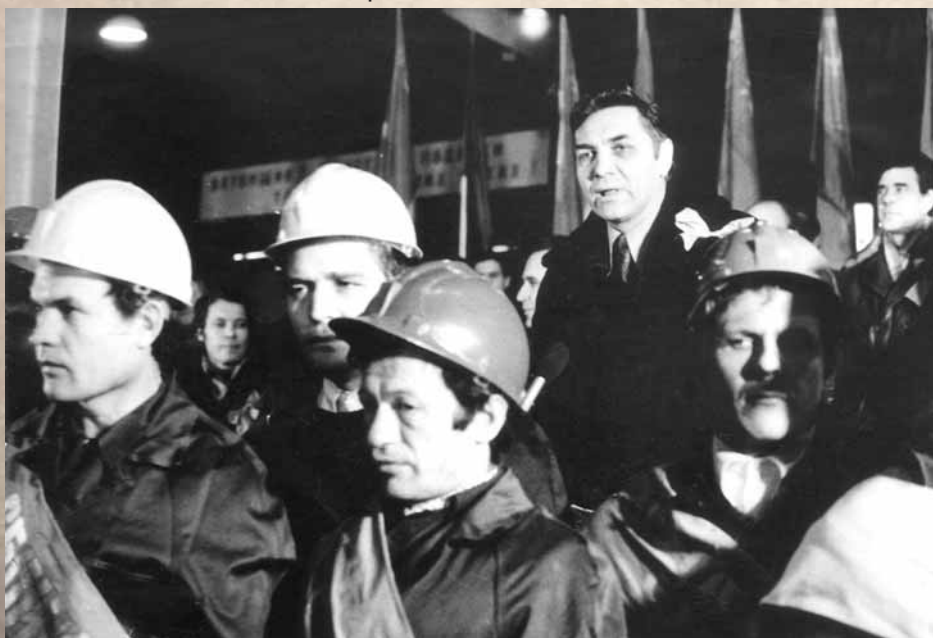
На сбойке Байкальского тоннеля, декабрь 1982 г.
