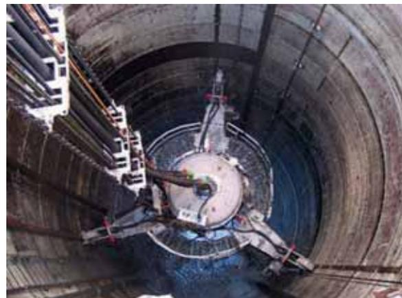
Рис. 3. Вид сверху на машину в стволе. Проходка под гидропригрузом
