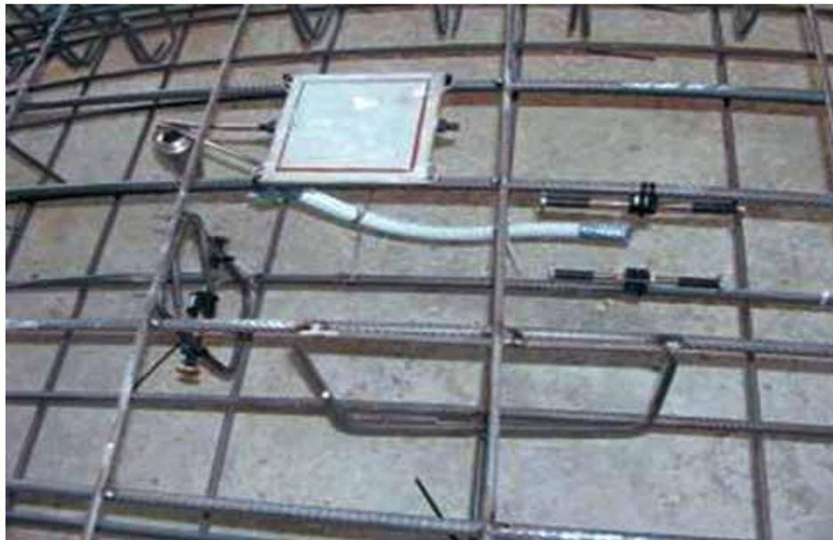
Рис. 16. Установка датчиков измерения напряжений бетона и арматуры в блоках обделки
