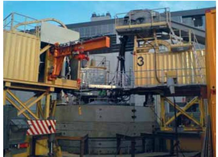
Рис. 6. Опускные контейнеры с лебёдками, готовая обделка ствола, крановый блок, домкраты задавливания обделки
