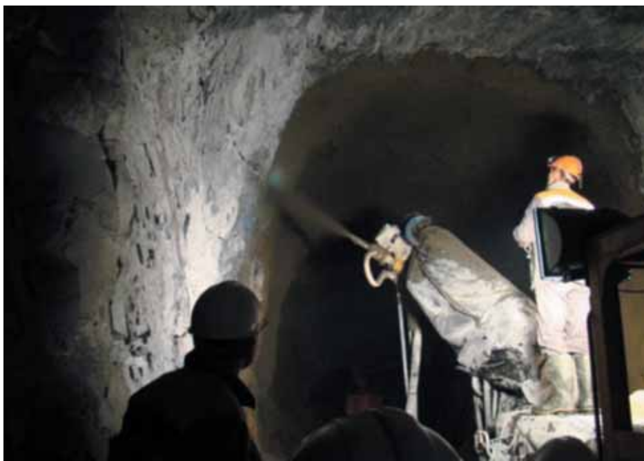
Рис. 2. Процесс нанесения набрызг-бетона
