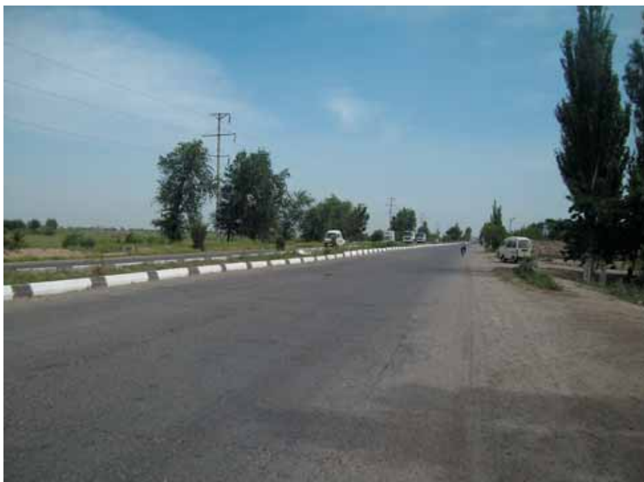
Рис. 4. Автомобильная дорога М-37 «Самарканд – Ашхабад – Туркменбаши, 321–331 км»
