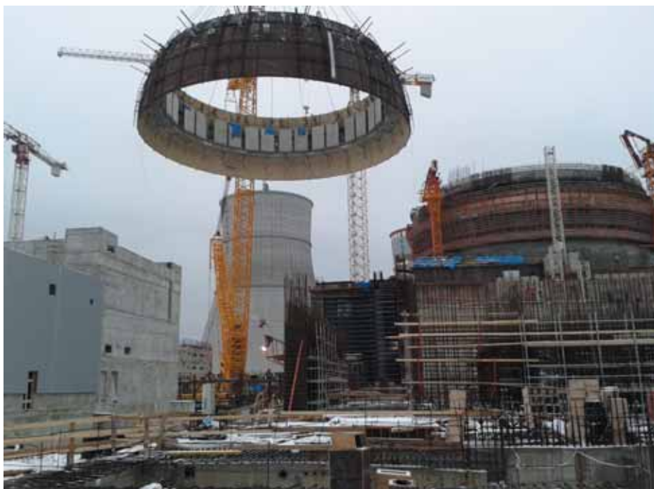
Установка купола реактора на ЛАЭС-2, 12 января 2014 г.
