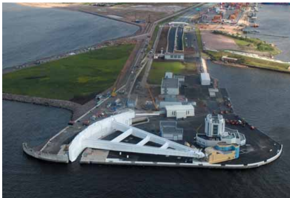
Комплекс защитных сооружений от наводнений
