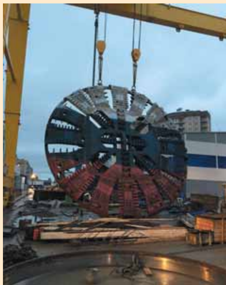
Монтаж ТПМК «Надежда»
