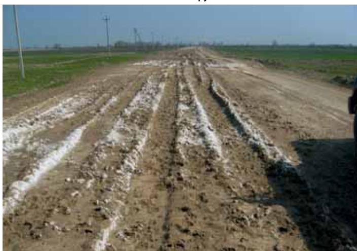
Рис. 1. Земляное полотно из засоленного грунта
