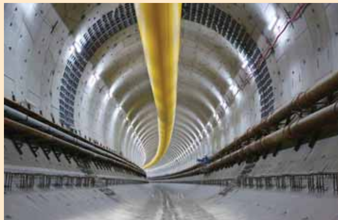
Готовая часть тоннеля «Евразия», пройденного с помощью ТПМК
