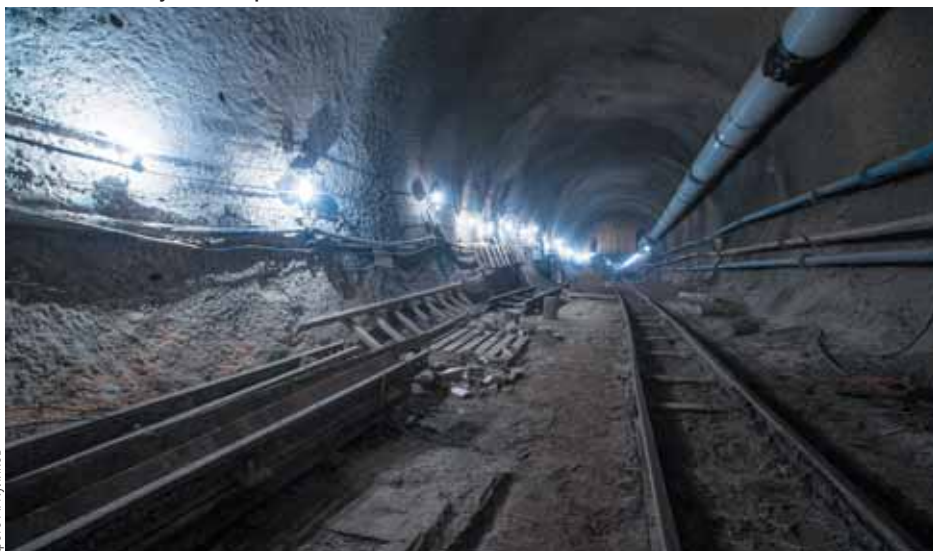
Рис. 1. Опытный участок перегонного тоннеля
