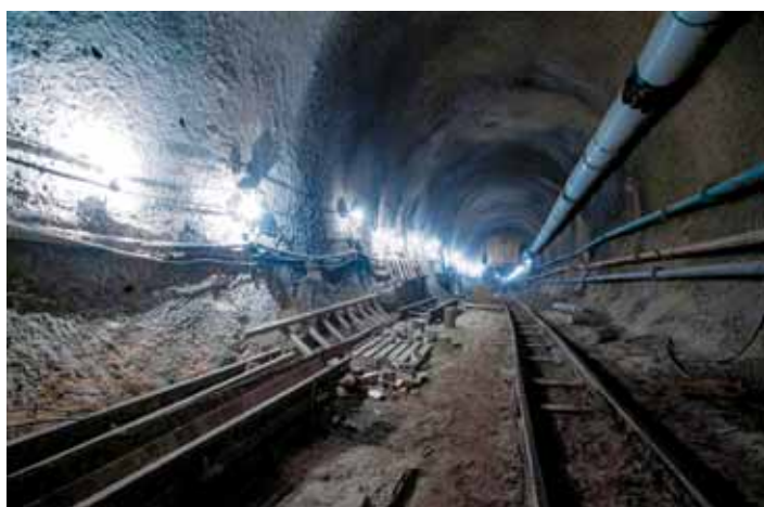
Рис. 6. Строительство монтажной камеры между станциями «Фонвизинская» и «Бутырская» Люблинско-Дмитровской линии
