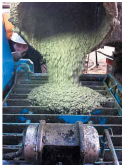
Рис. 1. Подача бетонной смеси с фиброй
