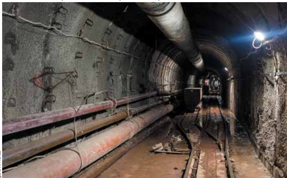
Рис. 3. Подходная выработка станции «Верхние Лихоборы»
