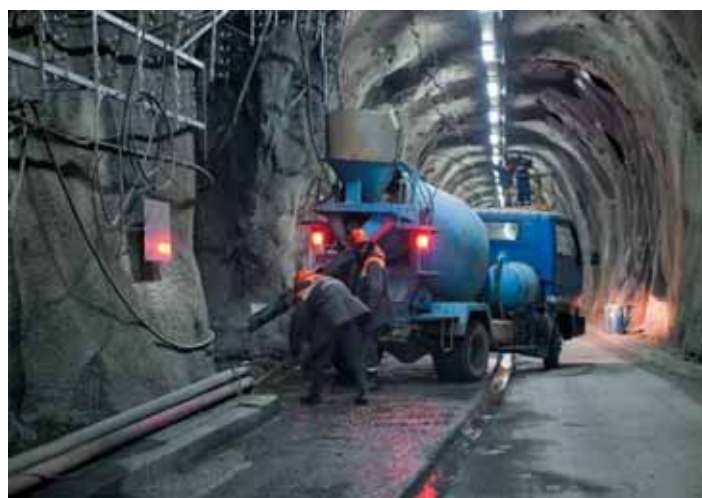
Рис. 7. Строительство Рокского автодорожного тоннеля
