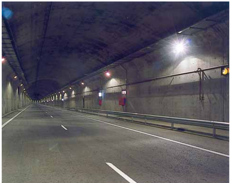
Рис. 1. Внутренний вид автодорожного тоннеля
