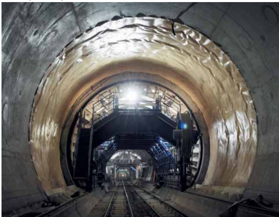
Рис. 6. Устройство гидроизоляции тоннеля
