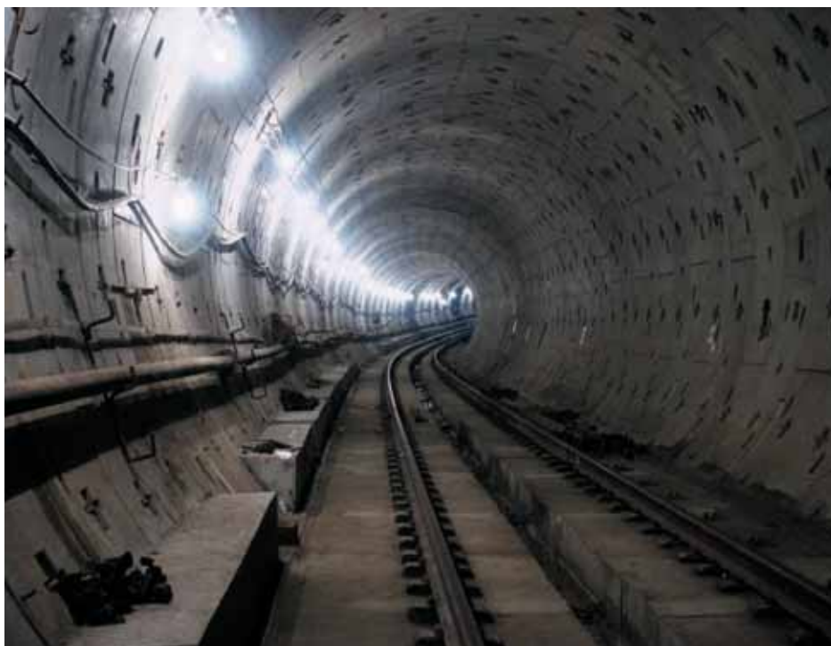
Рис. 2. Внутренний вид железнодорожного тоннеля
