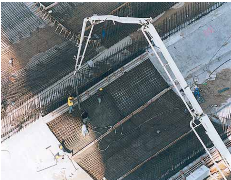
Рис. 5. Сооружение конструкций тоннеля
