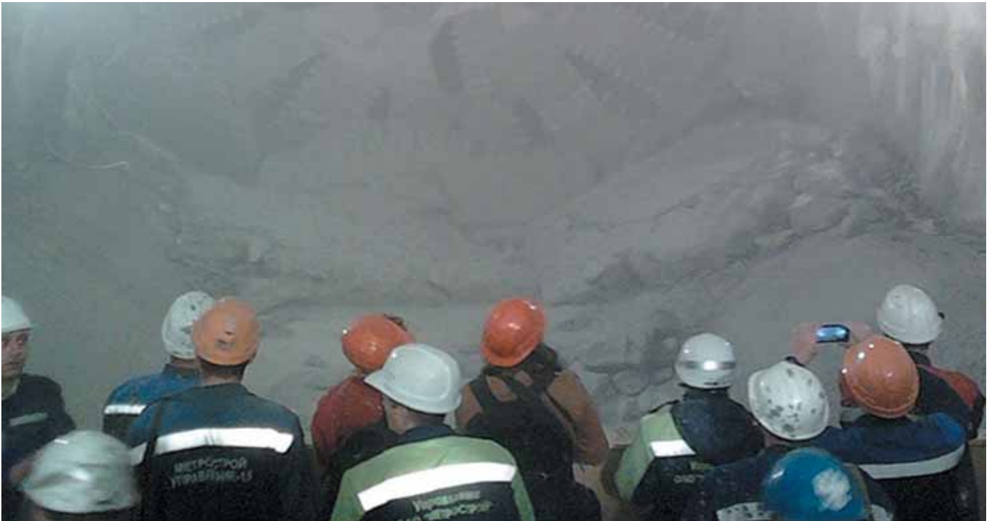
Сбойка тоннеля диаметром 10,3 м
