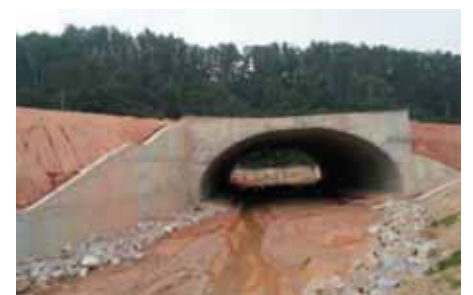
Рис. 2. Сооружение тоннельного типа из сводчатых железобетонных элементов
