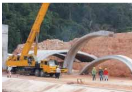
Рис. 1. Строительство сооружения тоннельного типа из железобетонных конструкций
