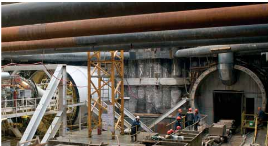
Щит фирмы NFM перед началом проходки
