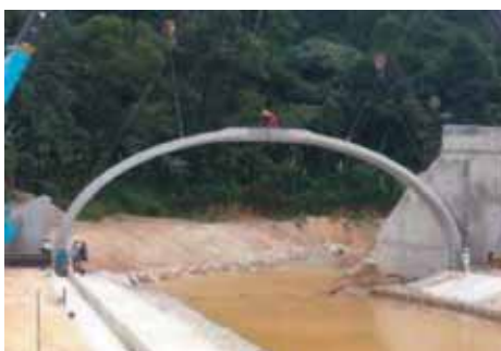
Рис. 1. Строительство сооружения тоннельного типа из железобетонных конструкций
