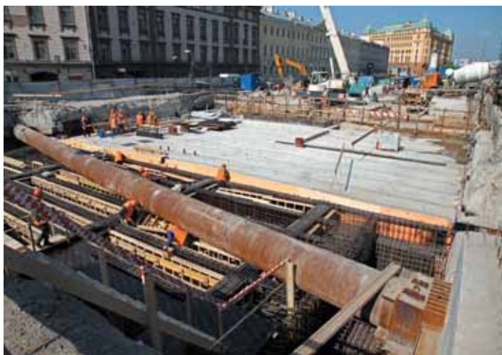
Сооружение подземной части вестибюля
