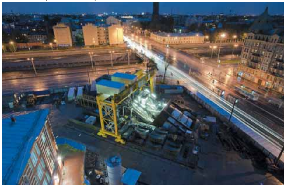
Рис. 5. Начало проходки эскалаторного тоннеля станции «Обводный канал»
