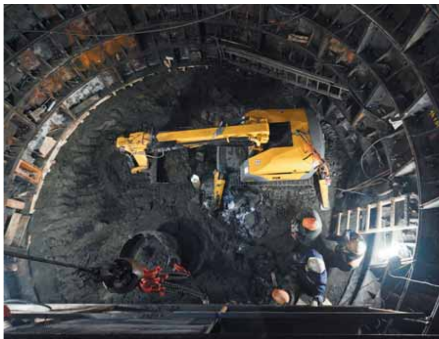
Рис. 4. Проходка традиционным способом
