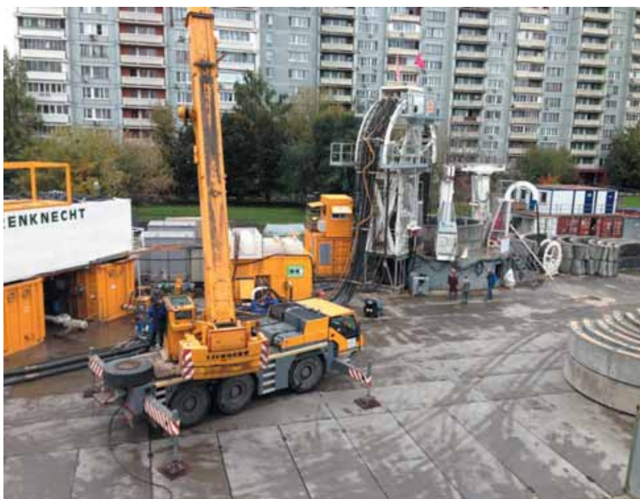
Рис. 5. Проходка ствола методом ВСМ
