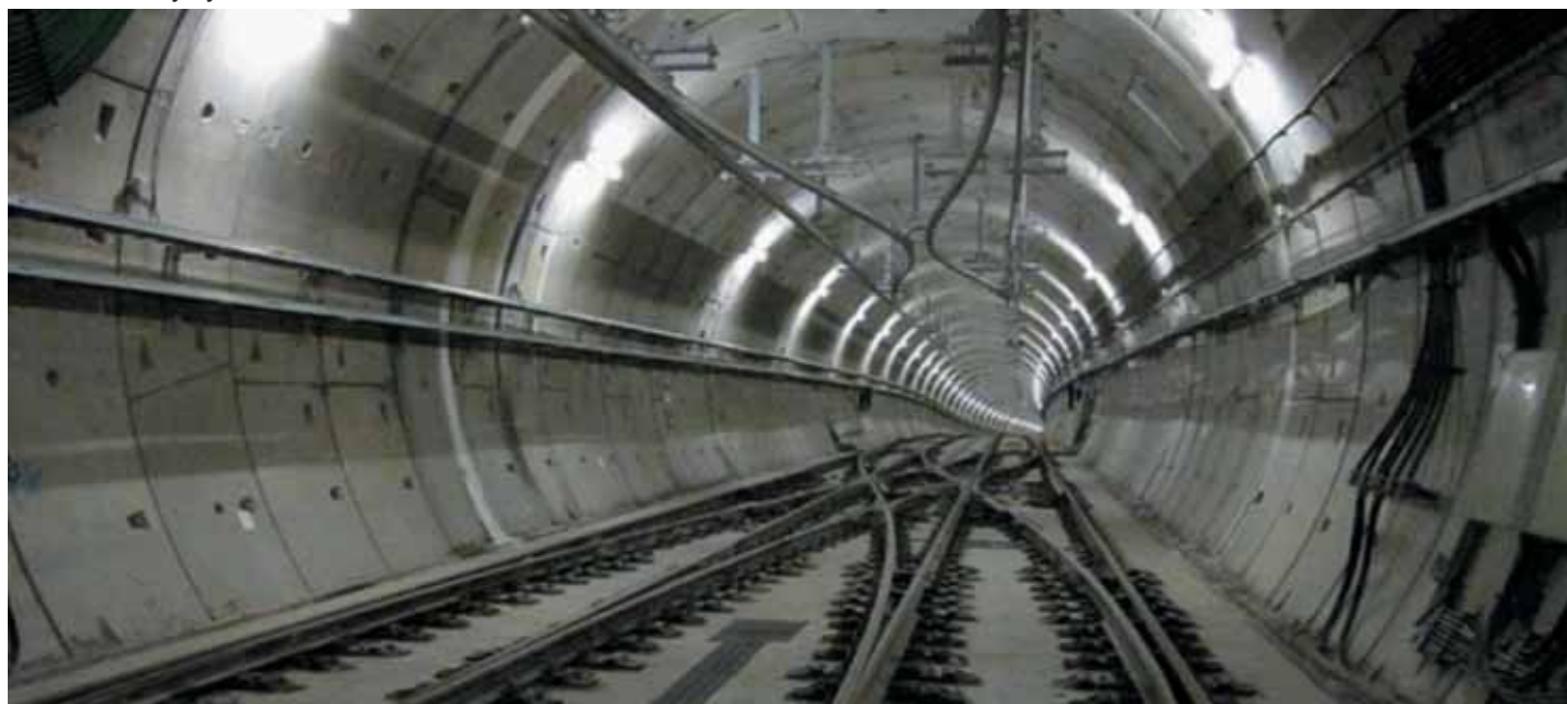
Внешний вид двухпутного тоннеля
