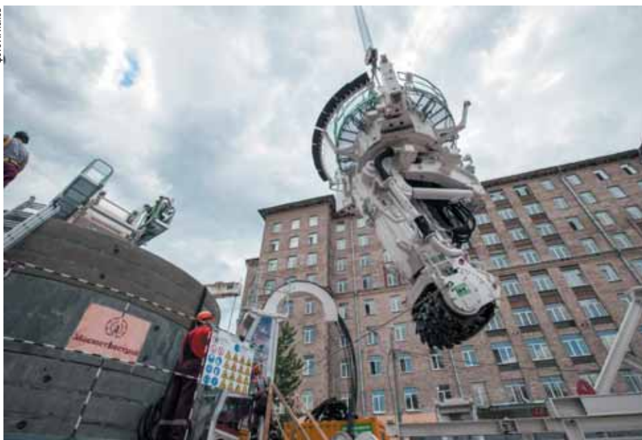
Рис. 6. Фрезерный рабочий орган
