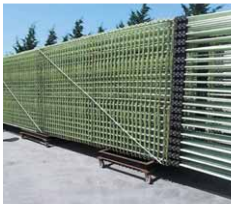
Рис. 1. Объемный каркас для секции «стены в грунте»
