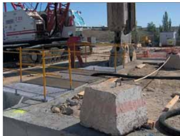
Выполнение «стен в грунте»
