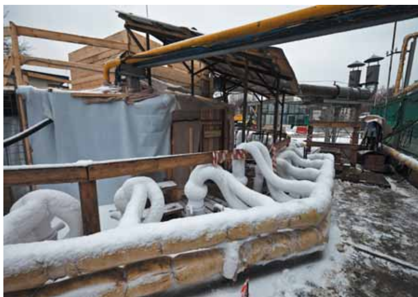
Рис. 3. Заморозка грунта вокруг ствола
