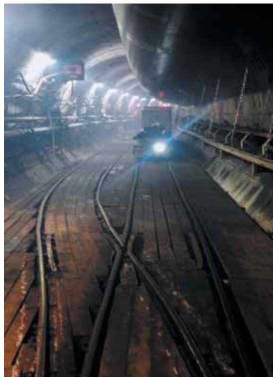
Разминовка в тоннеле
