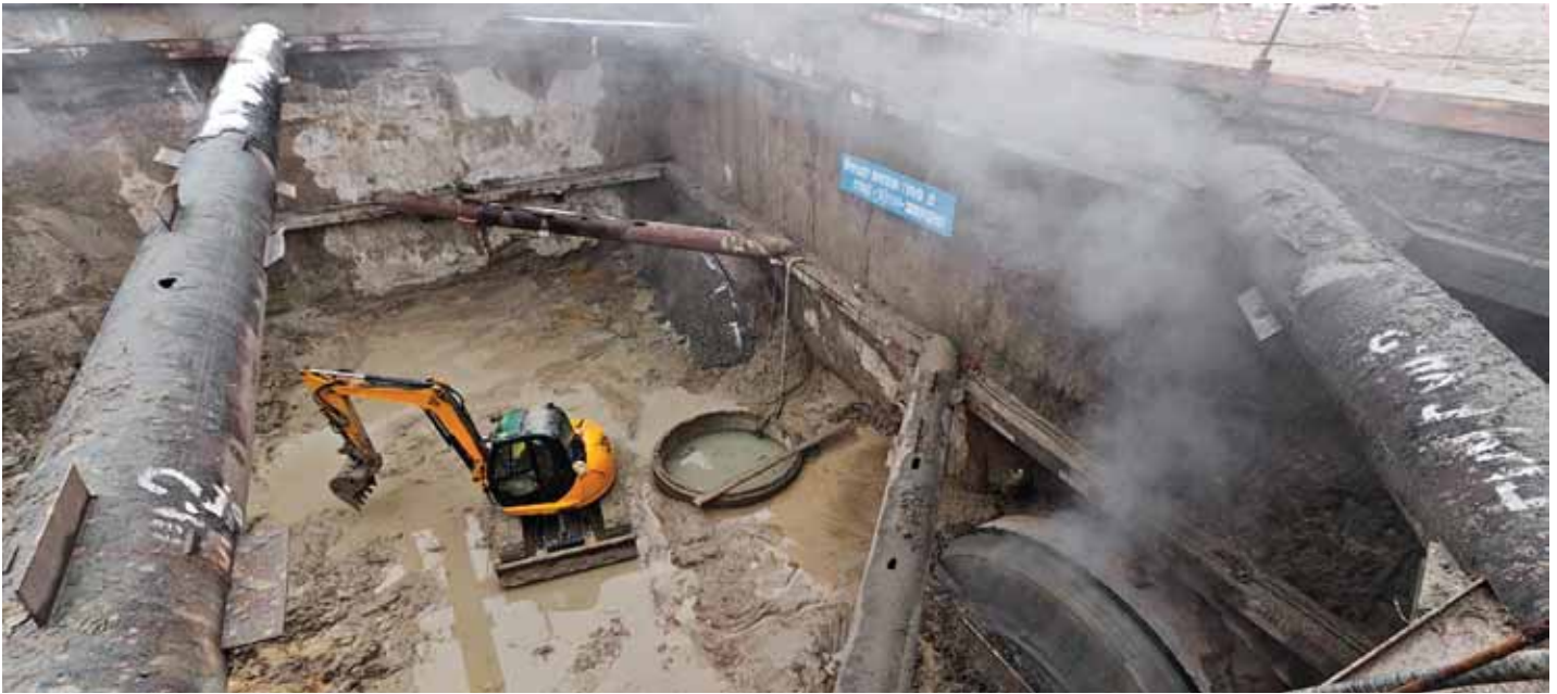
Сбойка на станции «Теремки»
