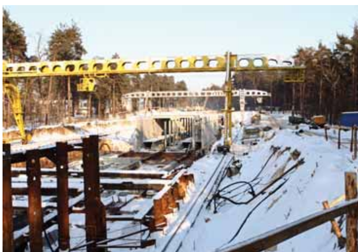
Строительство станции «Червоный Хутор»
