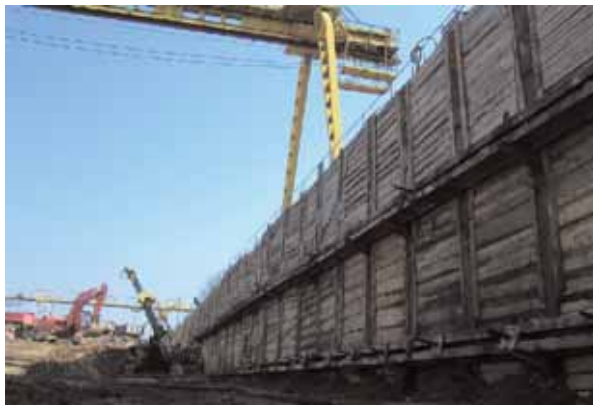
Рис. 3. Анкерное крепление ограждения
