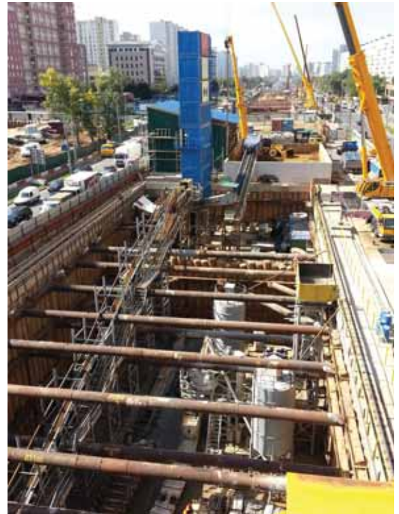
Рис. 3. Монтажная камера станции «Раменки»
