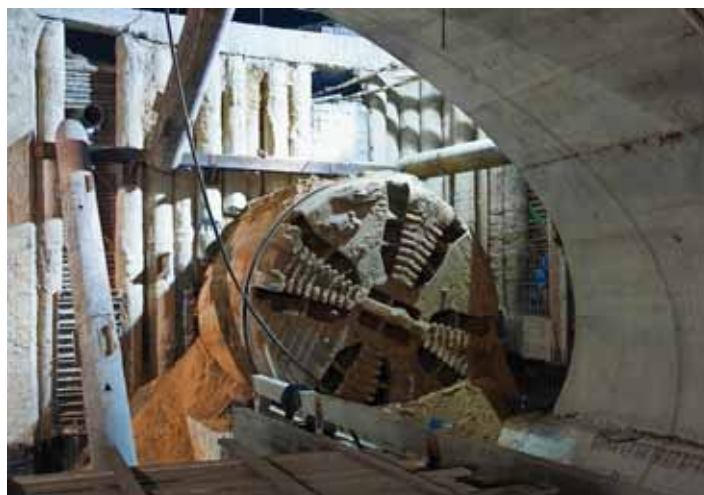
Сбойка на станции «Выставочный центр»
