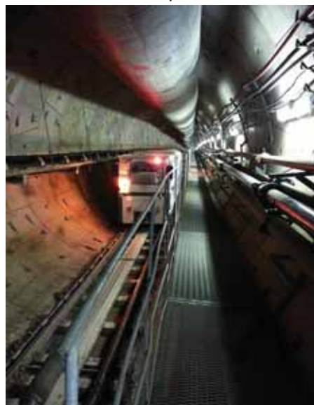
Рис. 8. Тоннель в стадии проходки
