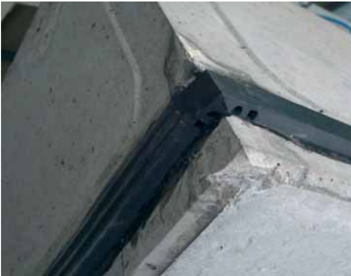
Рис. 4. Резиновый уплотнитель на бетонном сегменте, угол склейки стыка 80°
