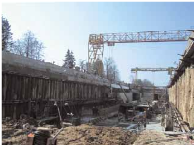
Рис. 1. Общий вид ограждения котлована
