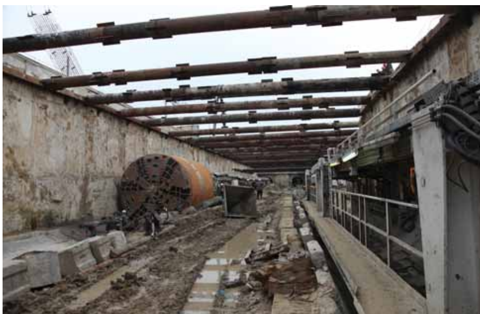
Проводка щитовых комплексов через котлован станции «Ипподром»
