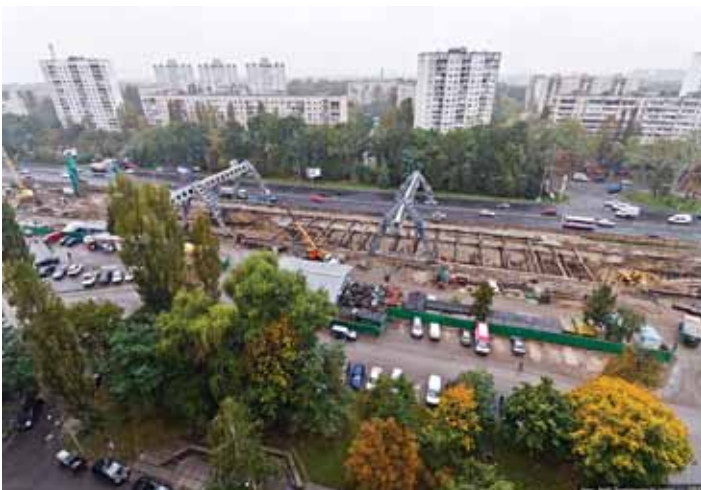
Строительство станции «Теремки»
