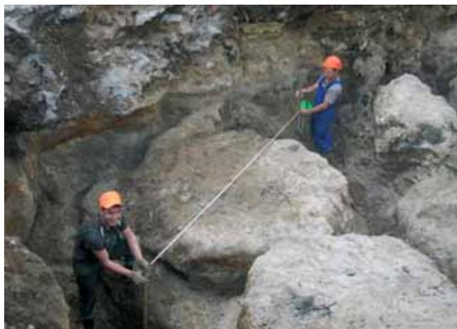
Рис. 2. Грунтоцементная колонна диаметром 3,5 м
