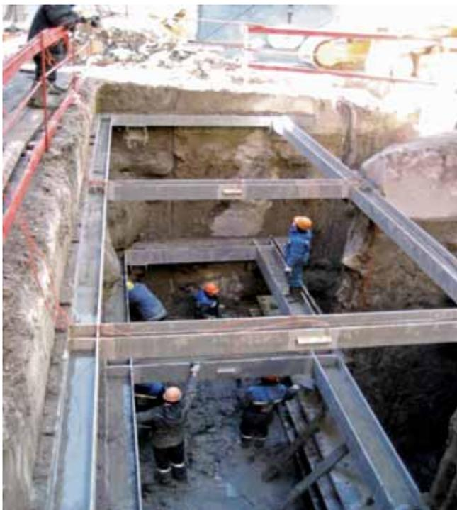
Здесь, на Зоологическом пер., впервые в Санкт-Петербурге «стена в грунте» была успешно выполнена сложной (тавровой) формы. Это открывает возможности освоения подземного пространства Санкт-Петербурга (работы вела компания «Геоизол», проектирование, расчеты и мониторинг – «Геореконструкция»)
