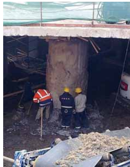
Рис. 2. Выполнение свайного основания, включающего сваи-колонны и дополнительные несущие сваи
