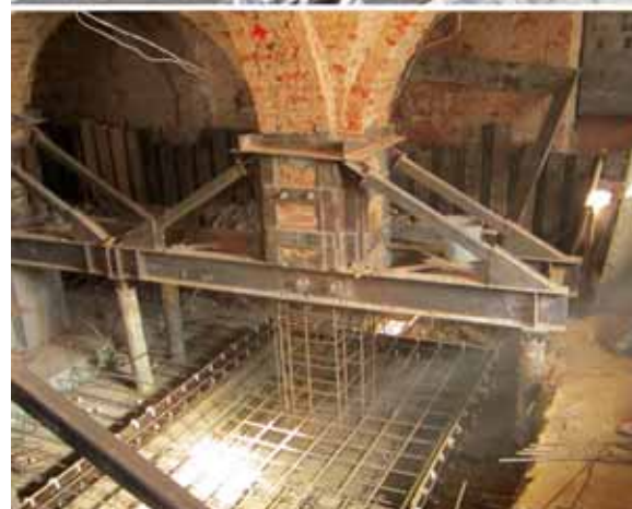
Рис. 10. Устройство фундаментной плиты с заведением фундаментов под колонны существующего здания
