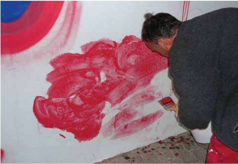
Удаление граффити с защитного покрытия Emserphob NanoPerm P
