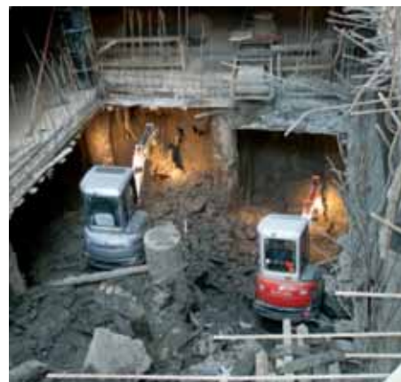
Рис. 4. Последовательная разработка грунта под защитой перекрытия с устройством плиты перекрытия следующего уровня фильтров
