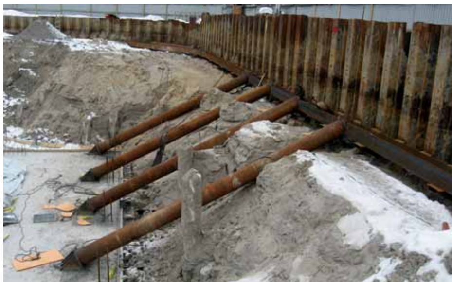
Рис. 7. Устройство наклонных металлических распорок
