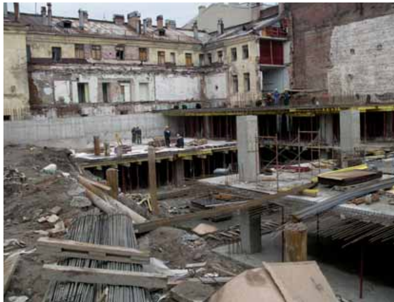
Рис. 6. Разработка грунта открытым способом в центральной части котлована
