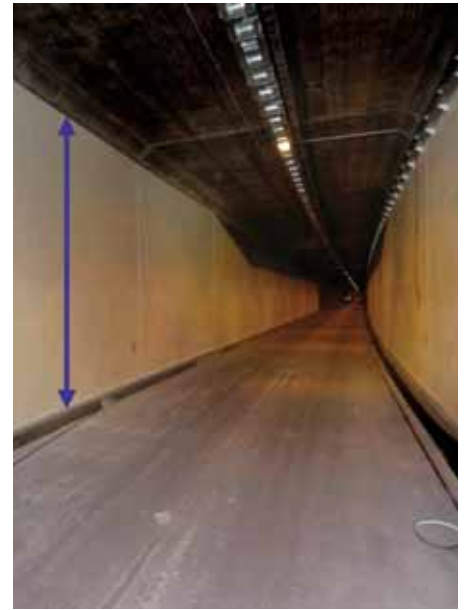
Стены тоннеля окрашиваются на высоту не менее 3 м
