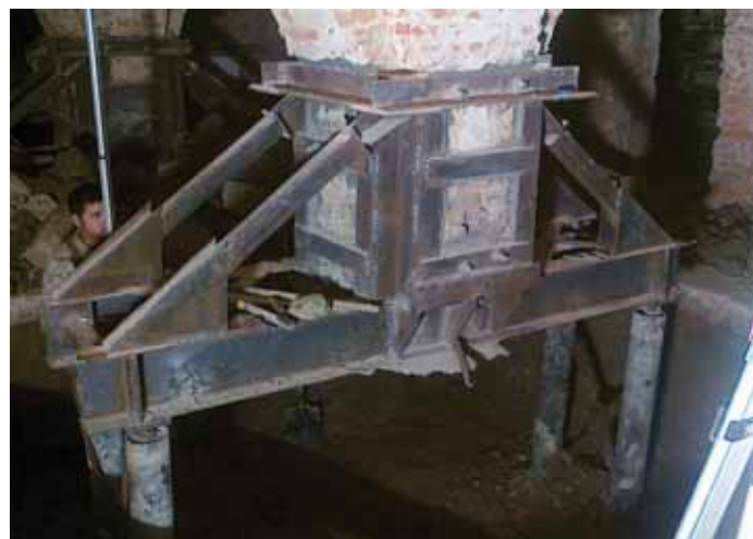
Рис. 9. Разработка грунта с одновременными работами по объединению свай в пространственные фермы
