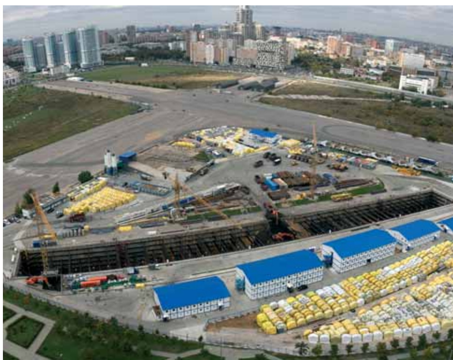
Панорама строительства ст. «Ходынское поле»
