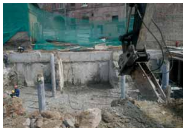
Рис. 3. Выполнение пионерного котлована открытым способом и понижение уровня грунтовых вод в контуре котлована посредством иглофильтров
