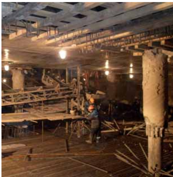
Рис. 5. Выполнение фундаментной плиты
