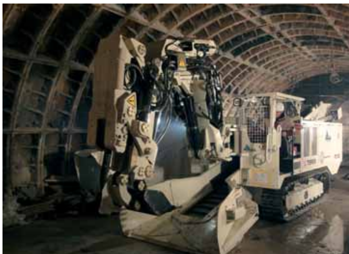
Рис. 3. Экскаваторный комбайн ИТС-120 на проходке Московского метро
