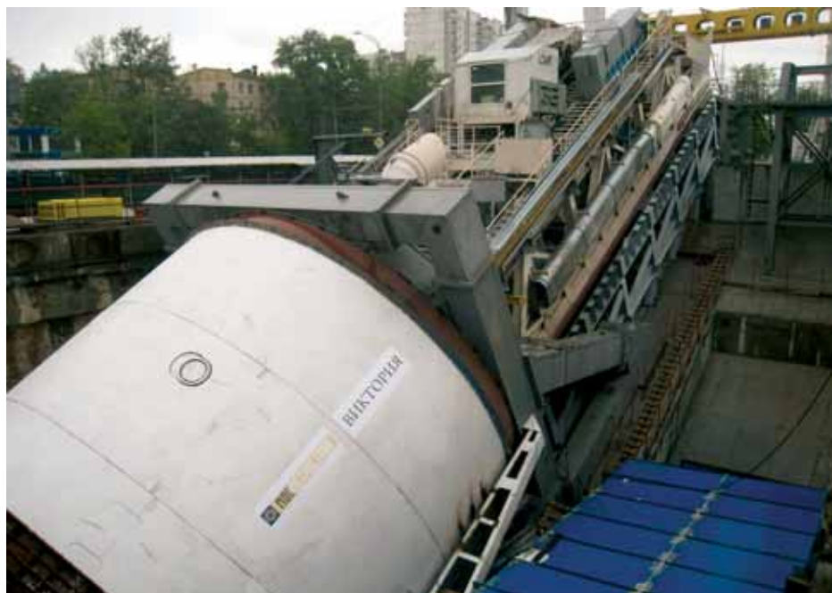
Рис. 5. Доработанный ТПМК RME 430 на строительстве 2-го наклонного хода станции «Марьино Роща»
