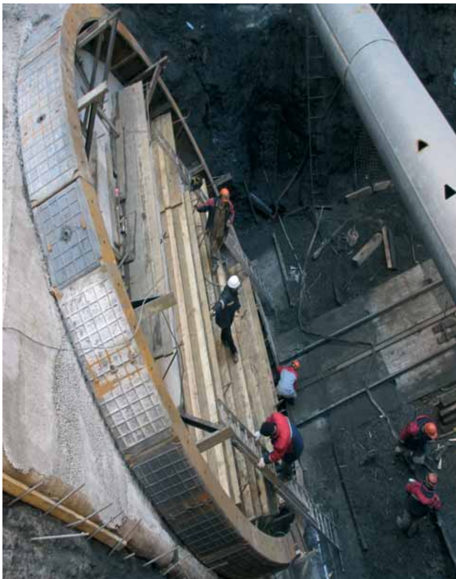
Строительство наклонного хода вестибюля станции «Парк Победы». Первые 37 колец будут смонтированы открытым способом, что позволит сократить срок выполнения работ
