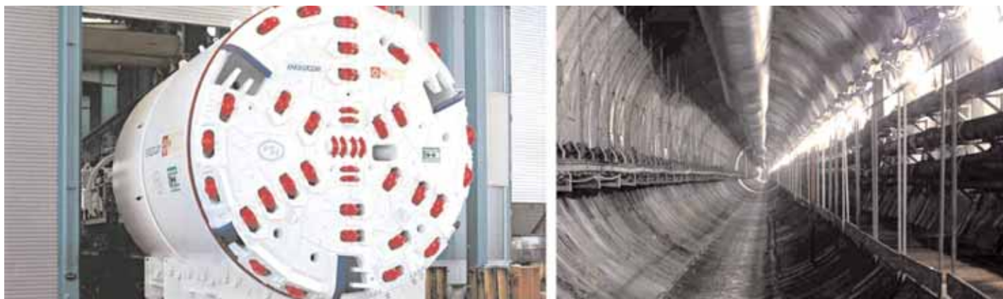
Рис. 6. Успешно завершено строительство тоннеля проекта «Мелен 7» (Истамбул, Турция). Тоннель расположен между Европой и Азией под проливом Босфор
