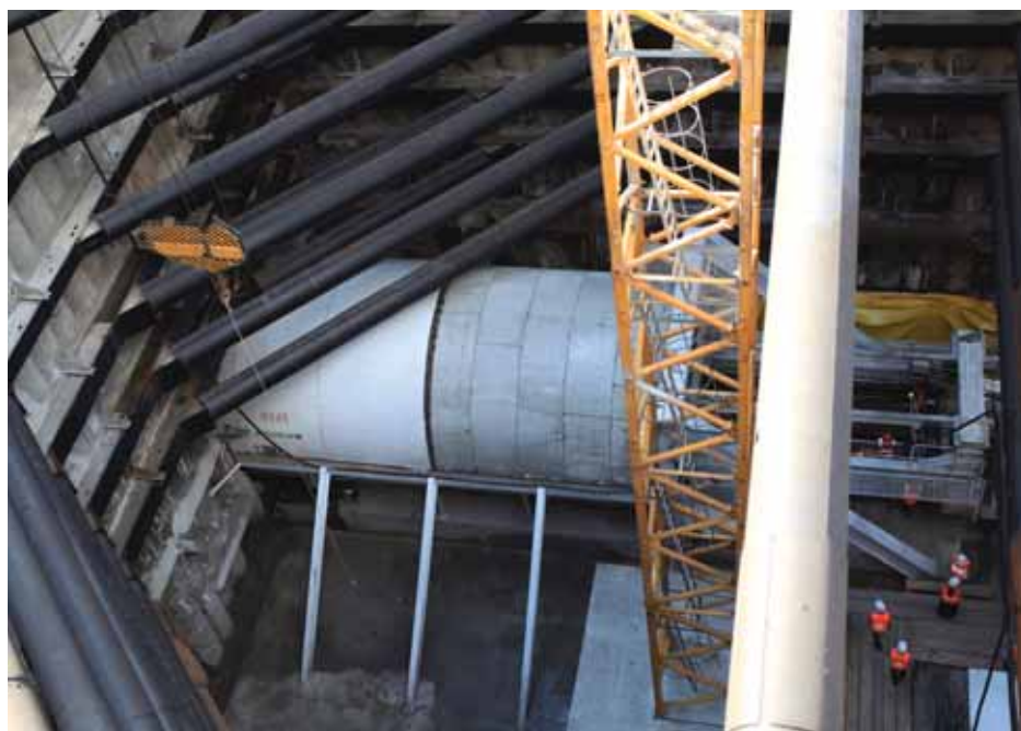
Начало проходки ТПМК Lovat со станции «Ходынское поле» в сторону «Хорошевской»
