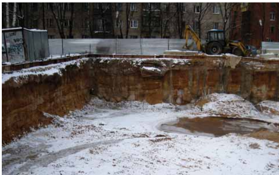
Рис. 8. Котлован, откопанный после контроля качества ультразвуковым способом
