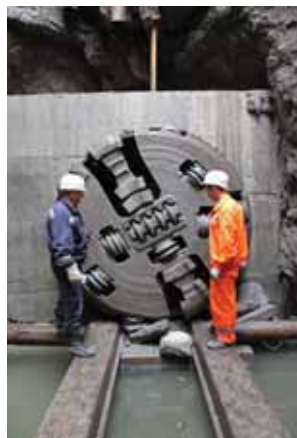
Тоннель под Сайменским каналом
