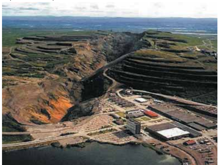
Рис. 2. Рудник Kiruna, Швеция. Крупнейший железорудный рудник в мире. В эксплуатации более 100 лет. Добыто 950 млн т железной руды. Длина рудного тела 4 км, толщина 80 м и 2 км глубина залегания. Общая протяженность выработок на 10 горизонтах – 400 км
