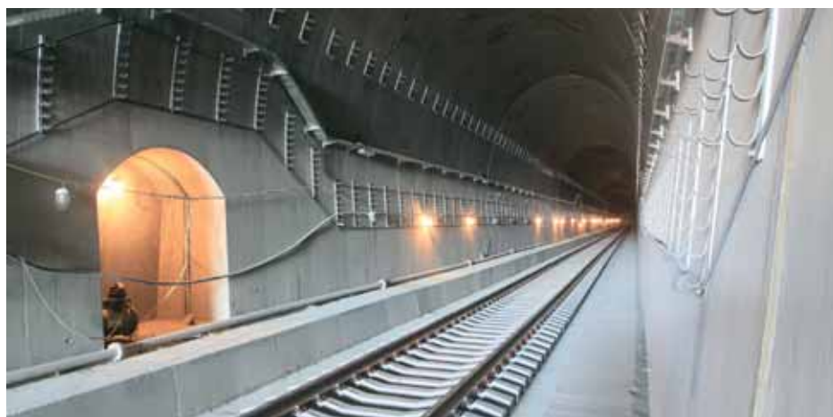
Железнодорожный тоннель №1 трассы Адлер – «Альпика-Сервис»
