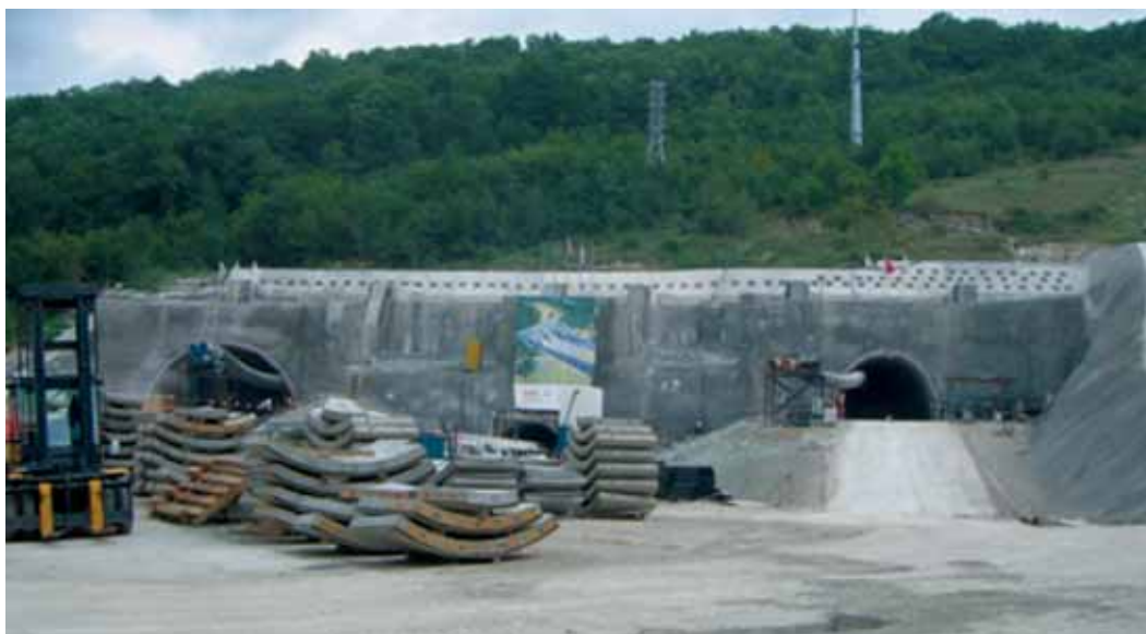
Рис. 3. Совмещенная (автомобильная и железная) дорога Адлер – «Альпика-Сервис». Сооружение шести тоннельных комплексов общей длиной тоннелей 29,4 км
