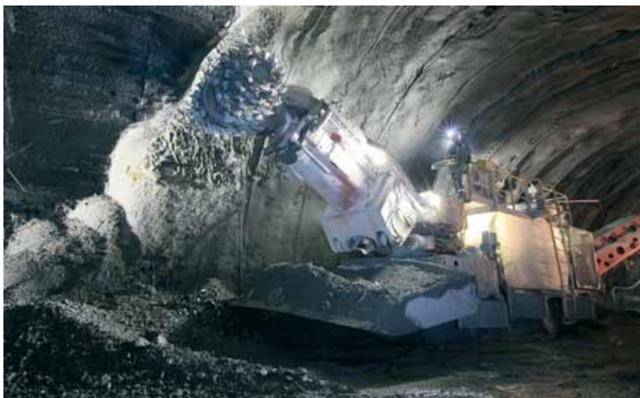
На проходке Рокского тоннеля
