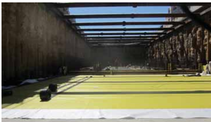
Разбивка гидроизоляционного ковра на секции гидрошпонкой Sika® Waterbar AR-31
