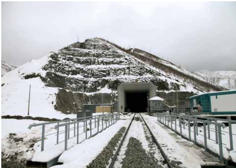
Кузнецовский железнодорожный тоннель. Готов к сдаче
