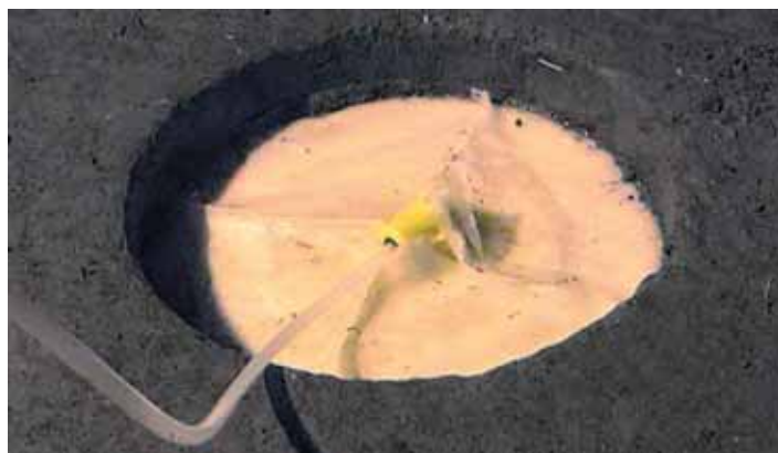
Контрольно-инъекционный штуцер с трубкой, впаянный в мембрану гидроизоляции
