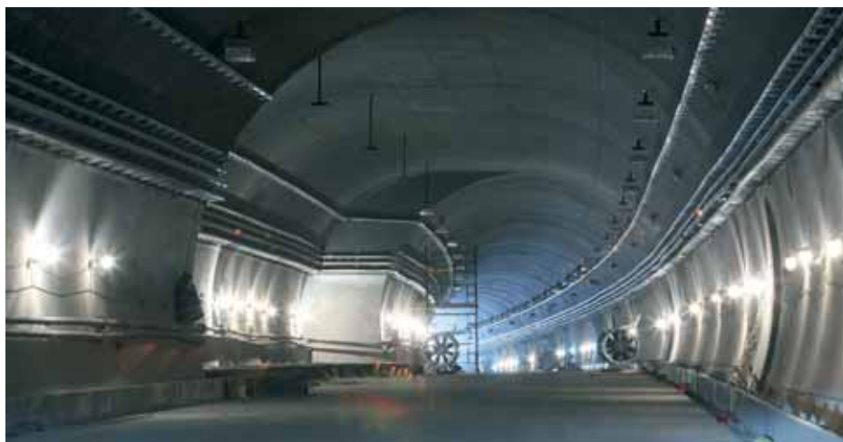
Автомобильный тоннель № 3 трассы Адлер – «Альпика-Сервис»
