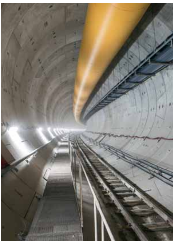
Участок готового тоннеля
