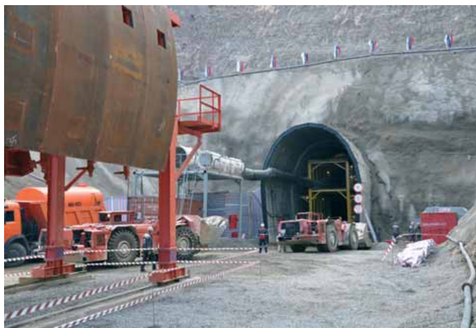
На строительстве Облучинского тоннеля
