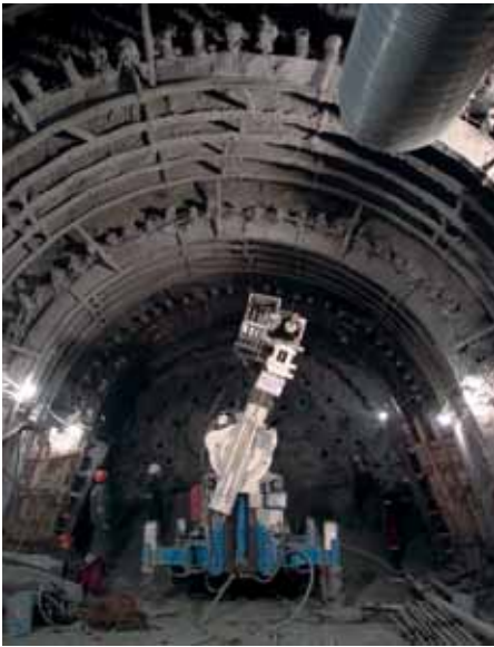
Рис. 10. Опережающее крепление свода и лба забоя при строительстве руддвора шахты № 620
