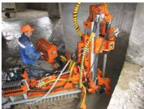
Рис. 6. Буровая установка Figaro Maschine FM T400 на строительном объекте
