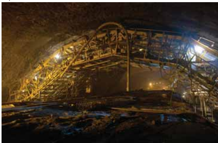
Строительство станции «Чкаловская»
