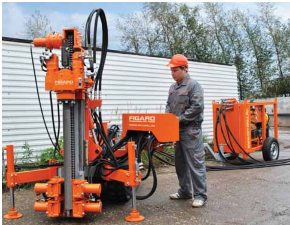
Рис. 1. Буровая установка Figaro Maschine FM T400
