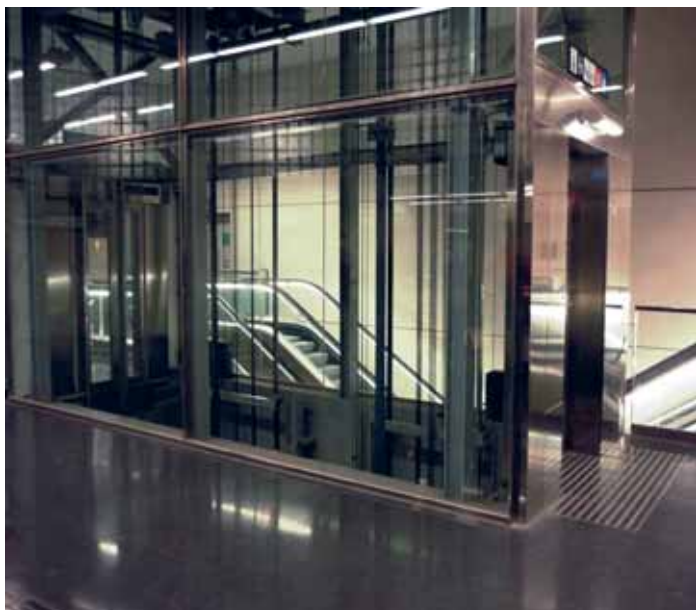
Фрагмент интерьера вестибюля станции «Сингуэрлин» 9-й ветки Барселонского метрополитена
