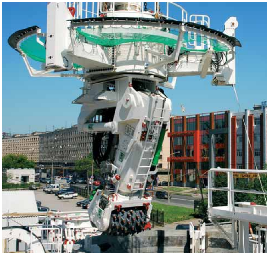
Строительство шахтного ствола для водоотведения, Санкт-Петербург
