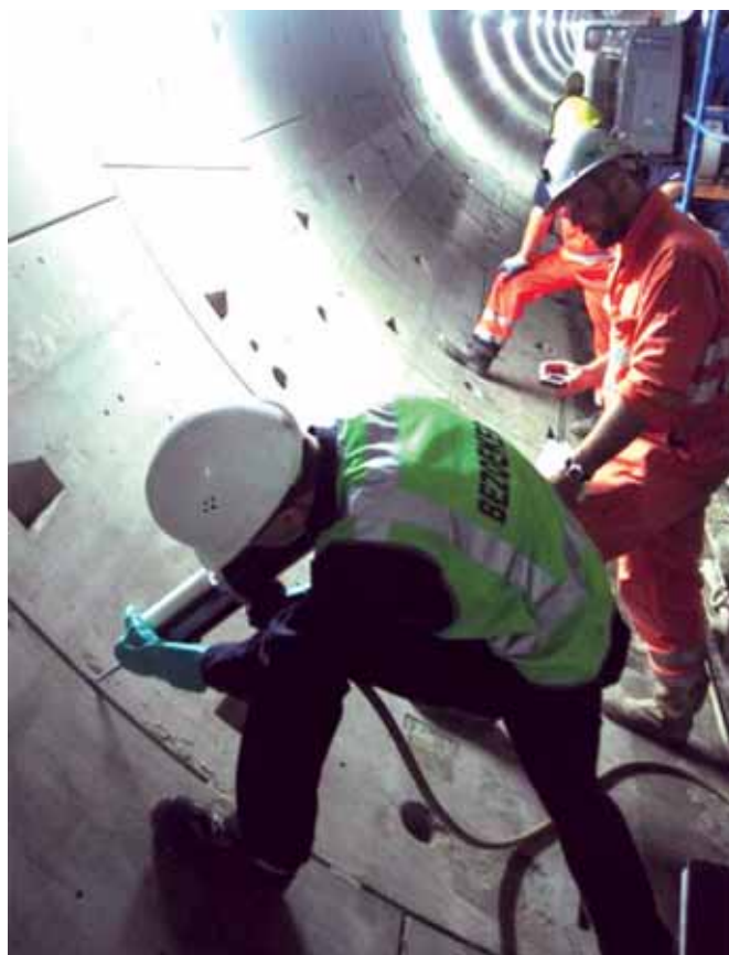
Применение системы MC-Fastpack в метро Амстердама на линии Nord-Süd
