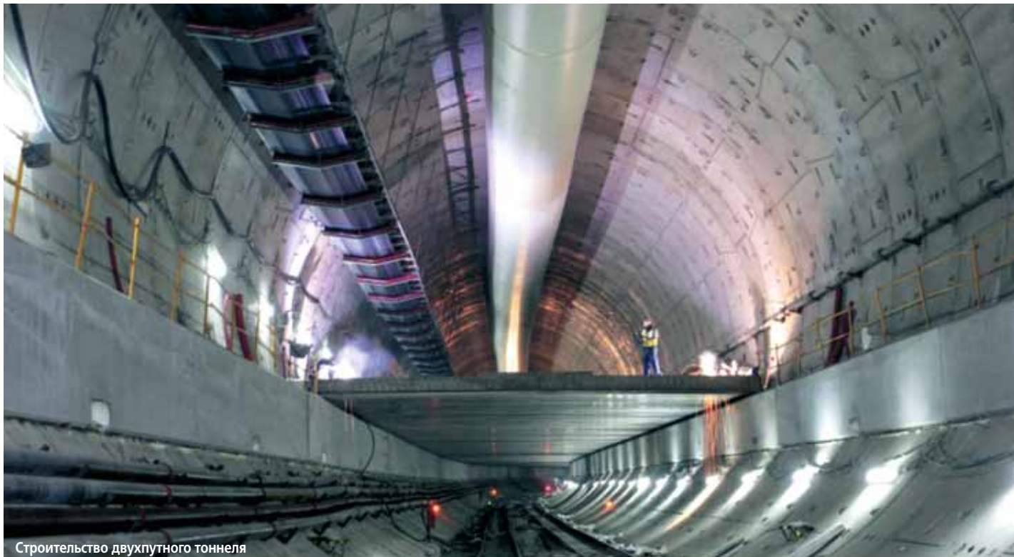
Строительство двухпутного тоннеля
