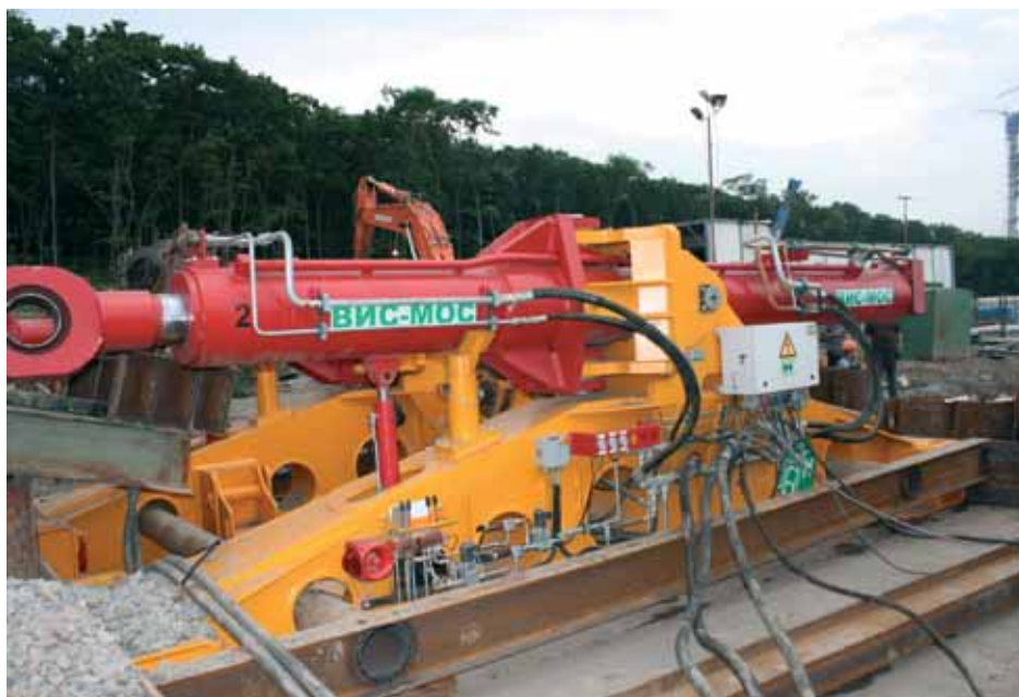
Прокладка газопровода под дном пролива Босфор Восточный на остров Русский
