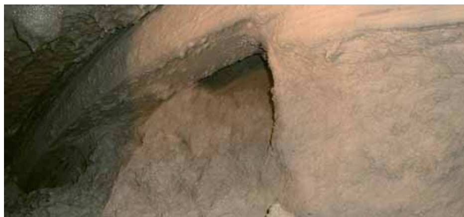
Обработанный грунт пеной фирмы «Кондат» в призабойной камере
