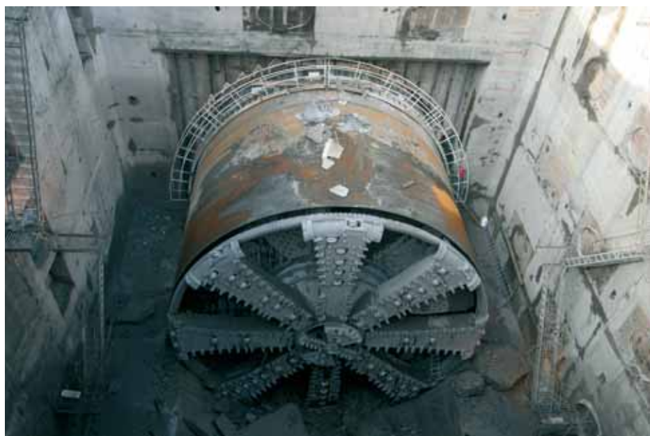
Выход щита диаметром 14,2 м в демонтажную камеру на строительстве Серебряноборских тоннелей
