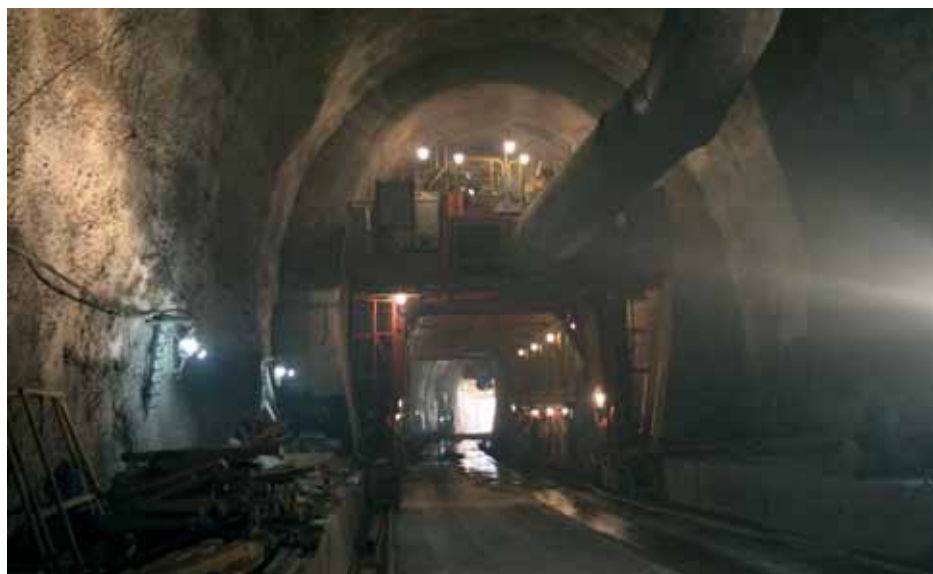
Механизированная опалубка для возведения постоянной обделки тоннеля
