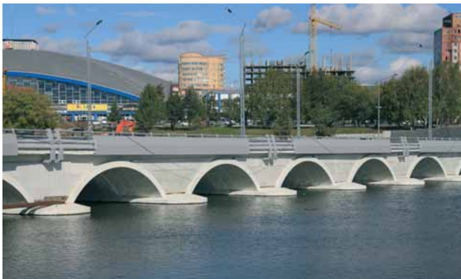
Транспортно-пешеходный мост через р. Миасс
