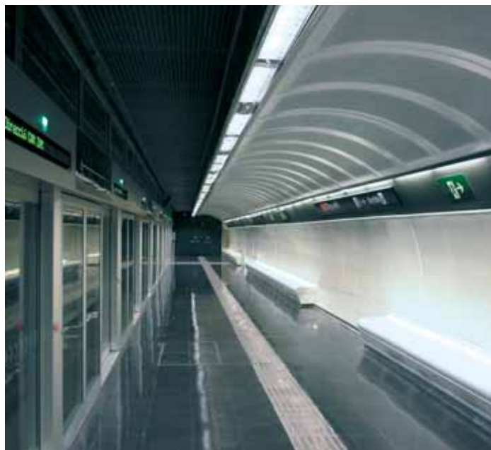
Интерьер станции «Сингуэрлин» 9-й ветки Барселонского метрополитена
