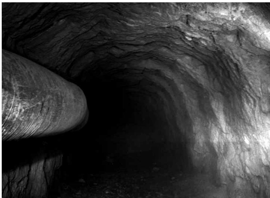
Иллюстрация влияния НДС массива на формирование зоны дробления и откола вблизи контурных зарядов
