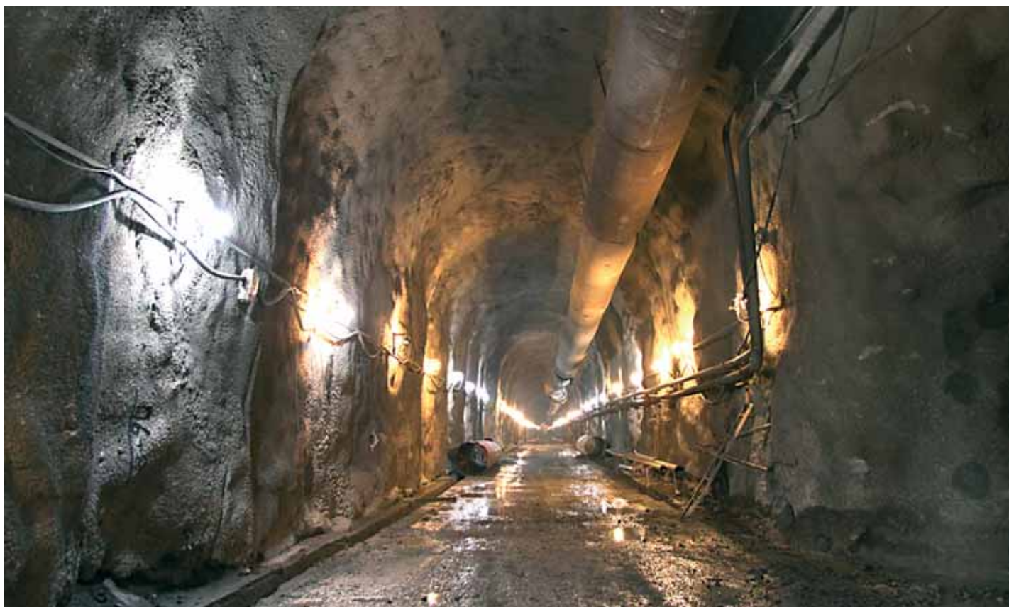
Иллюстрация уступного характера продольного контура тоннеля
