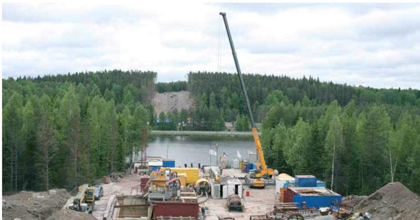
Прокладка газопровода под Сайменским каналом (первый тоннель), Ленинградская область
