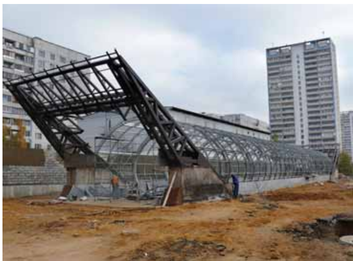
Строительство наземного вестибюля станции «Строгино»
