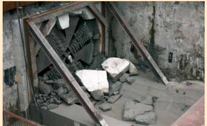
Окончание проходки и выход ТПМК в демонтируемую камеру
