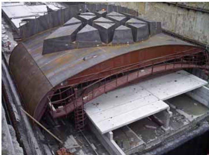
Передвижная механизированная опалубка для свода станции «Строгино»
