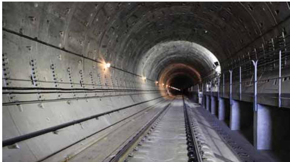
Крольский тоннель на линии Абакан – Тайшет
