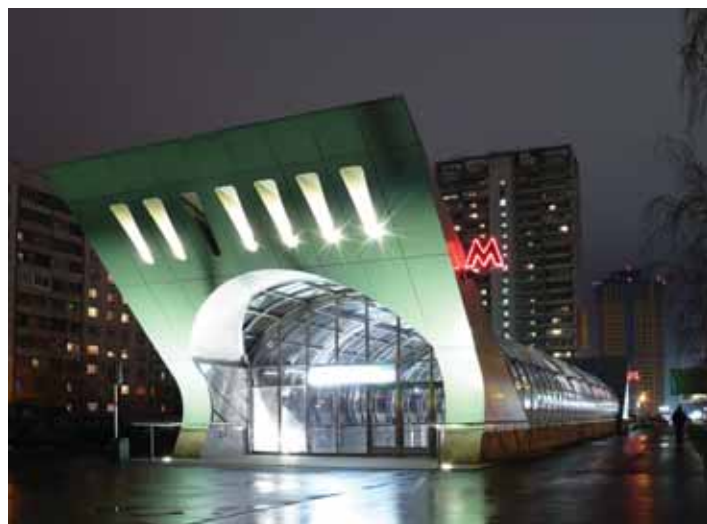
Наземный вестибюль станции «Строгино»
