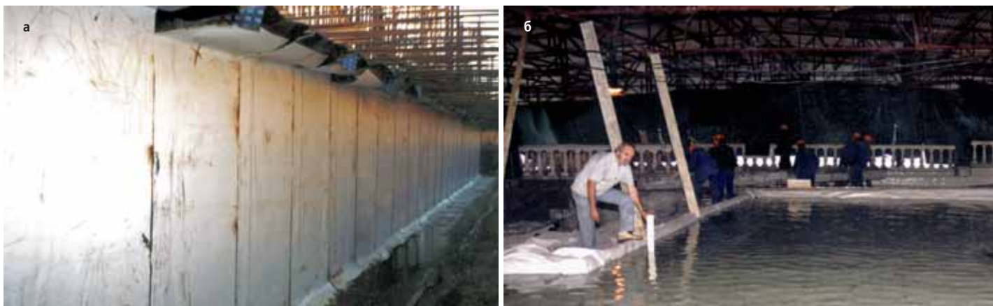
Рис. 1. Производство работ по устройству гидроизоляции ПВХ мембраной «Кровлелон» НПК «Гидрол-Руфинг»: а – ММДЦ «Москва-Сити», ст. метро «Выставочная»; б – торговый комплекс «Охотный Ряд», испытания гидроизоляционного материала
