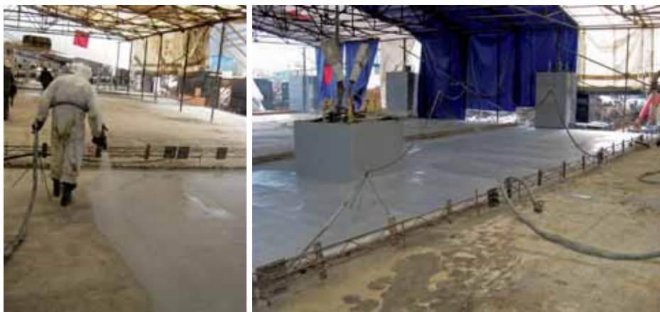
Рис. 3. Производство работ по устройству гидроизоляции на опытном участке станции метро «Мякинино» составом «Экстраплан 502» ЗАО «Хантсман-НМГ»
