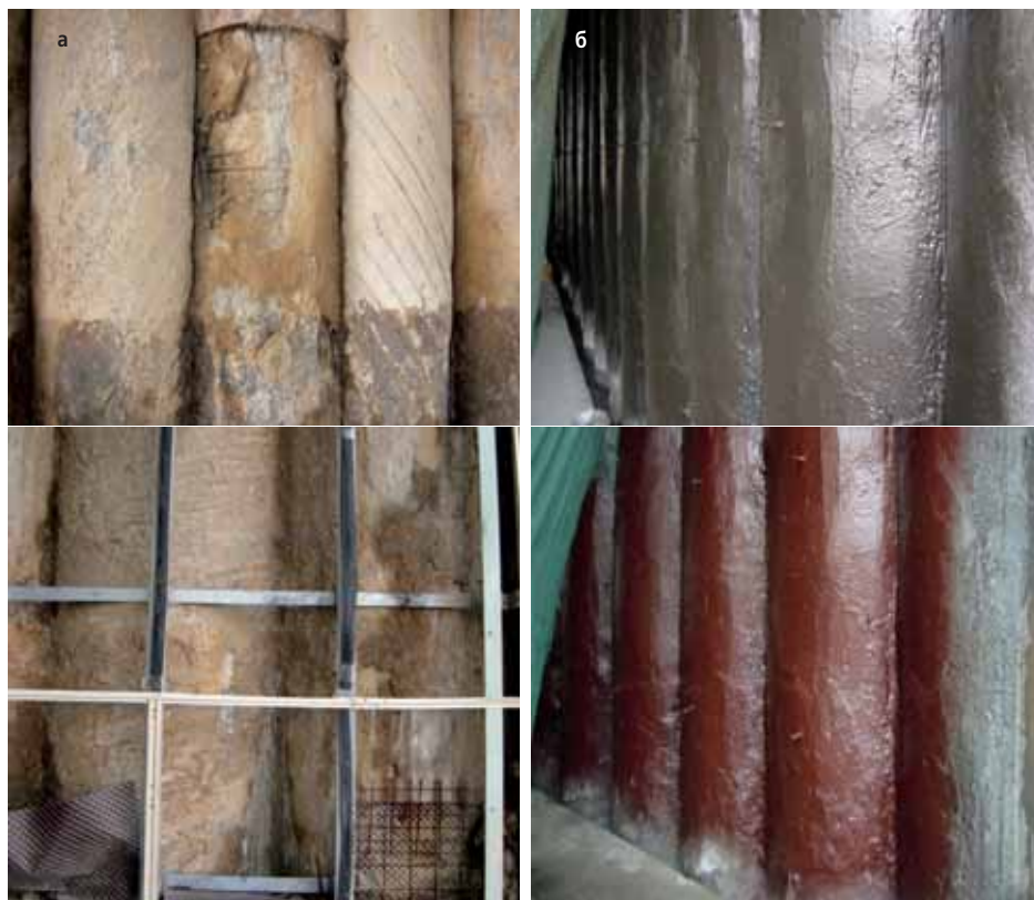
Рис. 2. Восстановление гидроизоляции тоннеля на Боровском шоссе (Москва) составом ТФ-1 ЗАО НПО «НовТехСтрой»: а – до выполнения ремонтно-восстановительных работ; б – после нанесения состава ТФ-1
