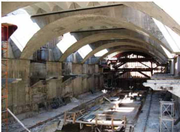
Строительство зала станции «Зябликово»
