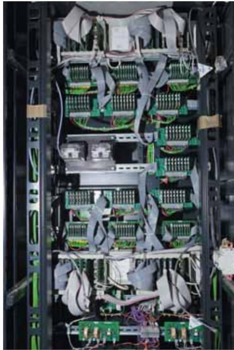
**Шкаф с системой микропроцессорной централизации**
