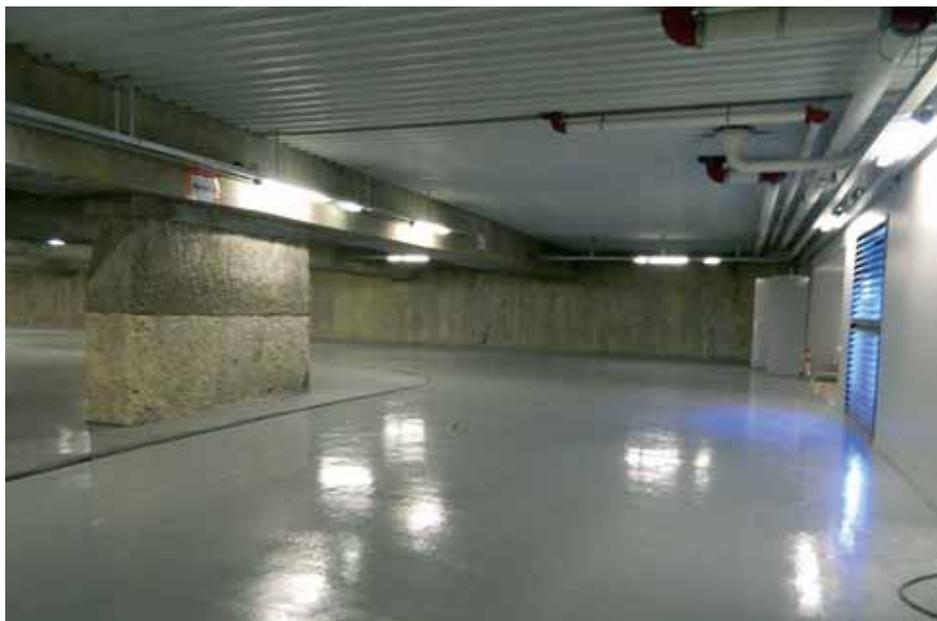
Внутренний вид пятиэтажного подземного паркинга в Париже, построенного компанией Vinci с возведением «стены в грунте» в качестве несущей конструкции
