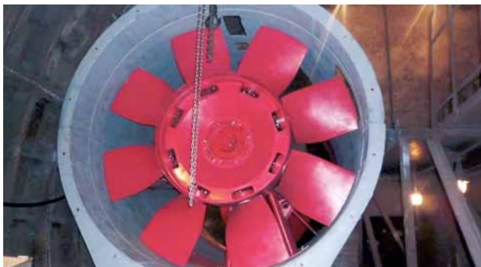
Рис. 5 Модернизация вентилятора WOMД 24 на Петербургском метрополитене
