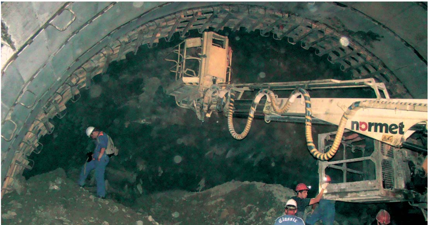
Рис. 1. Регистрация ЕЭМИ в забое строящегося автодорожного тоннеля № 1 на трассе Адлер – «Альпика-Сервис»
