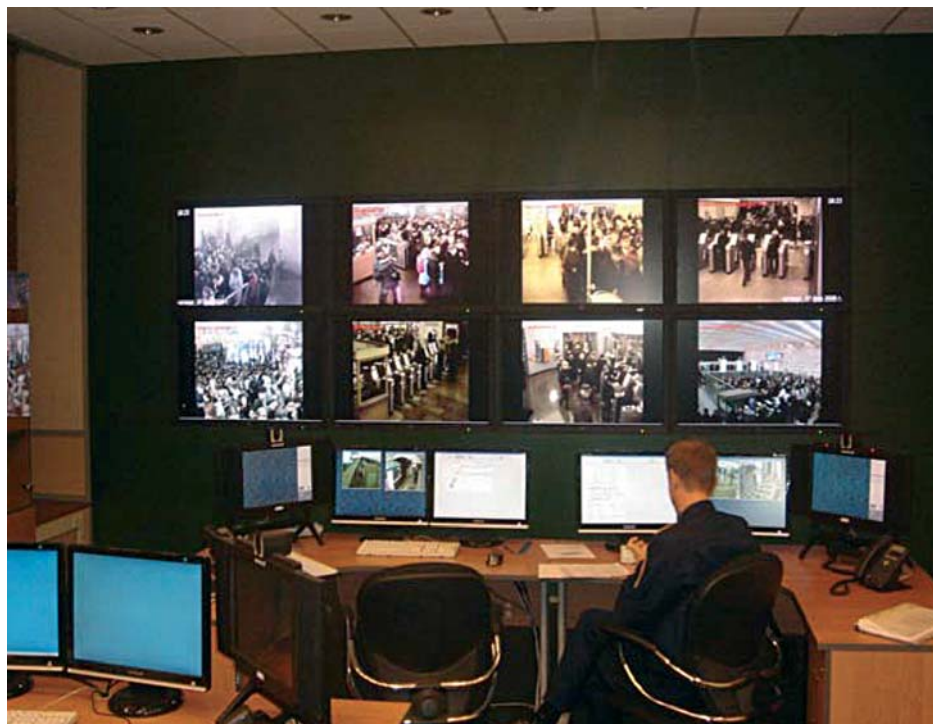
Рис. 1. Ситуационный центр КАСИП АЗМ
