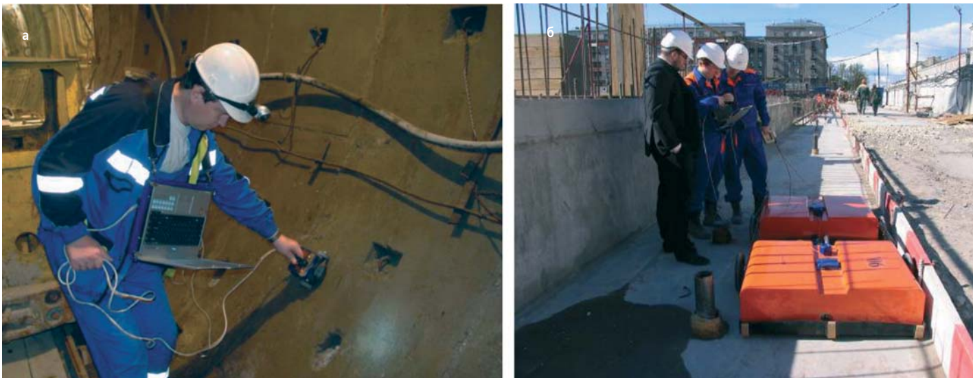
Рис. 6. Оценка качества ограждения котлована из грунтоцементных свай (а) и состояния грунтового массива за обделкой тоннеля с помощью георадара
