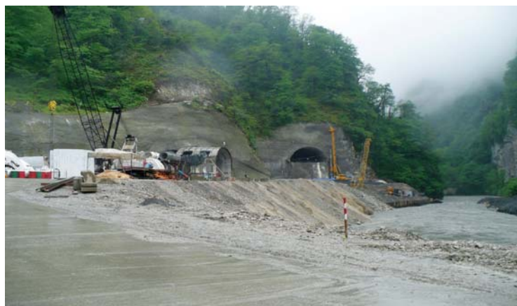
Рис. 3. Строительная площадка на северном портале автодорожного тоннеля № 3 и сервисного тоннеля
