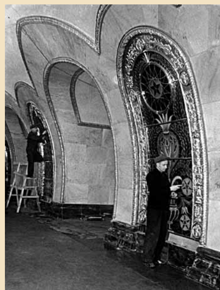
Станция «Новослободская». Отделка витражей, июль 1951 г.
