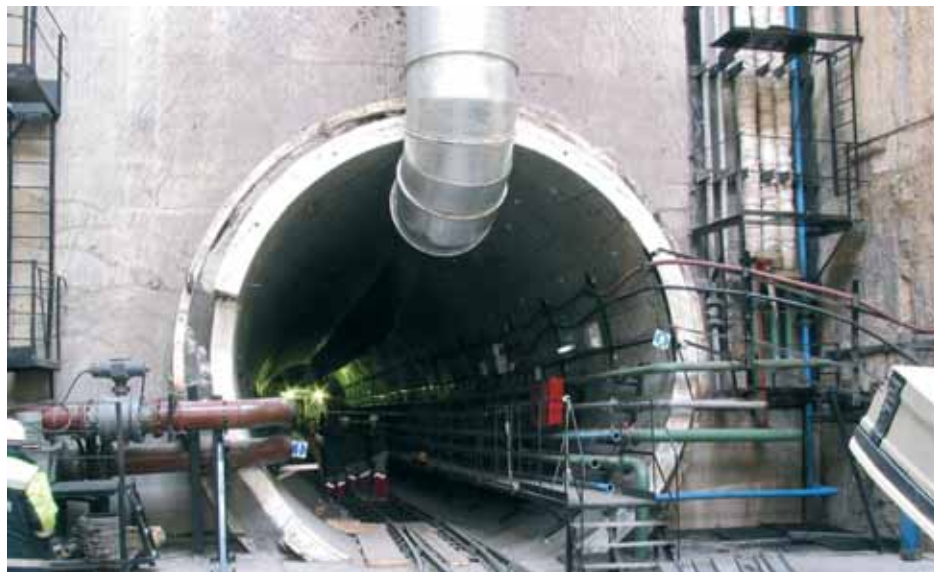
Проходка сервисного тоннеля в Серебряном Бору
