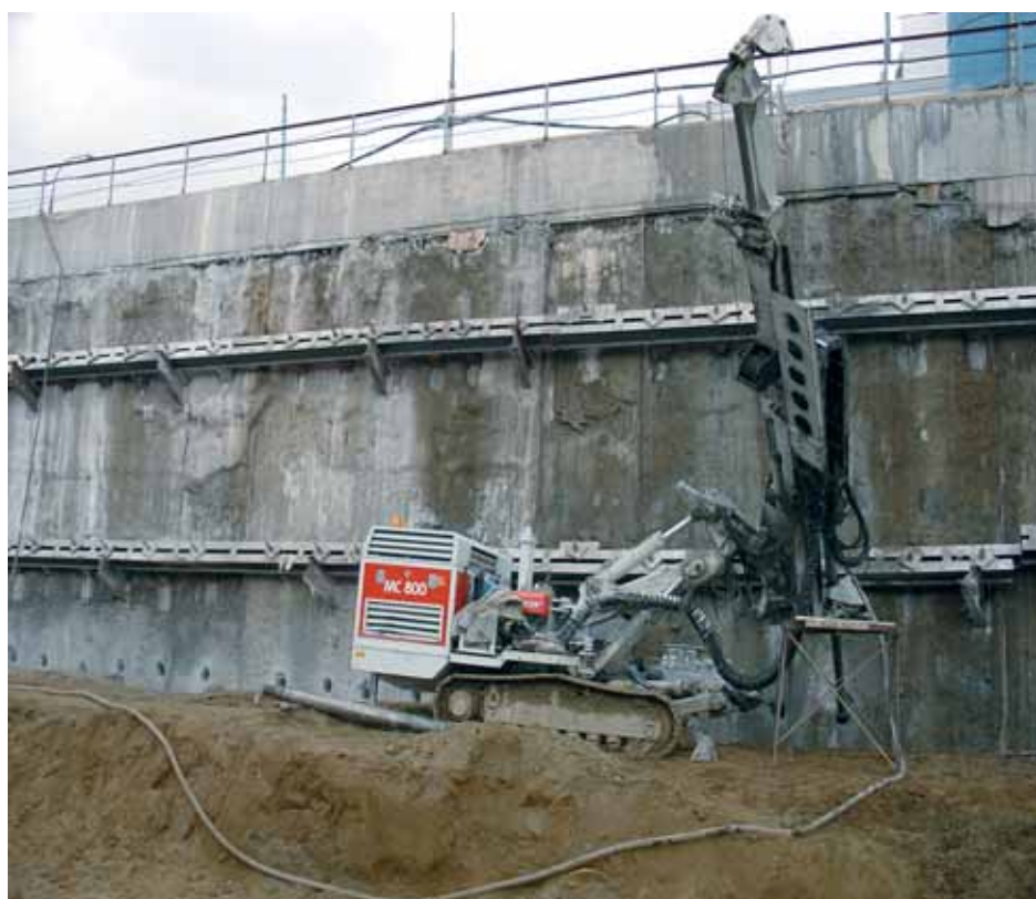
Буровой станок Comacchio MC-80 для установки анкеров
