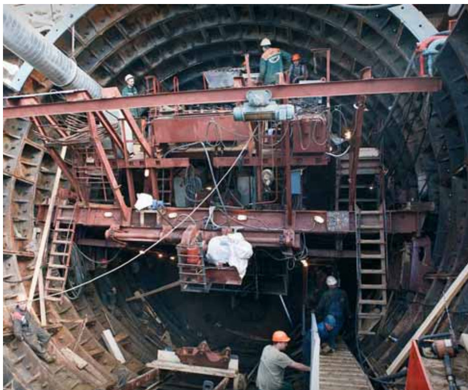
Сооружение наклонного хода на станции «Сретенский бульвар»
