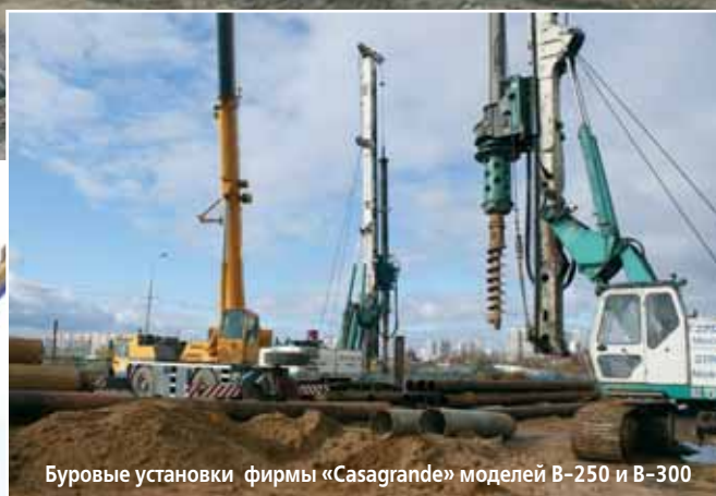
Устройство буронабивных свай на рамповой части тоннеля под Финским заливом
