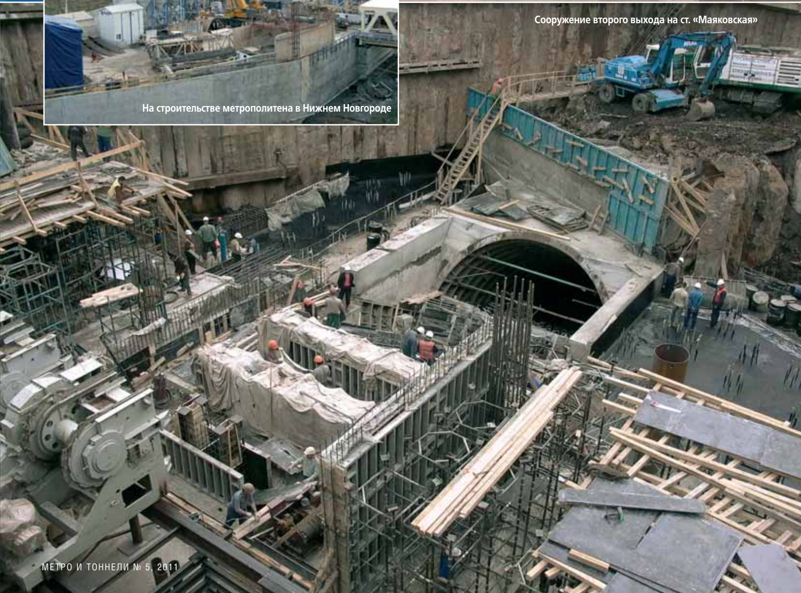
Начало проходки наклонного хода с помощью ТПМК «Ловат» на ст. «Марьяна Роцца»
