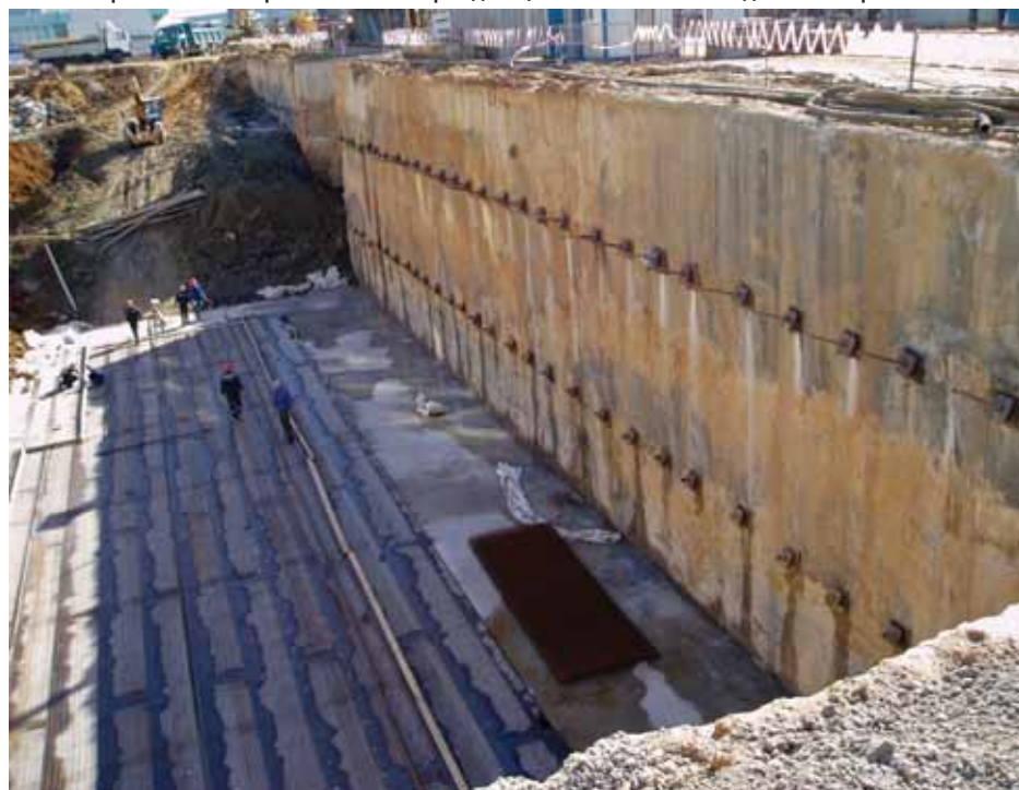
Рис. 3. Закрепленная анкерными сваями ограждающая стена котлована подземного терминала АВК-1
