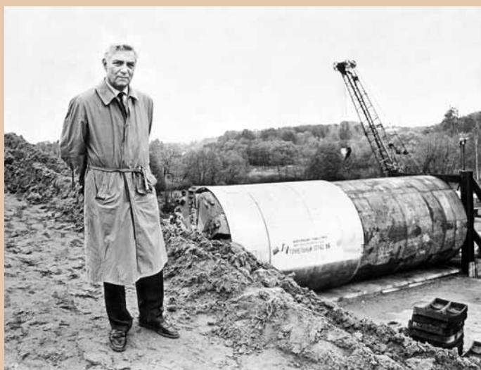
Начало врезки щита фирмы «Ловат» для строительства тоннеля под железной дорогой в Москве, октябрь 1994 г.
