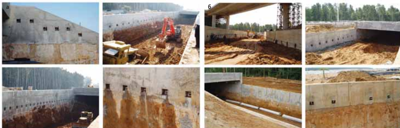
Рис. 1. Постоянное крепление анкерными сваями при реконструкции Киевского шоссе: а – откосные и подпорные стены путепроводов тоннельного типа на ПК101+21 и на съезде №8; б – рамповые подпорные стены тоннеля на съезде № 3
