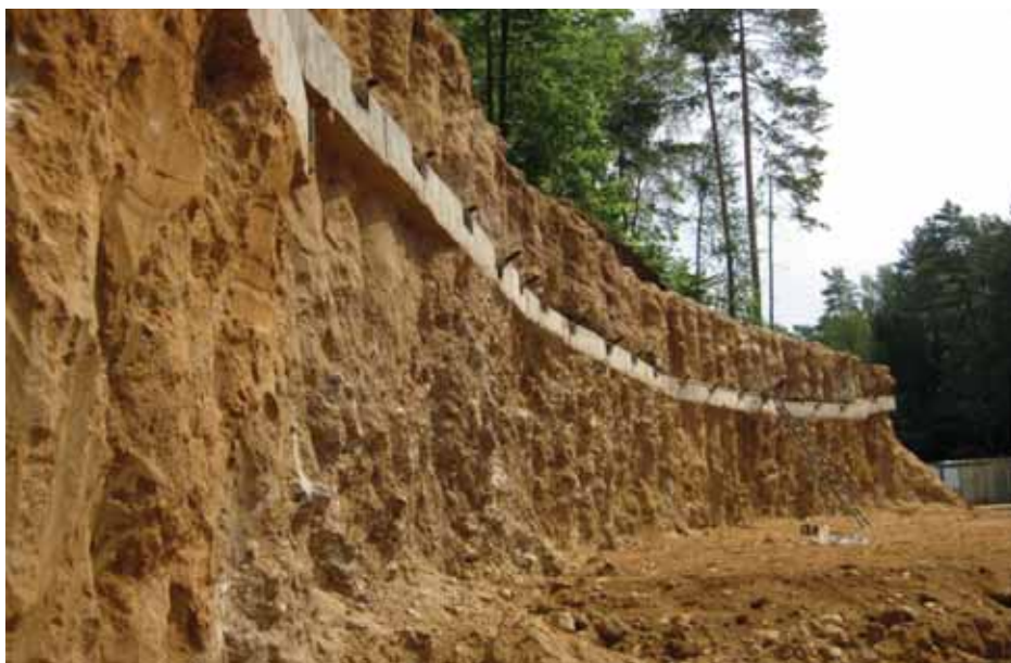
Укрепление подпорной стены анкерами «Атлант»
