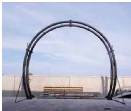
Рис. 7. Трубчатые арки жёсткости B.Zero Tondo
