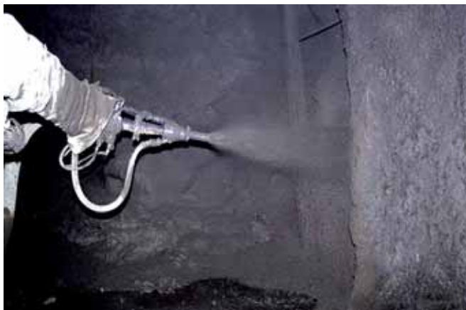
Рис. 3. Набрызг-бетон
