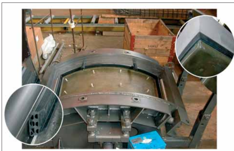
Рис. 7. Изготовление блока с антикоррозионной защитой
