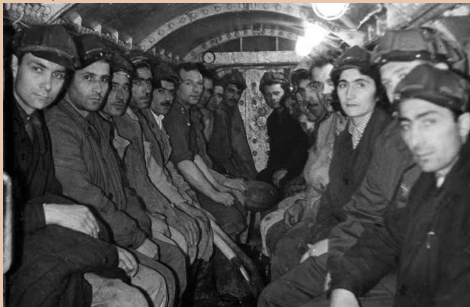
Группа рабочих и инженеров, отобранных для работы в кесоне на строительстве Бакинского метрополитена, апрель 1963 г.
