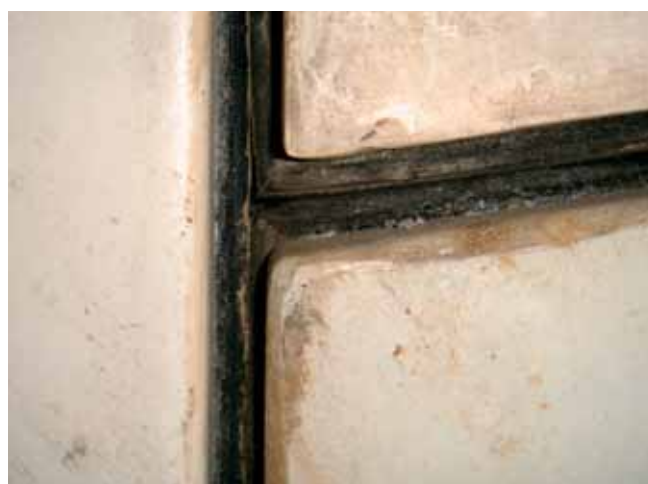
Рис. 8. Т-образный стык с внутренней обделкой из стекловолокна и интегрированными уплотнителями
