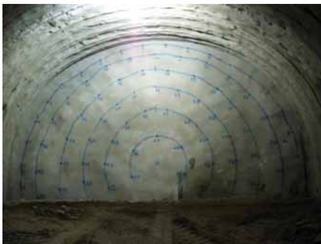
Рис. 4. Стабилизация лба забоя при помощи установки стекловолоконных труб
