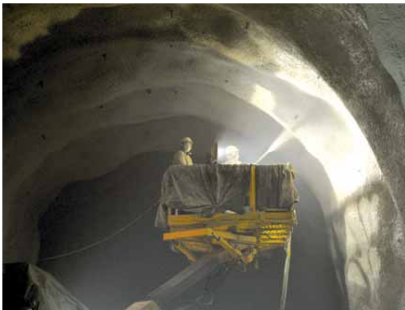
Нанесение мембраны в ручном режиме
