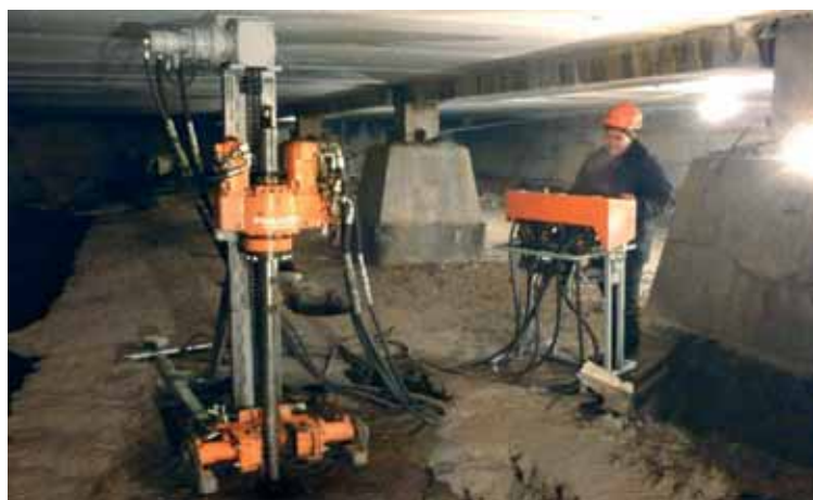
Рис. 2. Производство работ в г. Набережные Челны
