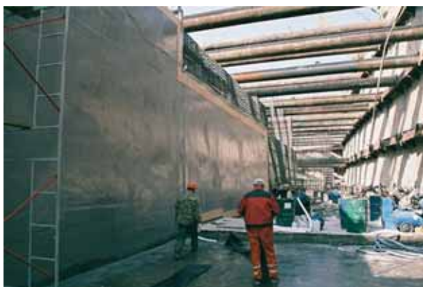
Гидроизоляция стен материалом «Экстрплан-502»
