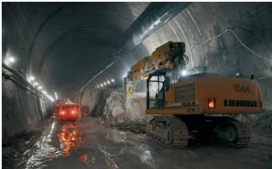
Рис. 2. Доработка уступа подземным экскаватором
