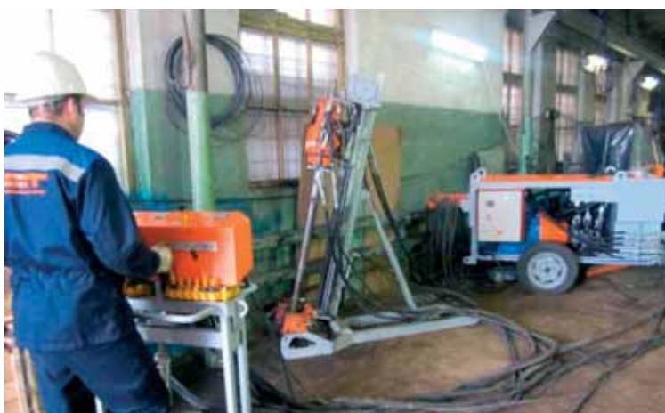
Рис. 3. Производство работ в действующем цехе с электрической масляной станцией
