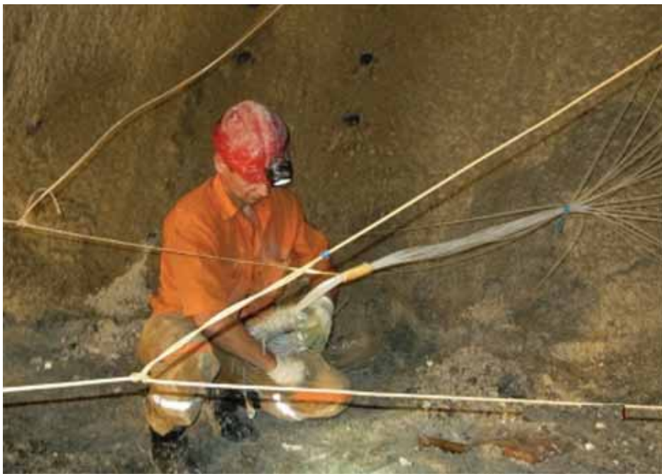
Рис. 4. Монтаж взрывной сети неэлектрической системы инициирования
