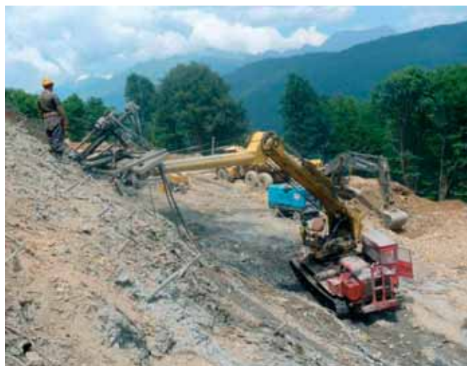
Рис. 4. Установка нагелей Figaro Maschine
