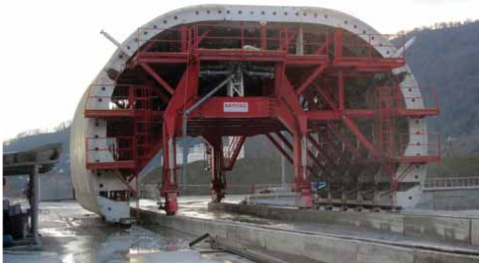
Рис. 6. Самоходная металлическая опалубка «BAYSTAG»
