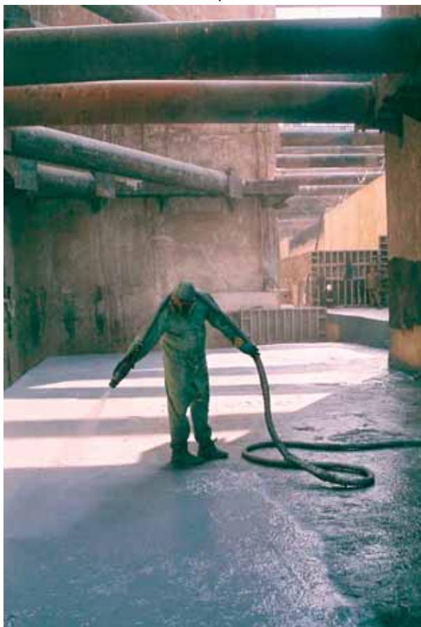
Нанесение полимочевиновой гидроизоляции
