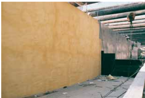
Защита гидроизоляции полиуретаном
