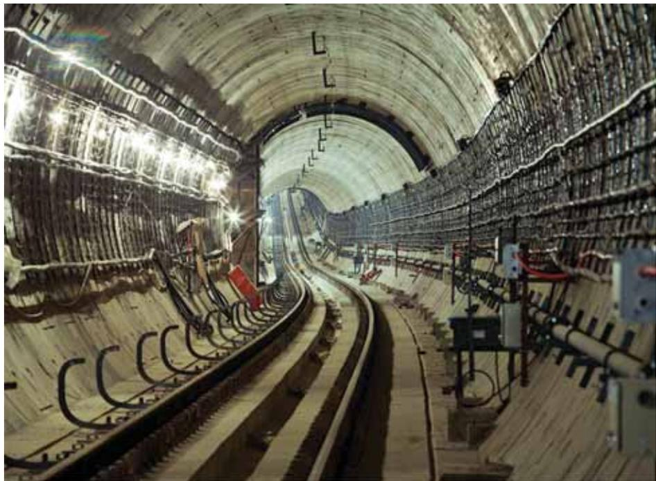
**Рис. 8. Конструкция пути со скреплениями типа ВГС**
