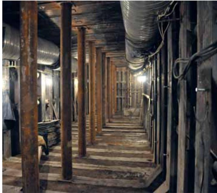
Рис. 7. Проходка штольни в закрепленном массиве
