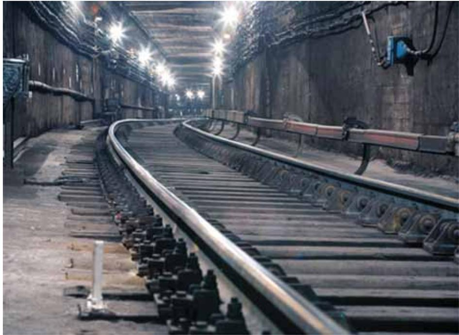
**Рис. 7. Скрепление ВГС, установленное на Сокольнической линии Московского метрополитена**
