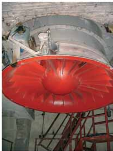
Рис. 1. Вентилятор ВО-21ВК вертикального и ВО-21К горизонтального исполнения
