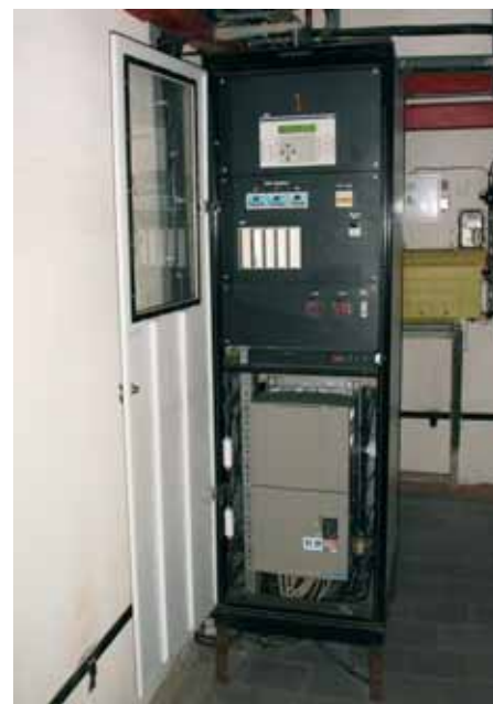
Рис. 3. Система автоматического управления вентилятором
