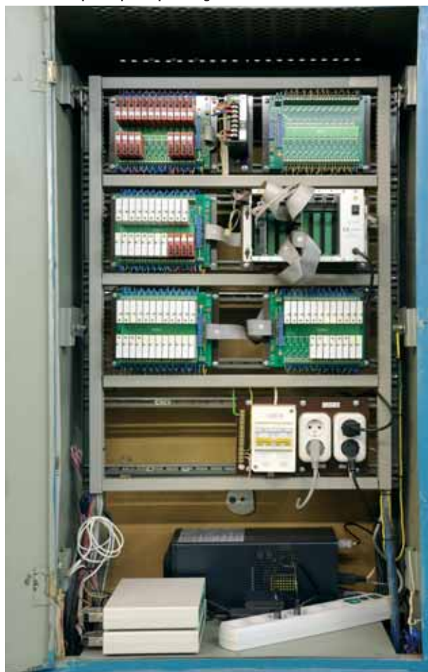
Рис. 1. Шкаф контроллера Octagon
