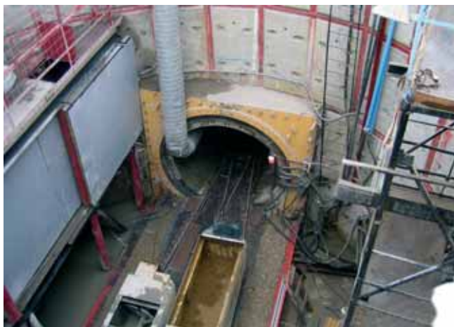
Монтажная камера для механизированного тоннелепроходческого комплекса
