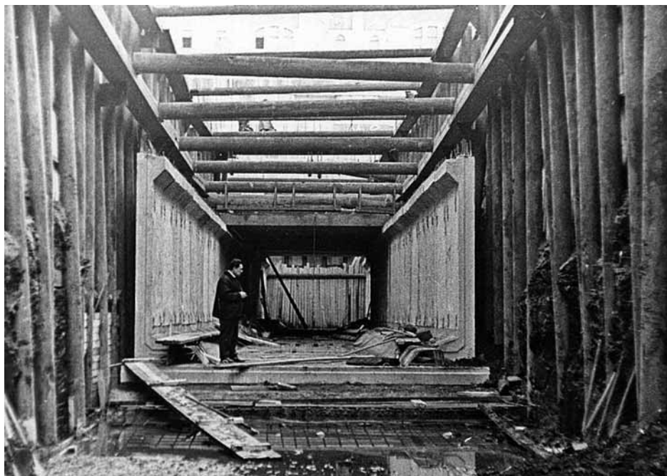
Строительство коллектора в котловане в конце XX века
