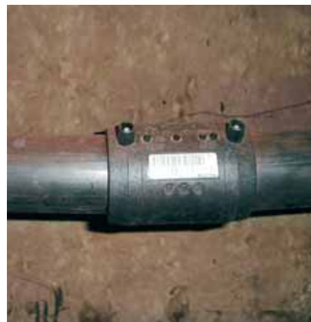
Рис. 1. Фитинги с закладными электронагревателями
