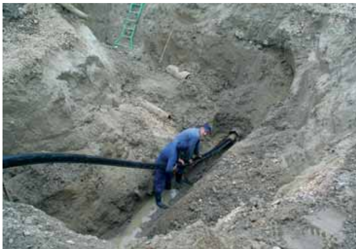
Рис. 3. Замена водопроводных труб в электродепо «Ельцовское»
