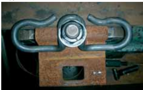
Упругие клеммы типа Skl 12-32
