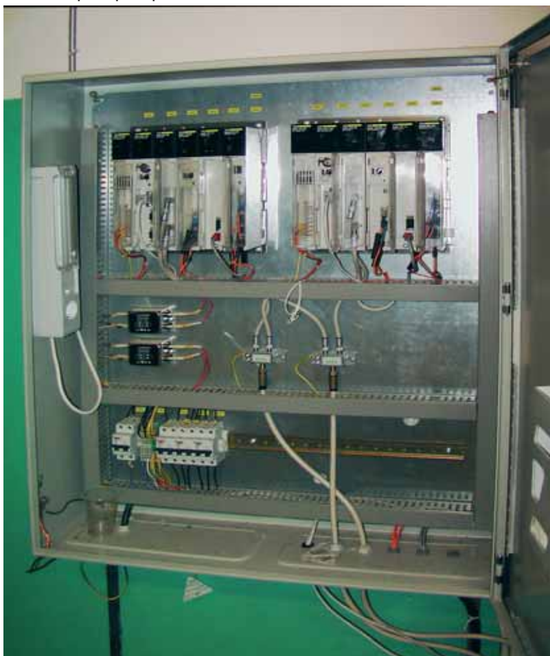
Рис. 2. Шкаф контроллера Quantum
