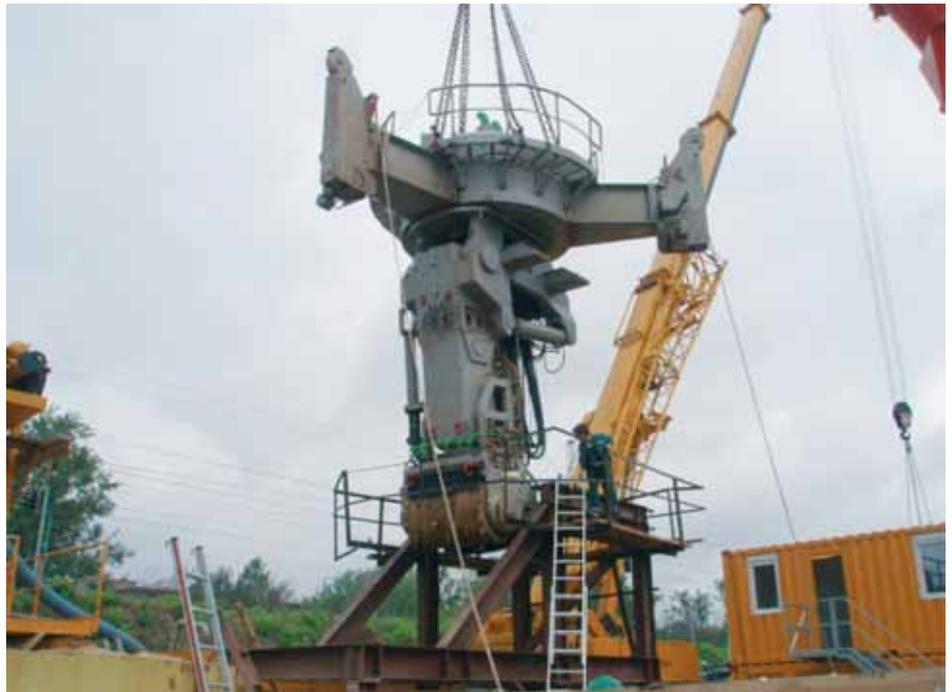
Стволотранспортная машина фирмы «Херренкнехт» для проходки ствола № 463 – стадия монтажа
