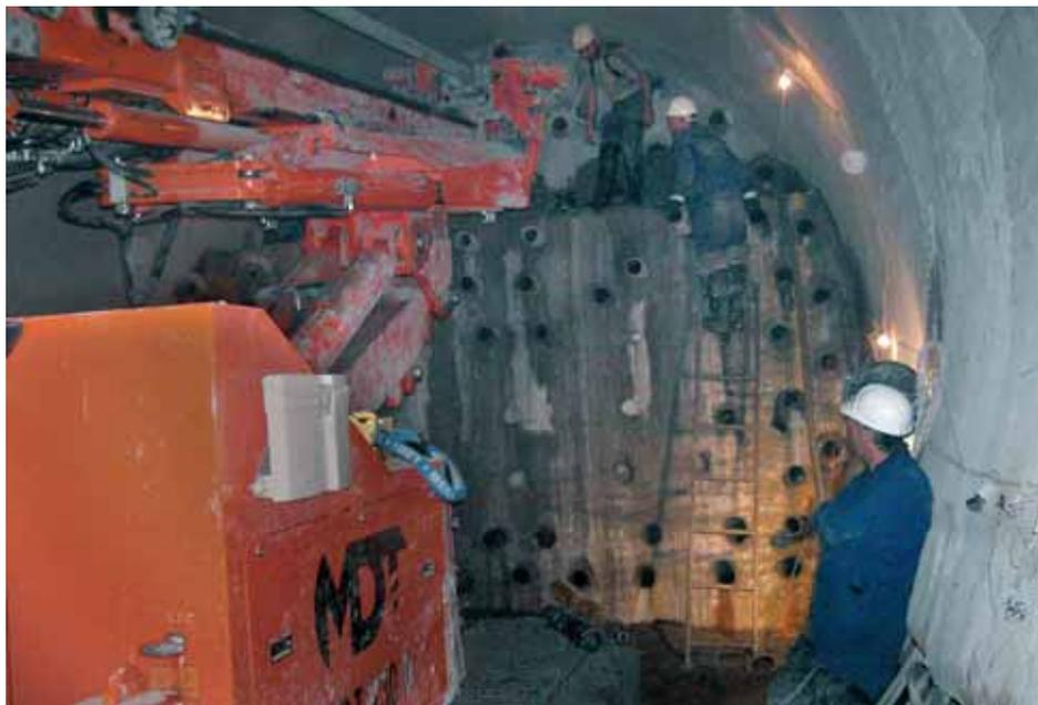
**Закрепление грунта в забое методом Jet-grouting буровым станком МДТ 230КВР**
