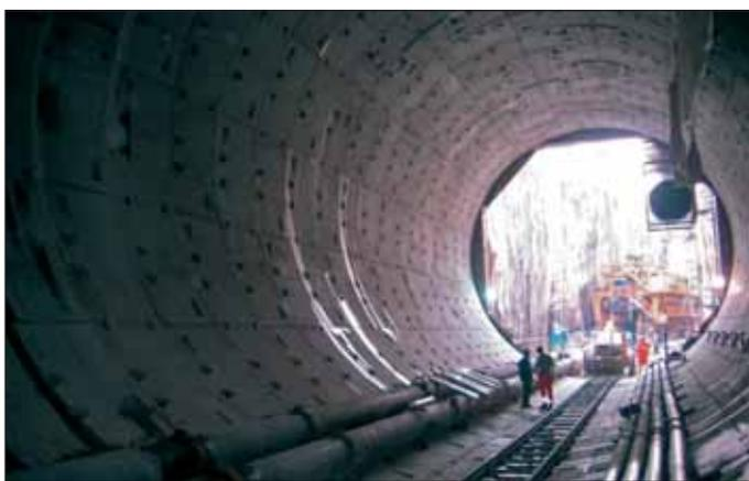
Рис. 7. Водопроявления в тоннеле
