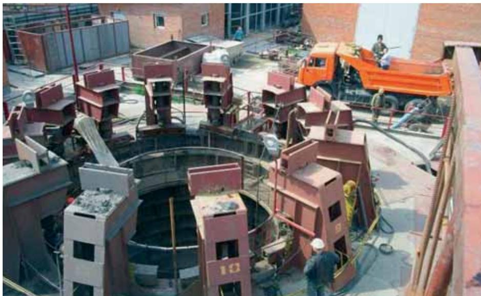
Проходка ствола № 463 способом опускной крепи
