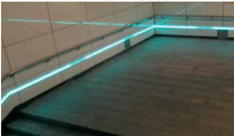
Световые ленты широко используются в метрополитенах в качестве экономичного источника света, а также для подсветки путей эвакуации в чрезвычайных ситуациях (рис. 7). Они хорошо заметны пассажирам.
