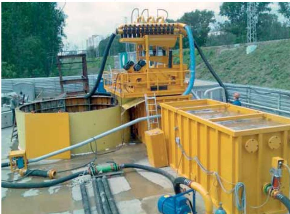
действующей ветки метро Филёвской линии была организована строительная площадка шахты № 458 и пройден ствол внутренним диаметром 5,6 м, служивший для проходки перегонных тоннелей. В дальнейшем ствол вошёл в состав вентиляционного узла на перегоне.
