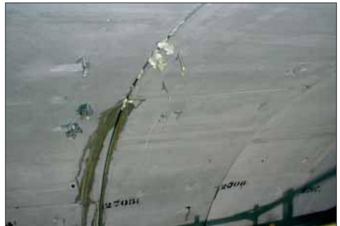
Рис. 4. Частичный выход пены из стыков блоков
