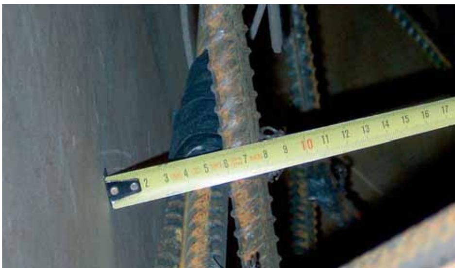
Между телом тоннеля и арматурной сеткой достаточно иметь зазор 20 мм
