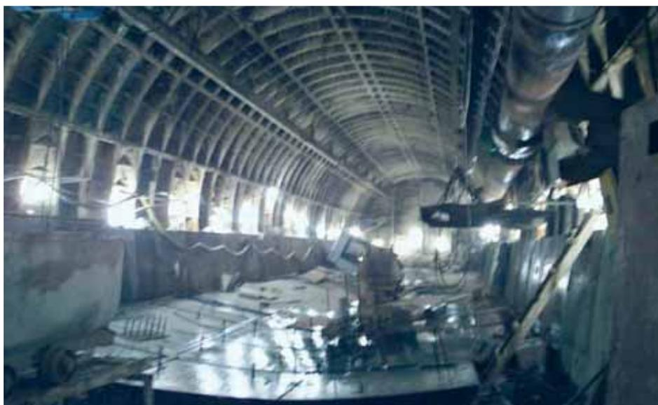
Сооружение вентиляционной камеры у ствола № 463
