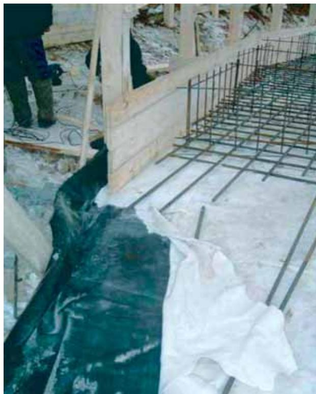
Фрагмент бетонного фундамента со слоем ЭПИКРОМа перед заливкой
