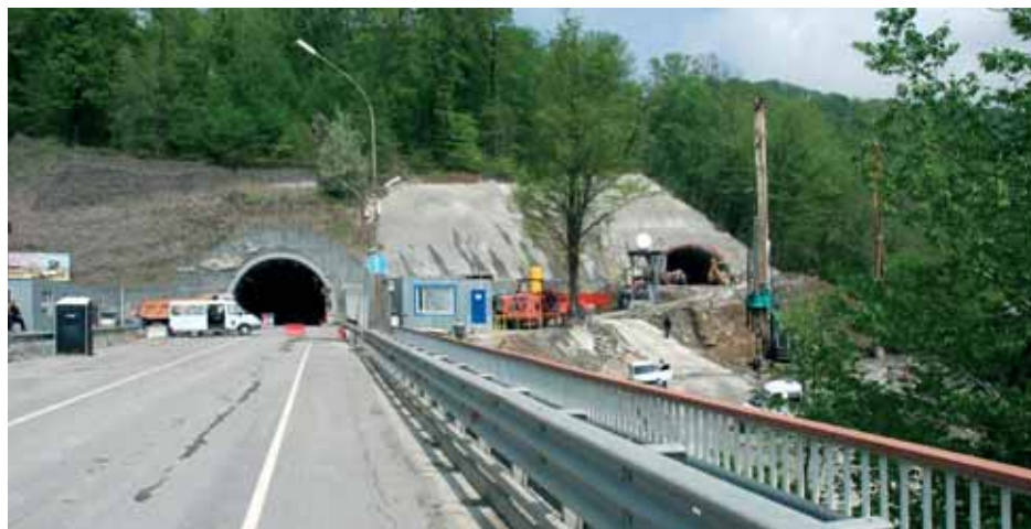
Портал существующего Мацестинского тоннеля (слева), южный портал строящегося тоннеля № 1 (справа)
