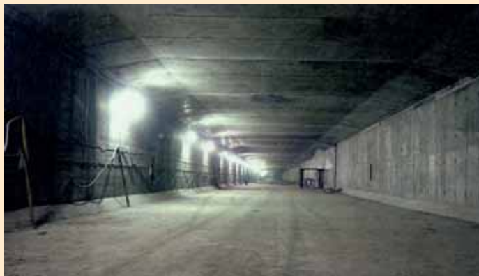
Строящийся автодорожный тоннель
