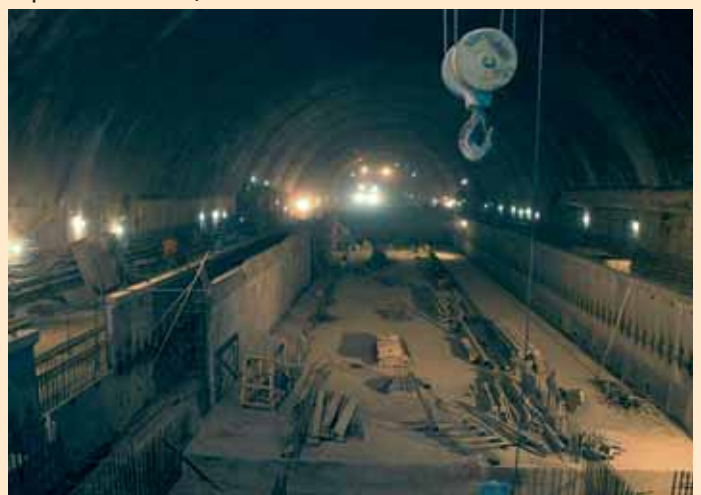
Строительство станции «Чкаловская»
