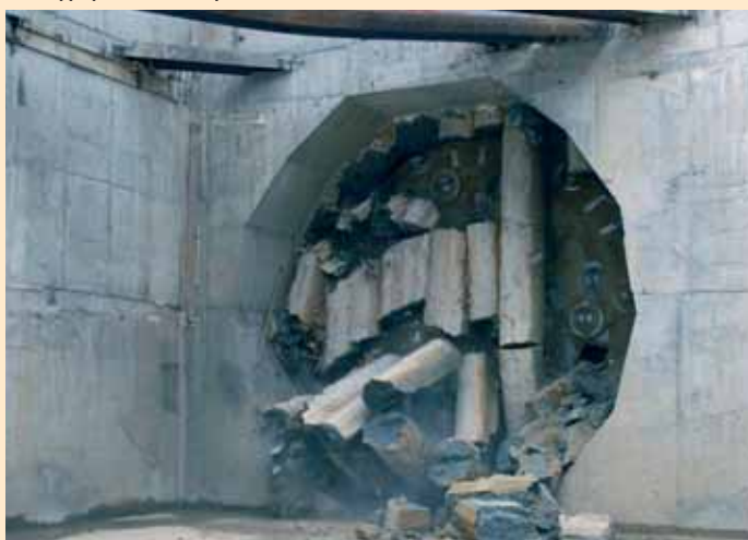
Выход щита на станции «Чкаловская»
