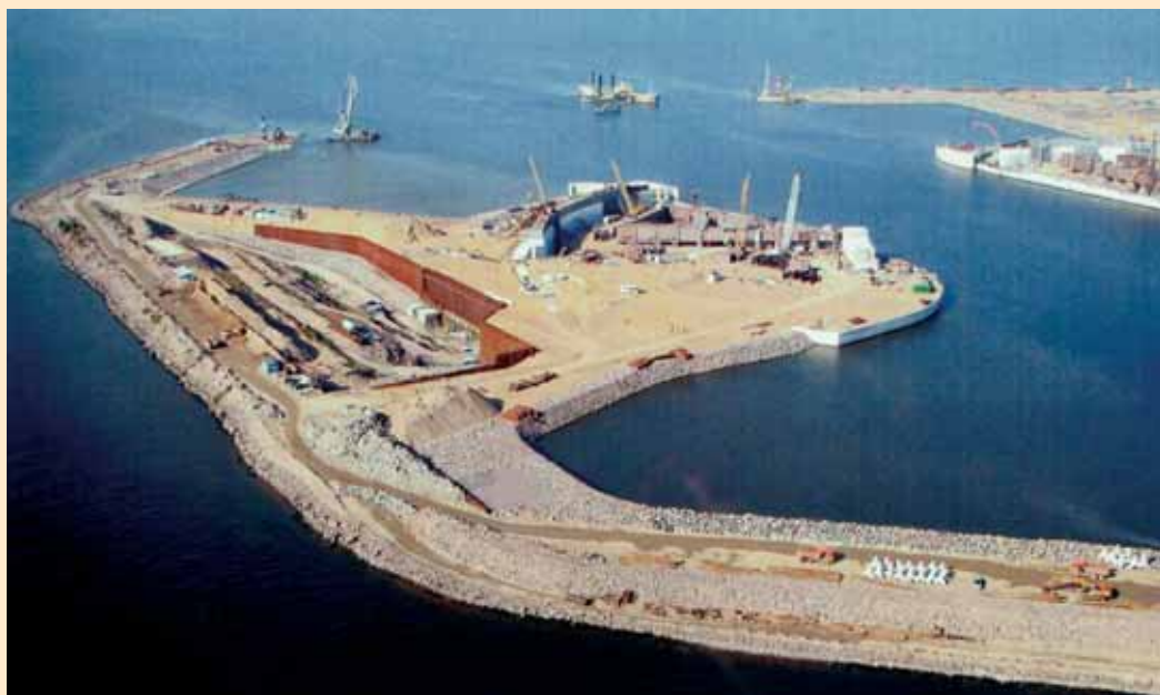
Вид на локальный котлован Д-3 секции тоннеля Т5-Ю
