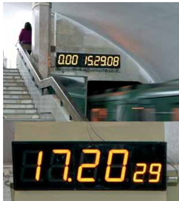
Новая цифровая часовая станция единого времени
