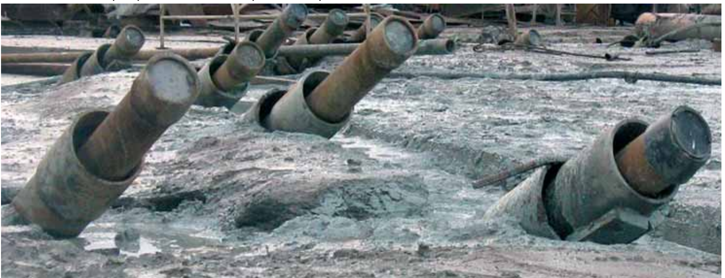
Рис. 3. Устья скважин перед проведением инклинометрических замеров
