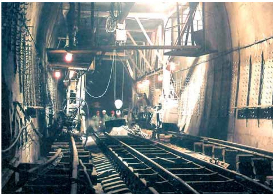
Устройство изоляции и укладка ж.-д. пути Западного портала Северомуйского тоннеля
