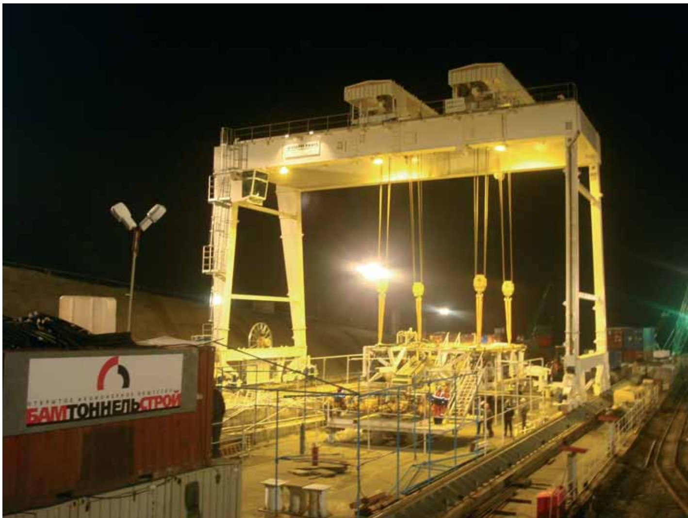
Портальный кран на тоннельном комплексе № 5
