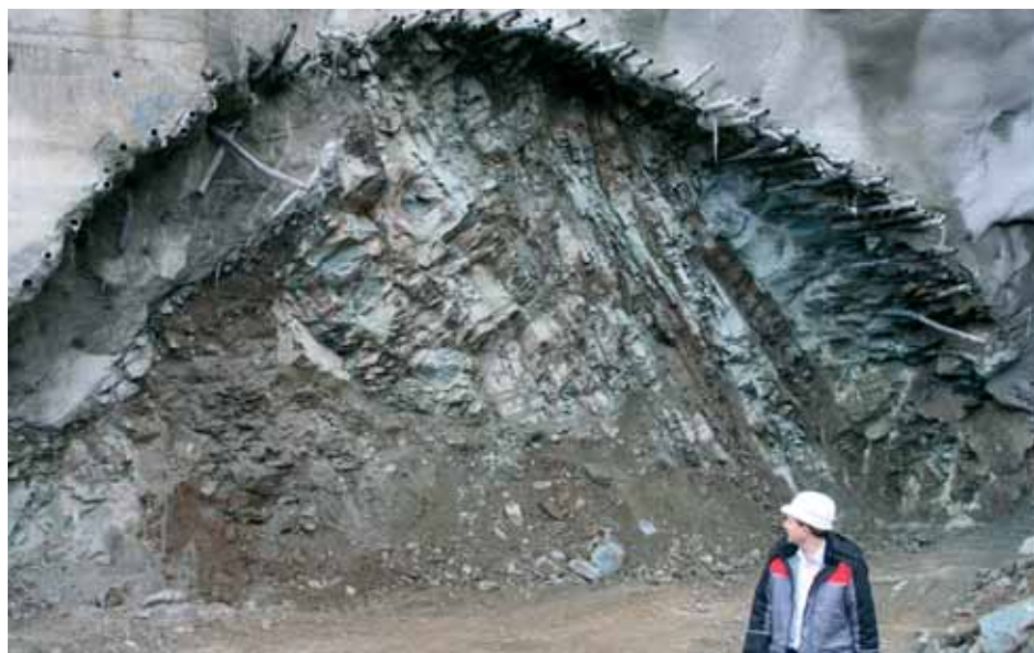
Врезка автодорожного тоннеля № 3
