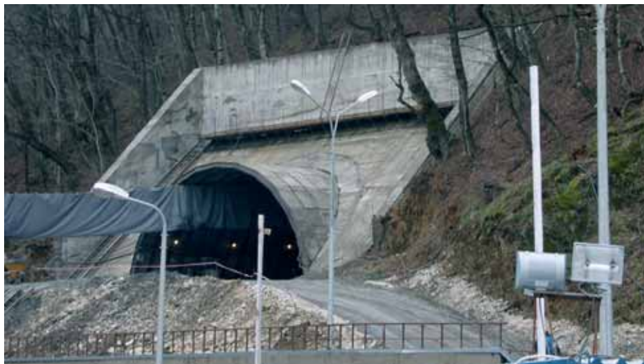
Южный портал железнодорожного тоннеля № 6
