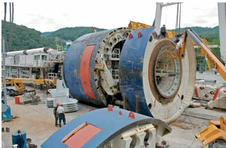
Монтаж ТПМК Seli-Lovat RME-394GS
