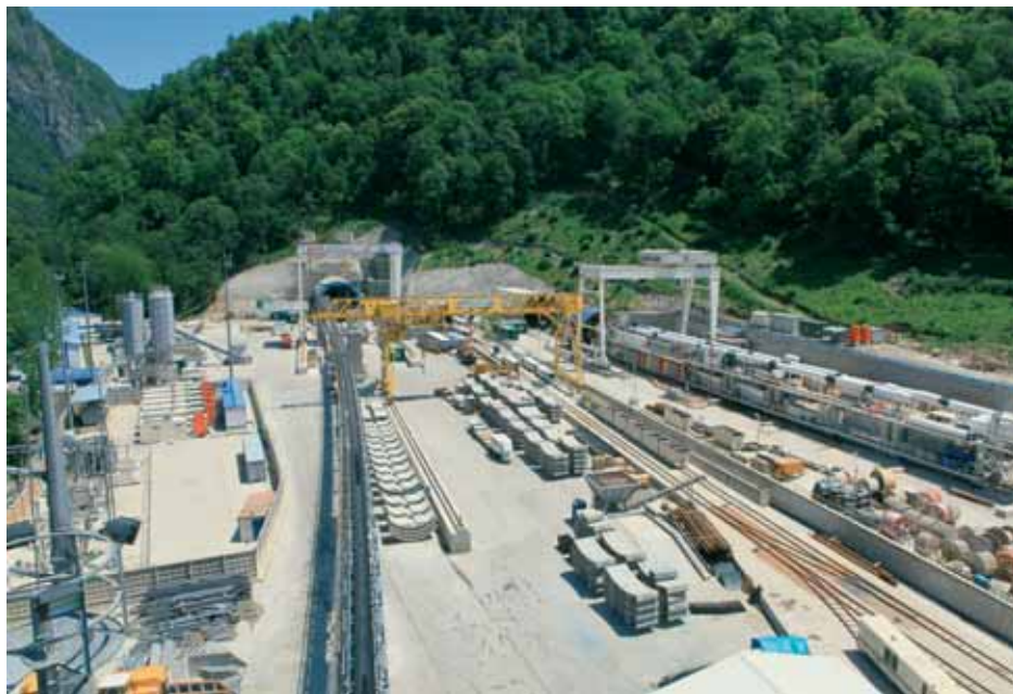
Панорама строительной площадки тоннельного комплекса № 3
