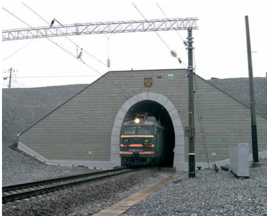
Новый Лагар-Аульский тоннель
