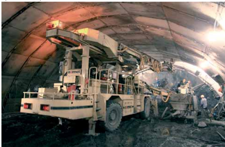
Проходка автодорожного тоннеля № 3
