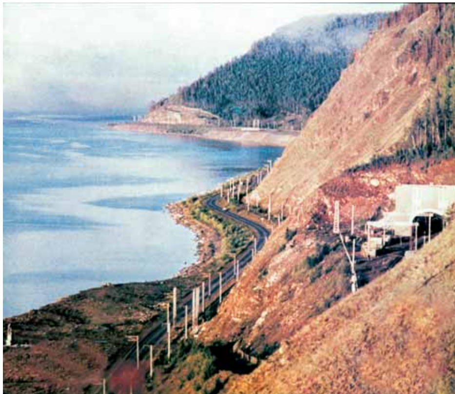
Восточный портал Мысового тоннеля
