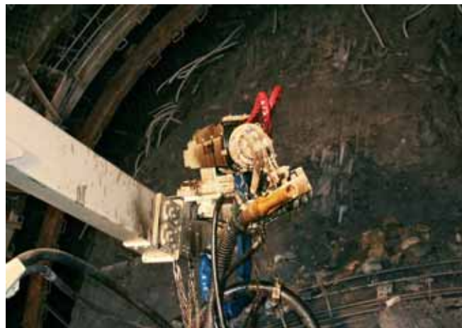
Устройство временного крепления в автодорожном тоннеле № 3
