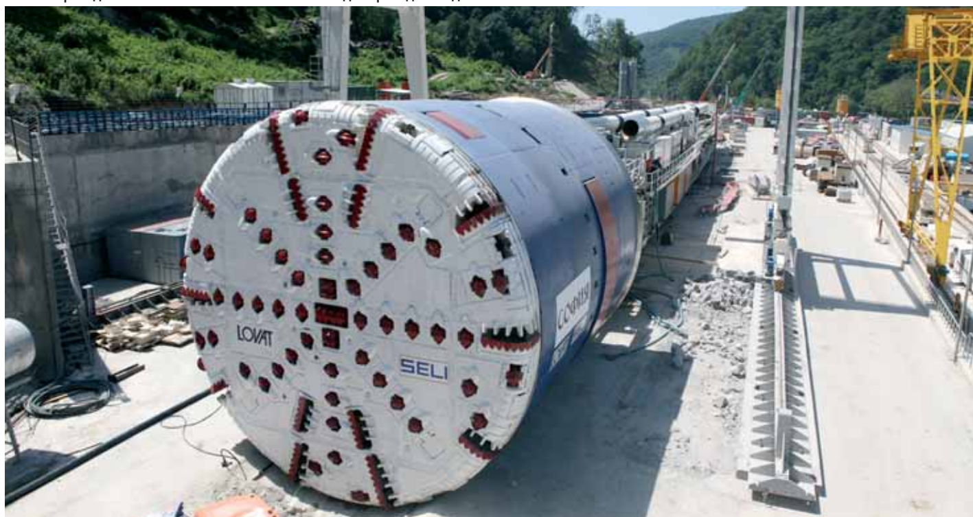
Тоннелепроходческий комплекс Seli-Lovat RME 394GS для проходки ж.-д. комплекса № 3
