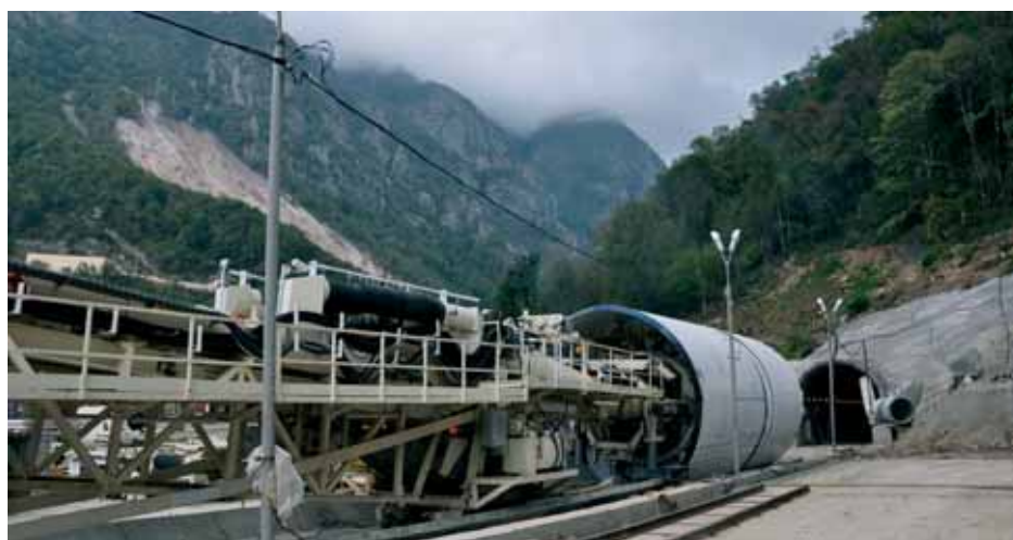
ТПМК Lovat RM 243DS для проходки штольни № 3 тоннельного комплекса № 3
