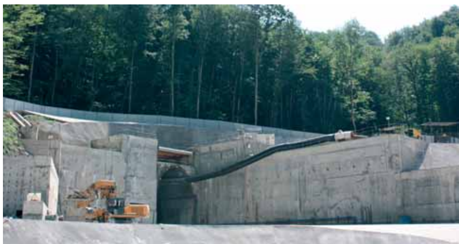
Южный портал железнодорожного тоннеля № 4
