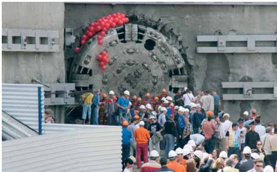
Окончание проходки штольни и выход ТПМК LOVAT RME 232 SE
