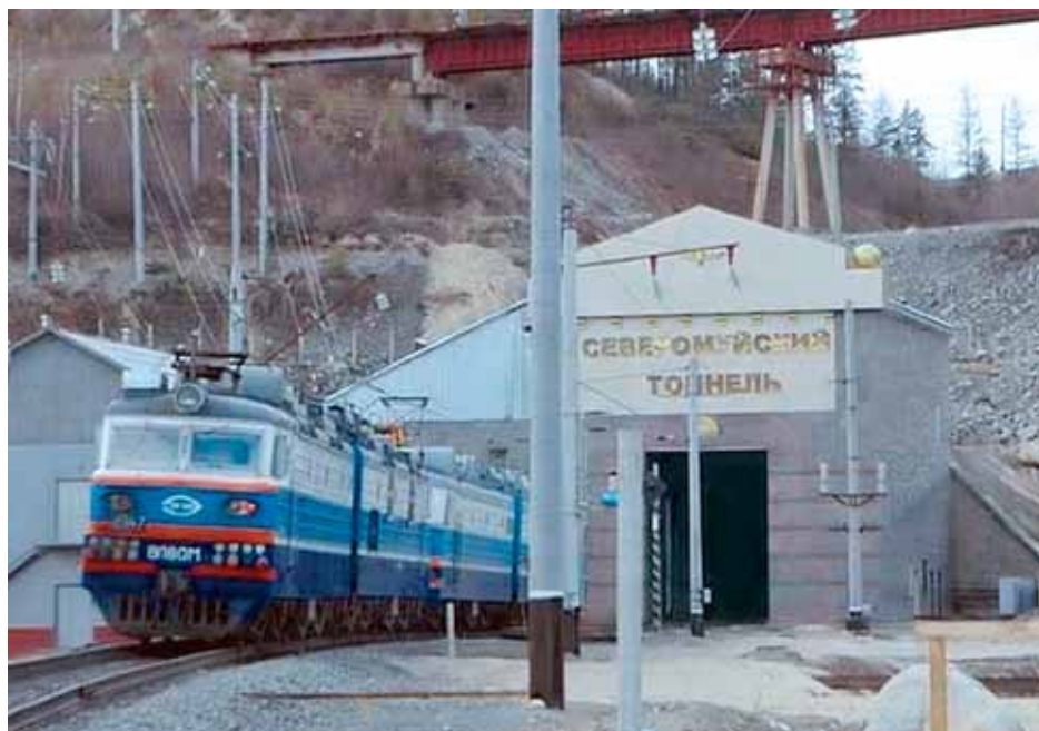
Восточный портал Северомуйского тоннеля
