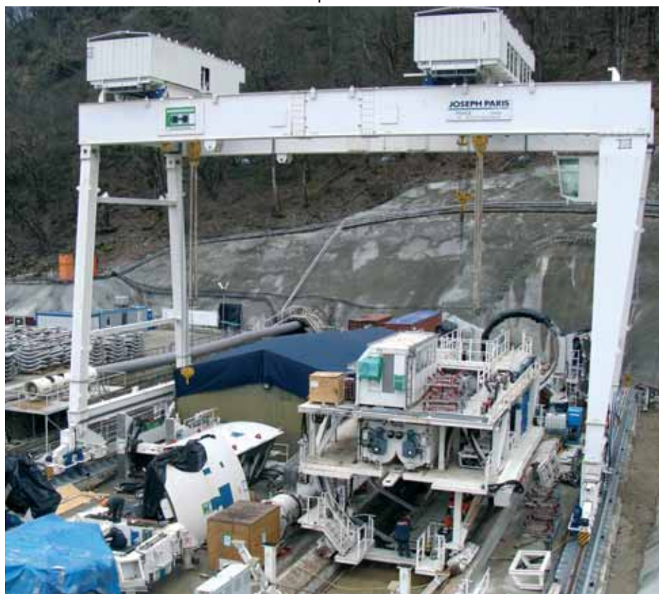
Монтаж ТПМК Herrenknecht 10690 на Южном портале тоннельного комплекса № 5
