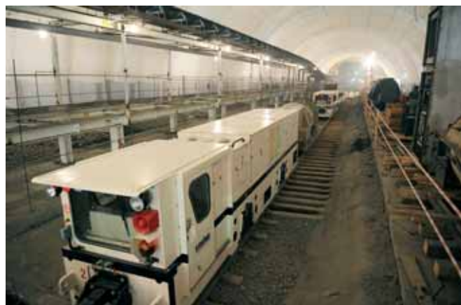
Локомотив SCHOMA CFL-180 при проходке Кузнецовского тоннеля
