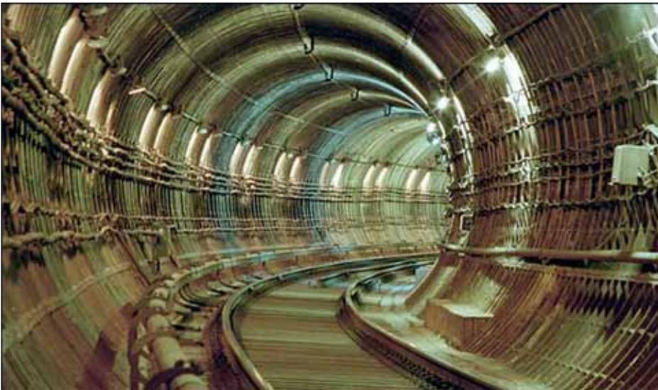
Рис. 3. Общий вид освещения тоннеля светильниками с лампами накаливания
