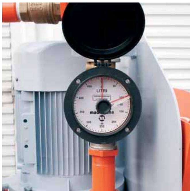
Рис. 5. Расходомер для загрузки воды
