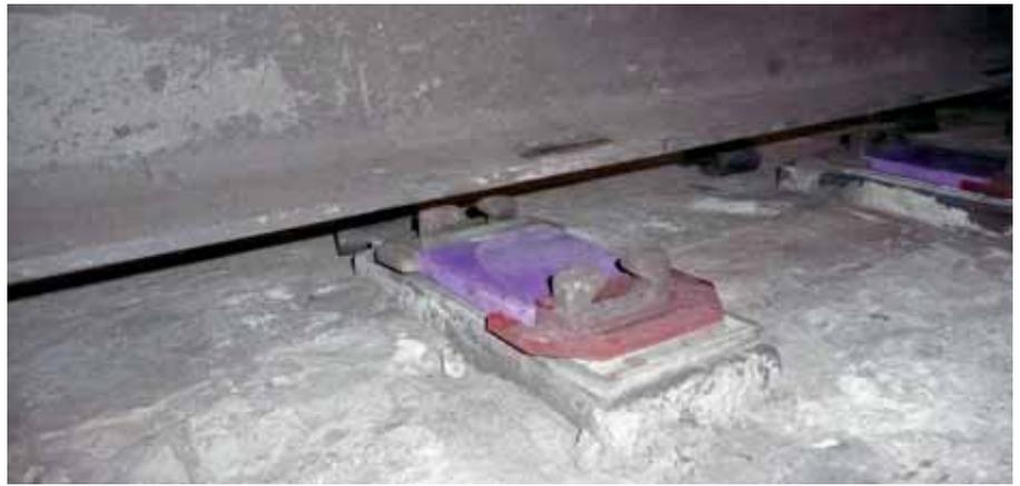
**Виброзащитные подрельсовые подкладки**
