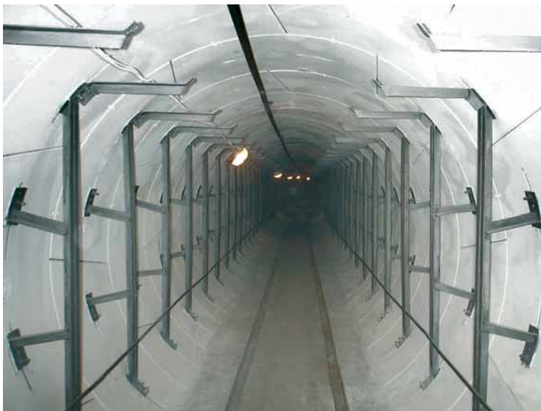
Рис. 4. Готовый участок кабельного тоннеля от подстанции «Угреша»
