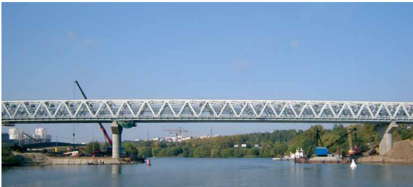
Мостовой переход через реку Москву
