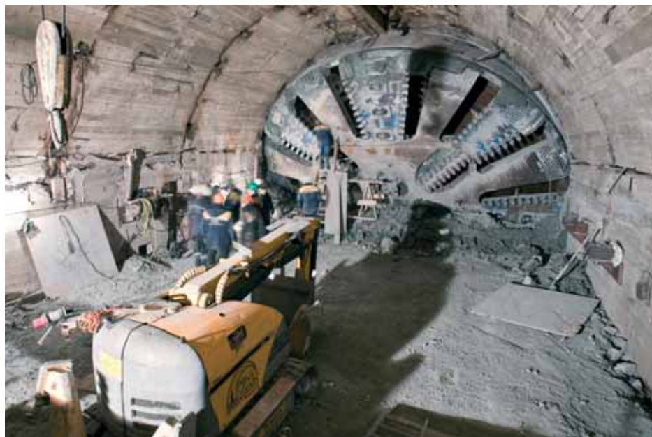
Выход тоннелепроходческого комплекса «Аврора» на ст. «Обводный канал»
