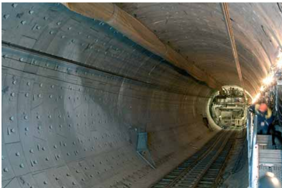
Участок готового тоннеля
