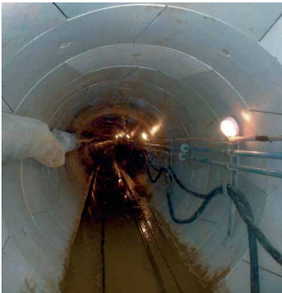
Рис. 5. Участок Царицынского канализационного тоннеля с обделкой из высокоточных железобетонных блоков с полимерной футеровкой
