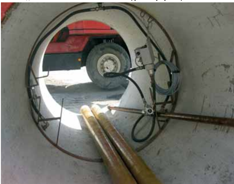
Рис. 6. Подготовка тоннельной железобетонной трубы к спуску в стартовый котлован
