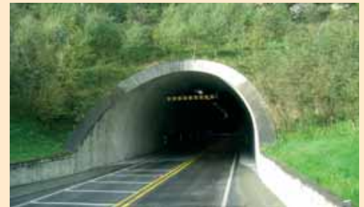
Портал автодорожного Лэрдальского тоннеля
