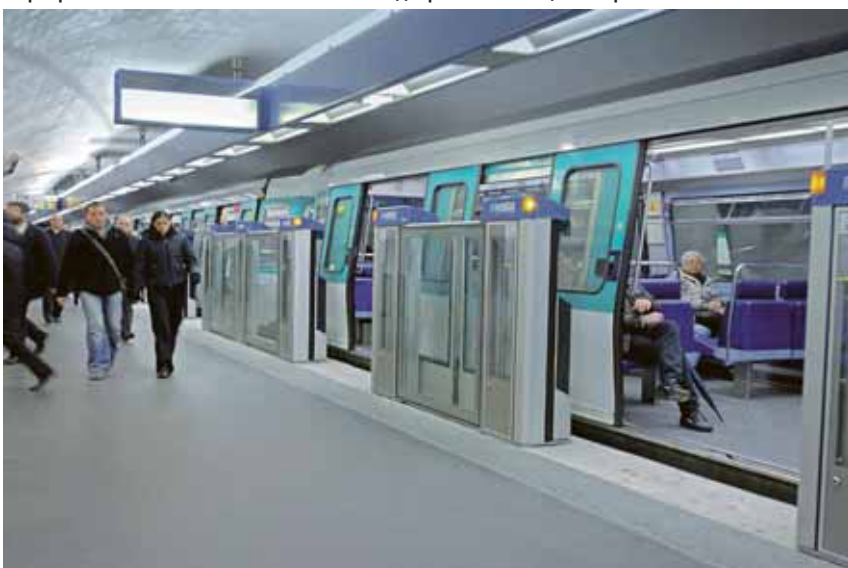
Барьеры «Screen doors» с автоматическими дверями на станции метрополитена
