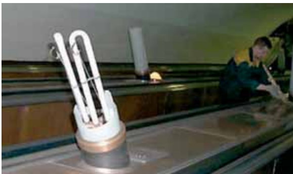
Рис. 2. Разбитый светильник и технология ликвидации акта вандализма. (После футбольного матча на эскалаторах остается 30 % целых светильников. В 2006 г. в метро было заменено 1148 разбитых плафонов)
