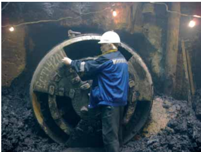
Рис. 4. Выход щита в финишный котлован НКД-0
