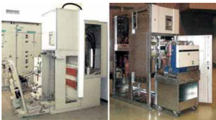
Разделение оборудования подстанции на функциональные блоки
