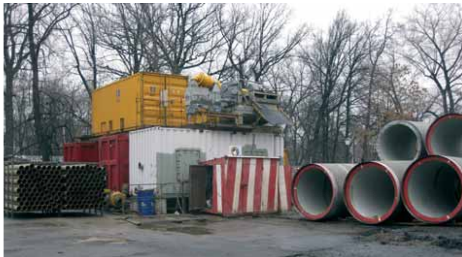
Рис. 1. Строительная площадка у входного котлована К1
