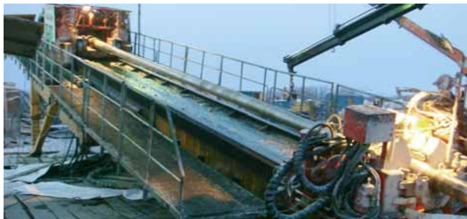
Площадка для бурения второй скважины
