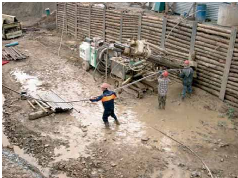
Рис. 9. Установка фиберглассового анкера в скважину, г. Екатеринбург
