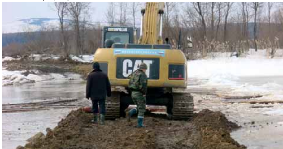
Насыпь на льду через протоки
