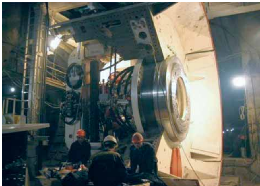
Демонтаж ТПМК в стесненных условиях
