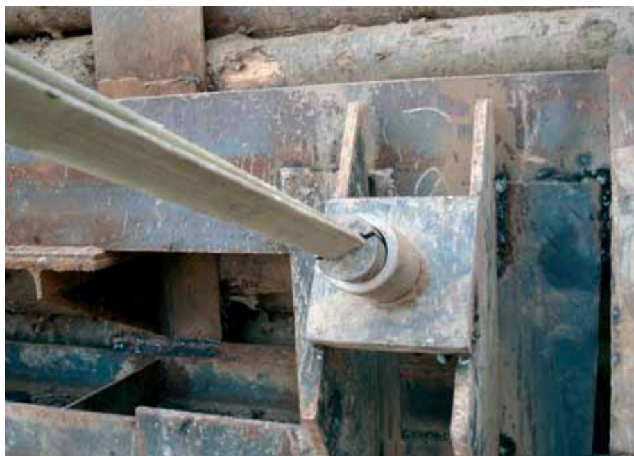
Рис. 10. Крепление фиберглассового анкера к металлическому обвязочному поясу
