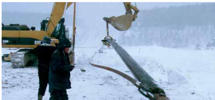
Совместная протяжка газового дюкера и дюкера под связь
