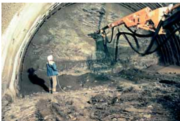
Нанесение набрызг-бетона установкой Sika-PM500
