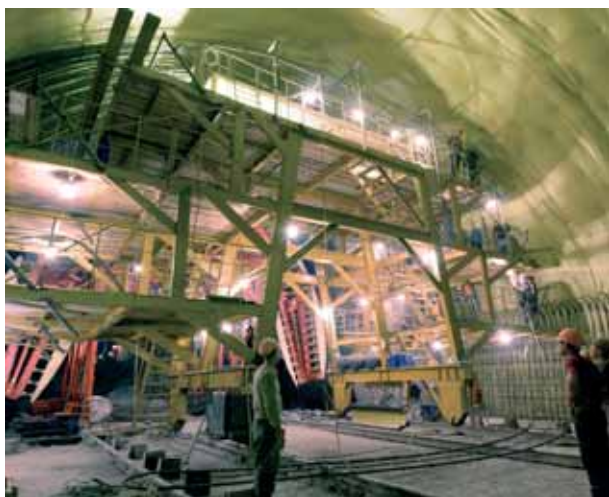
Монтаж гидроизоляционной мембраны толщиной 1,5 мм
