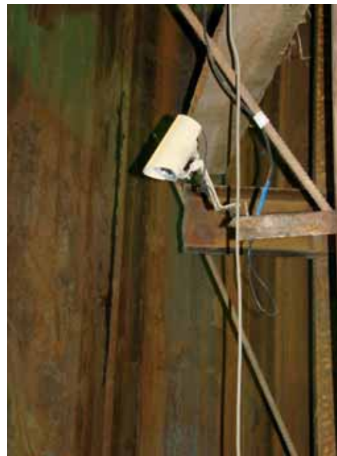
Рис. 3. Видекамера, расположенная непосредственно в котловане
