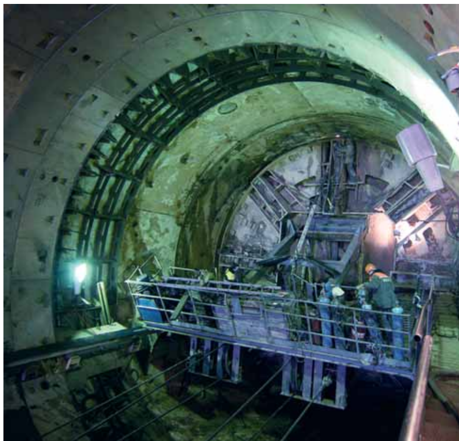
Процесс демонтажа комплекса в тоннеле
