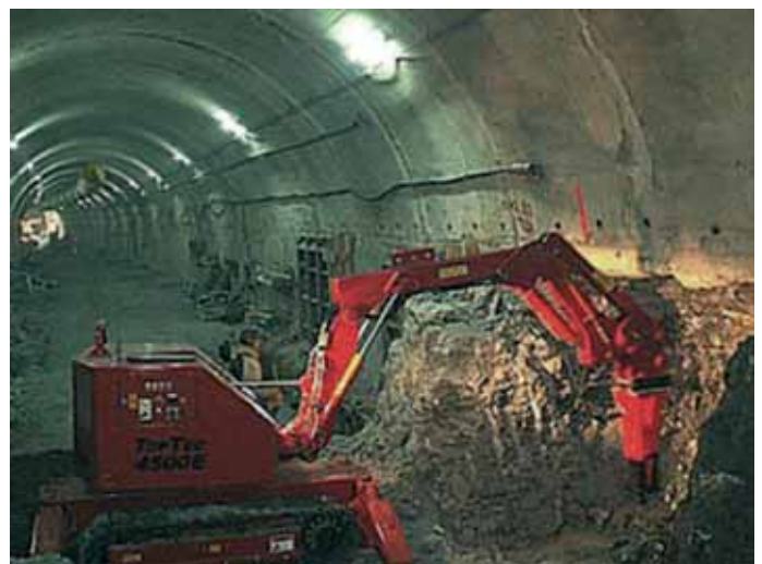
На строительстве автострады М-30 в Испании
