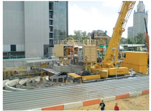
Рис. 3. Вид строительной площадки
