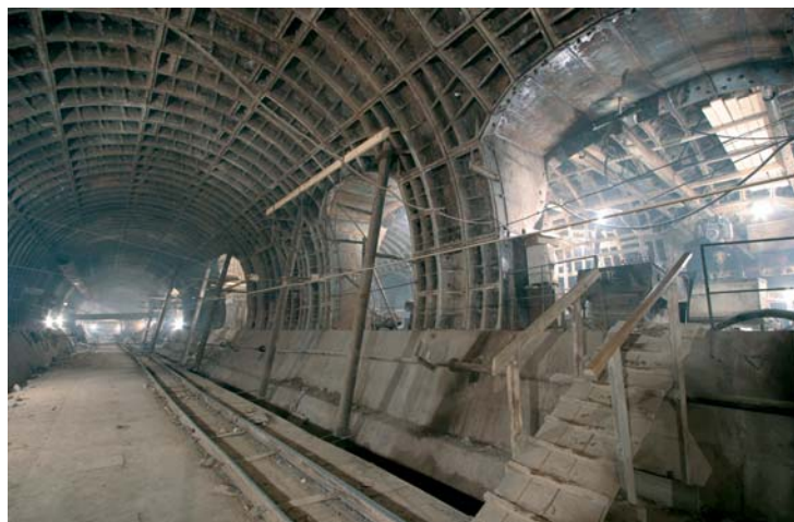
Станция «Сретенский бульвар» в период возведения
