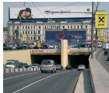
1960 г. – транспортный тоннель на пл. Маяковского
