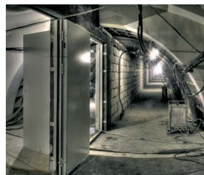
2003–2005 г. – сервисный тоннель Краснопресненской магистрали
