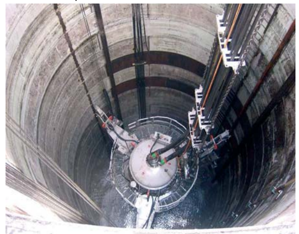
Рис. 6. Стволопроходческая машина в стволе
