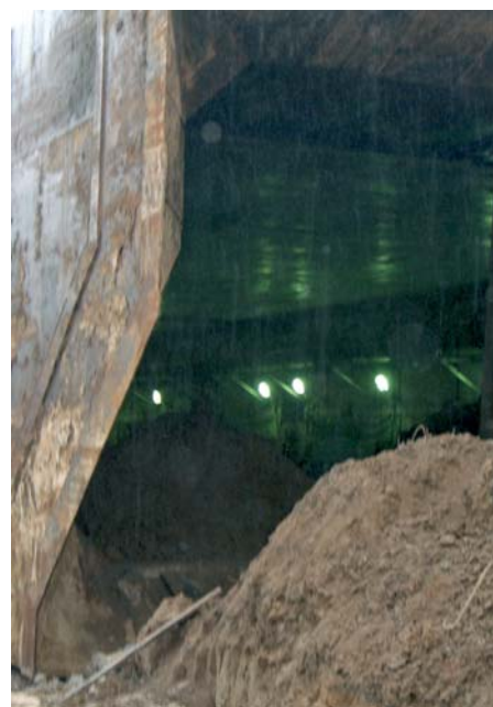
Нож режущего агрегата для продавливания железобетонной тоннельной секции
