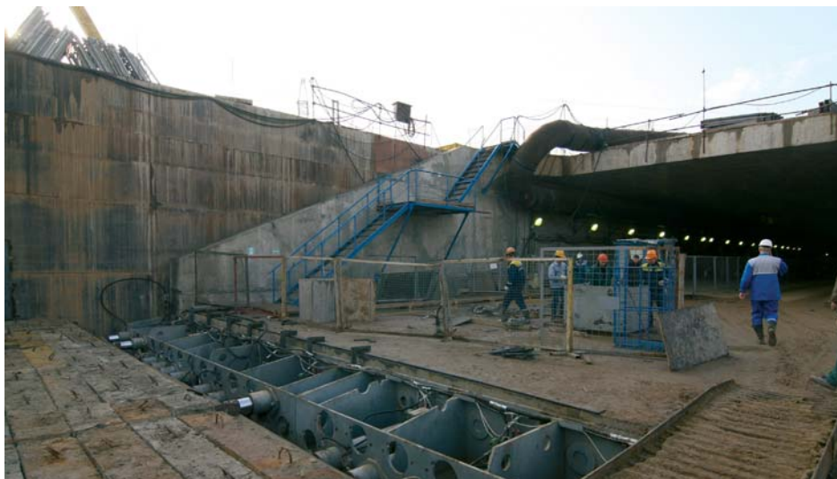
Сооружение тоннеля методом продавливания на участке 4-го транспортного кольца в Москве
