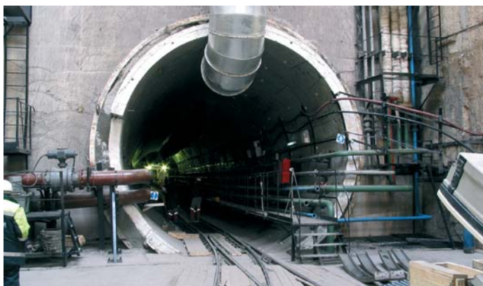
Портал сервисного тоннеля Краснопресненской магистрали
