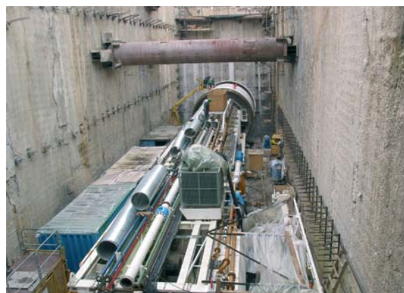
Монтаж тоннелепроходческого комплекса для проходки сервисного тоннеля в Серебряном Бору
