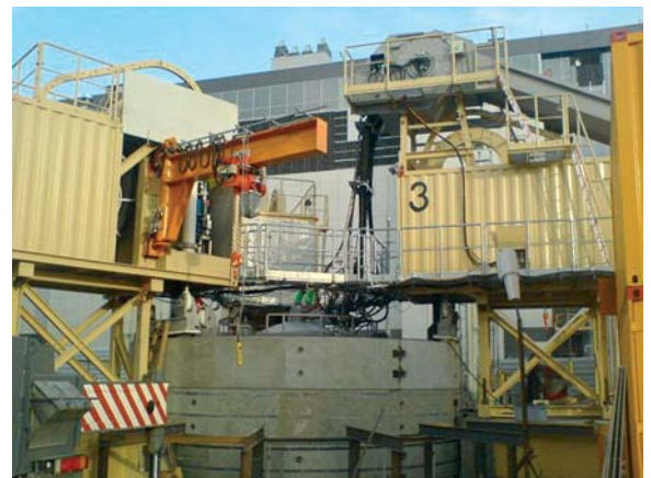
Рис. 4. Крановый блок с тубинговой балкой, обделка, опускные контейнеры
