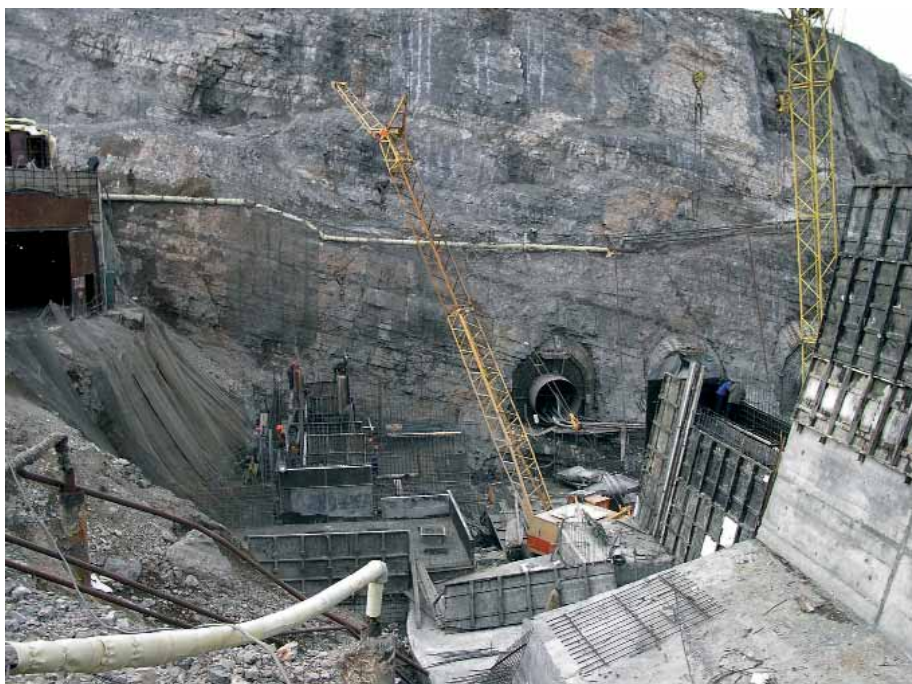
На строительстве сооружений Юмагузинского гидроузла
