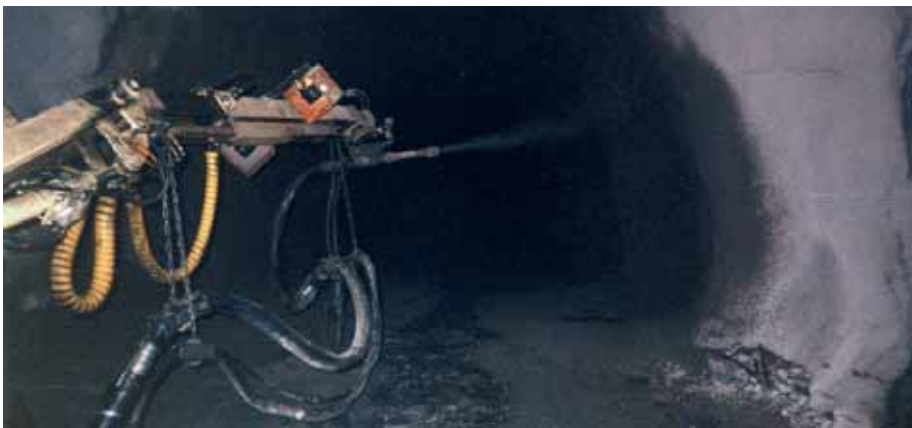
Процесс мокрого торкретирования в горной выработке
