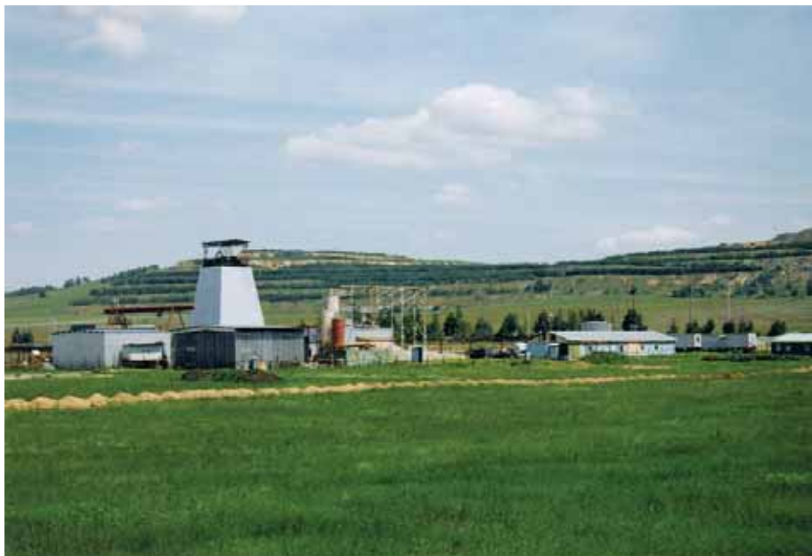
Резвол вентиляционный рудника «Чебачий»
