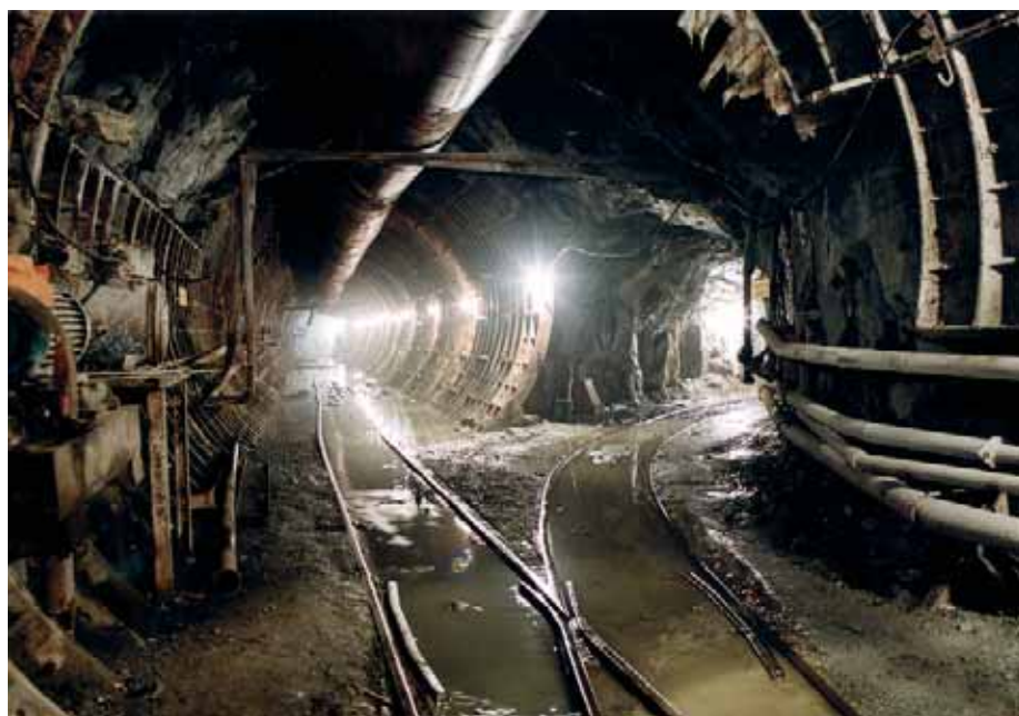
На строительстве Челябинского метрополитена
