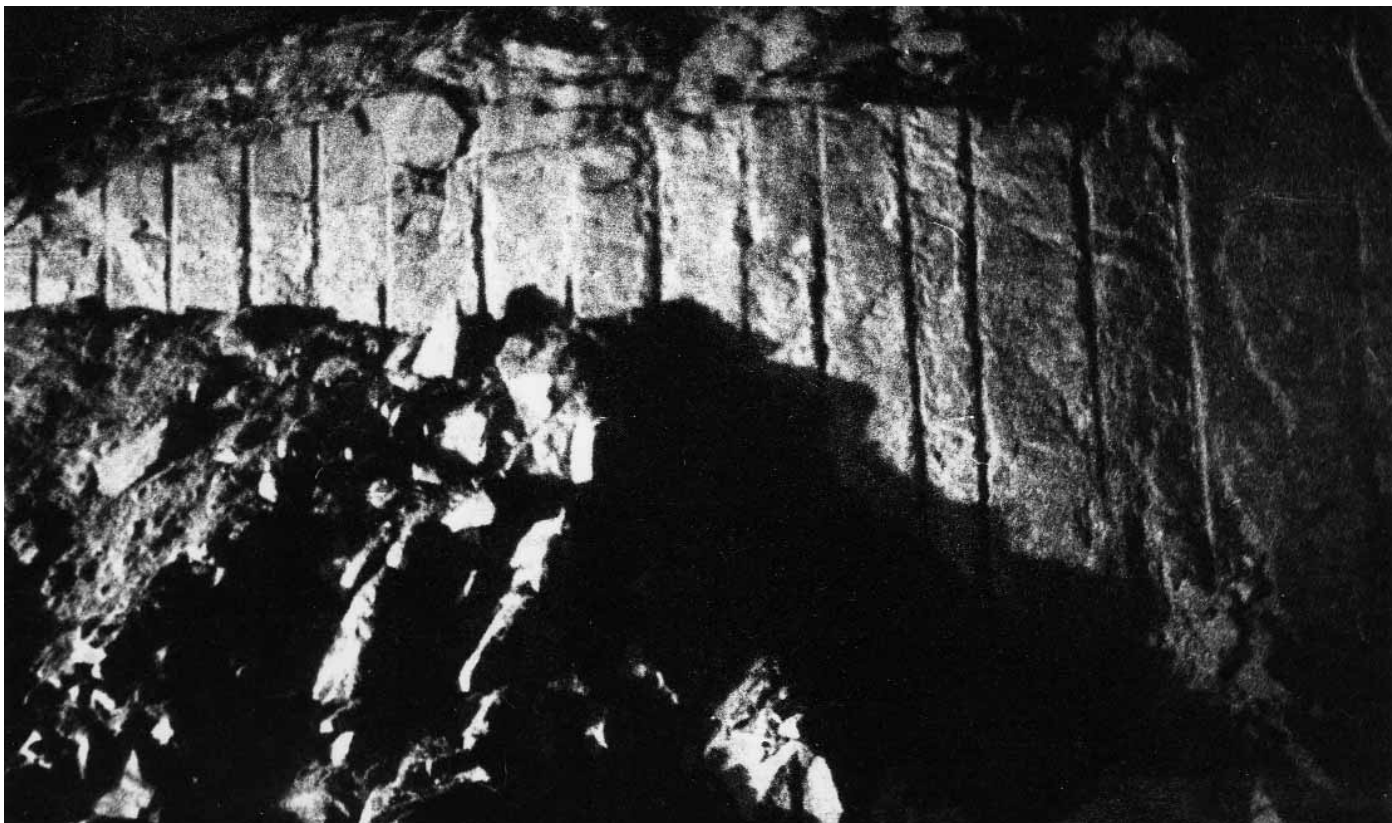
Использование скважинной обойки с контурным взрыванием при разработке ядра крупногабаритного сооружения в скальных породах
