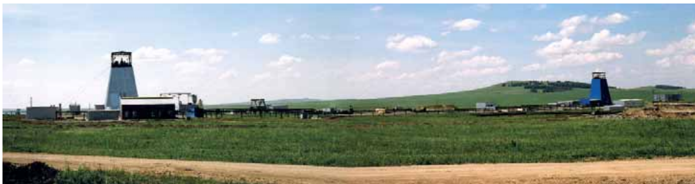
Панорама строительной площадки на руднике «Чебачий»
